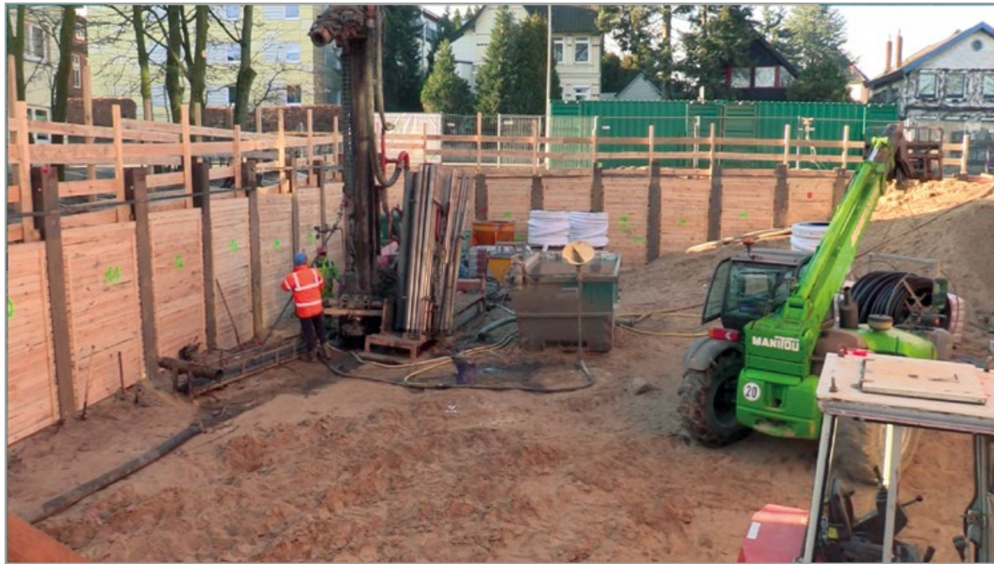
Ende Januar 2017 werden in der Baugrube für den Neubau Haus 46 c die ersten sechs Tiefbohrungen für die Nutzung der Geothermie durchgeführt.
