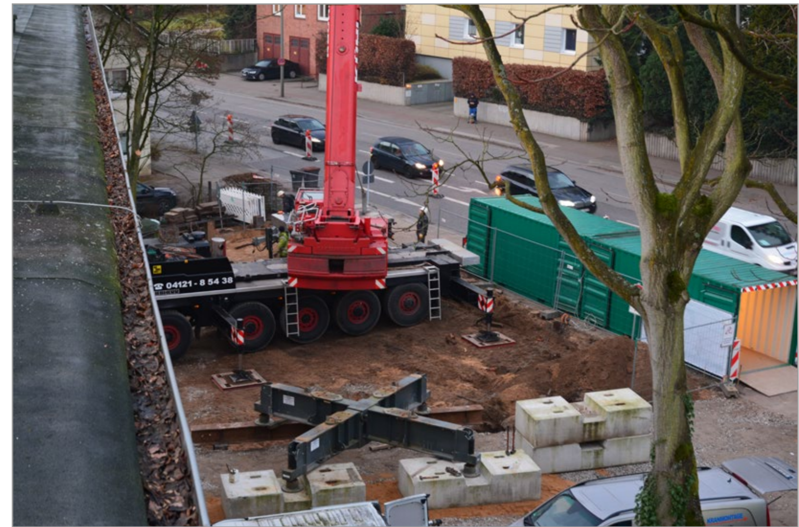
Am 21.12.2016 wird der Kran an der Hummelsbütteler Landstraße 46 c aufgebaut. Zwei der vier Kranfüße stehen hierbei auf dem Verbau.
