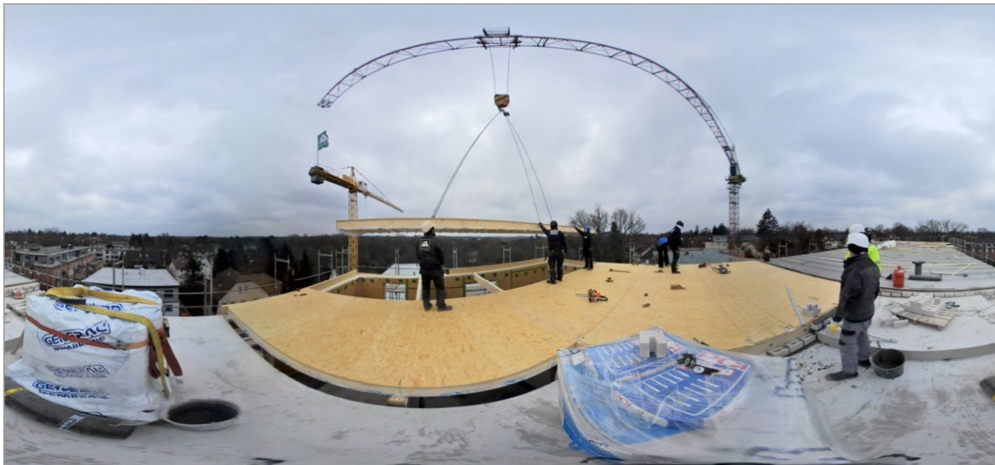
Standbilder aus dem 360°-Zeitrafferfilm vom Aufbau des Staffelgeschosses auf dem Haus Nr. 46 a-b
