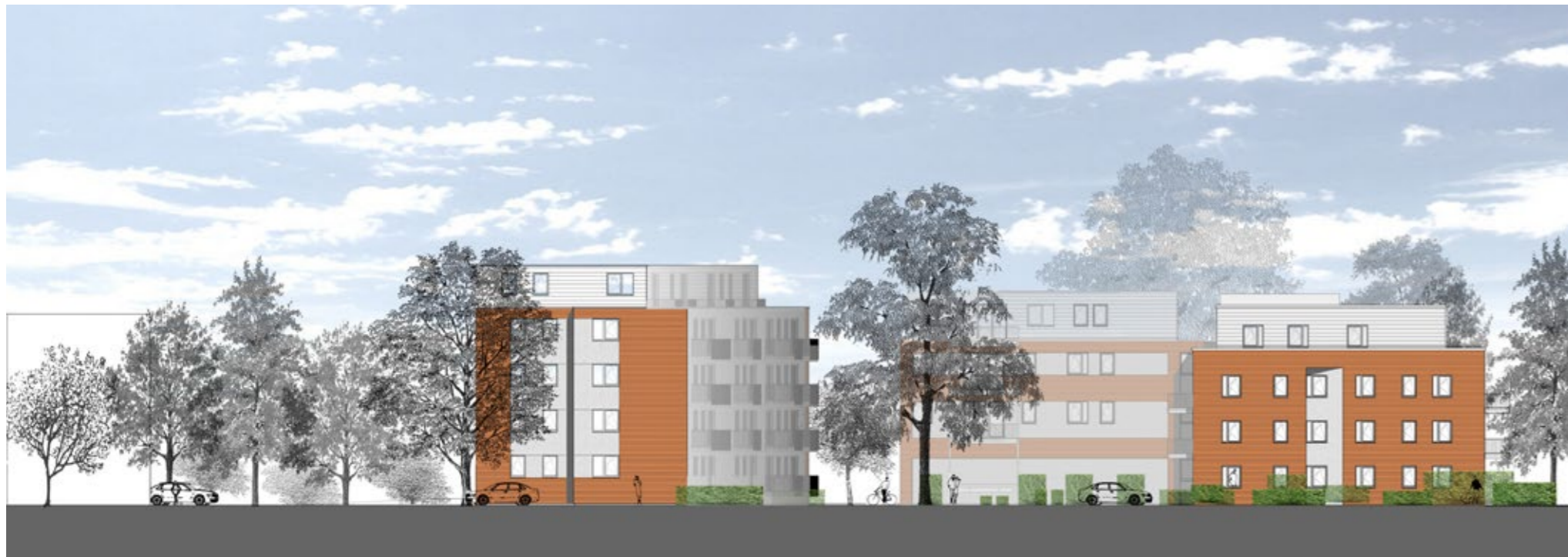
Ansicht von Nordwest, Hummelsbütteler Landstraße
