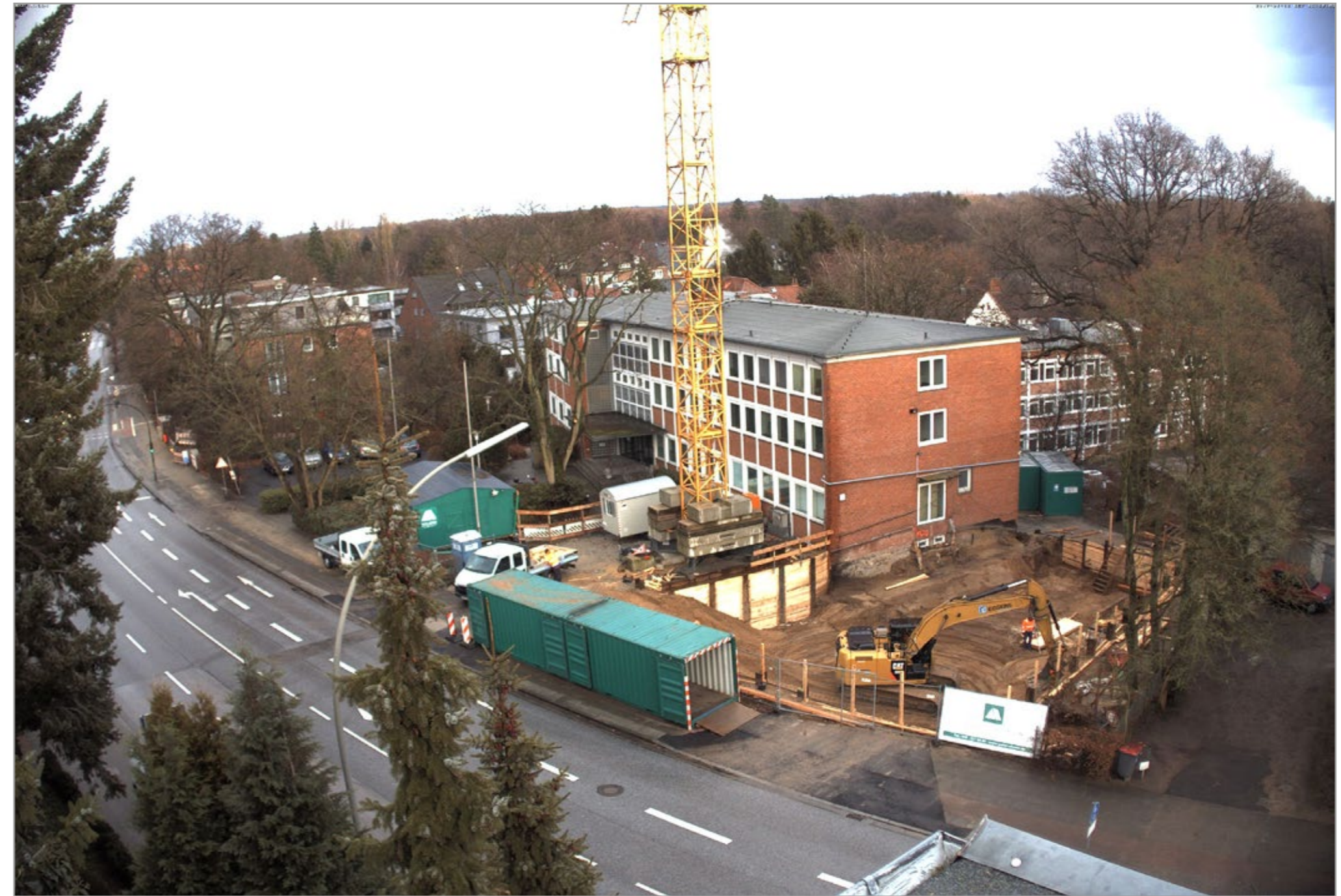
Auf dem ehemaligen Mitarbeiter-Parkplatz wird die Baugrube für den Anbau bei der Nr. 46 c ausgehoben.
