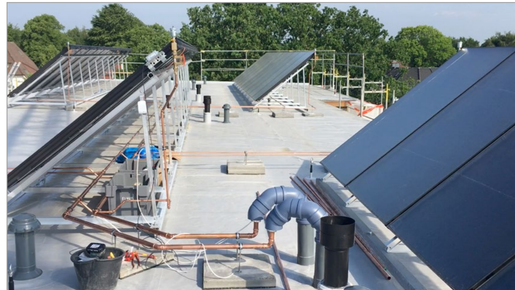
Auch auf dem Dach von Haus 46 a-b werden die Solarthermie-Elemente montiert
