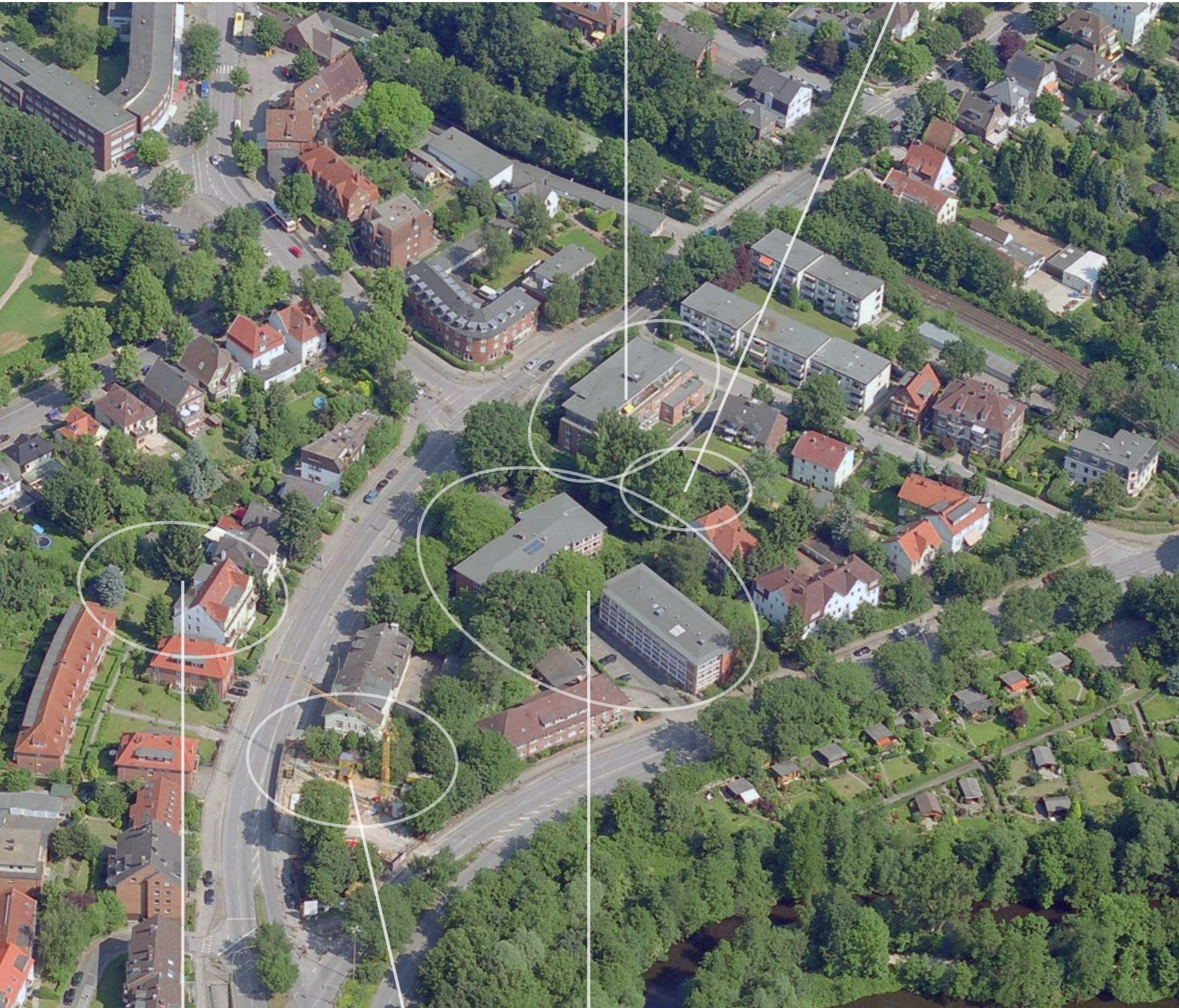
Baufeld Hummelsbütteler Landstraße 47 und 47 a
