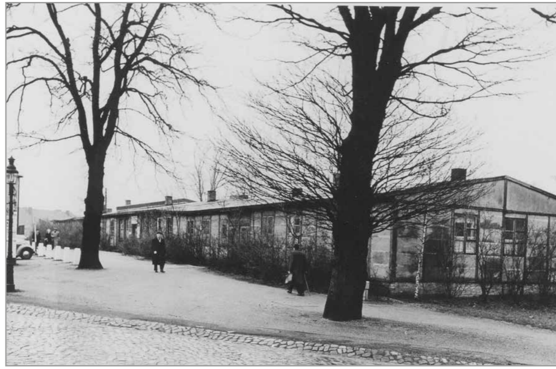
Teile des Ortsamtes Fuhlsbüttel um 1950 in den behelfsmäßigen Baracken an der Hummelsbütt- teler Landstraße
