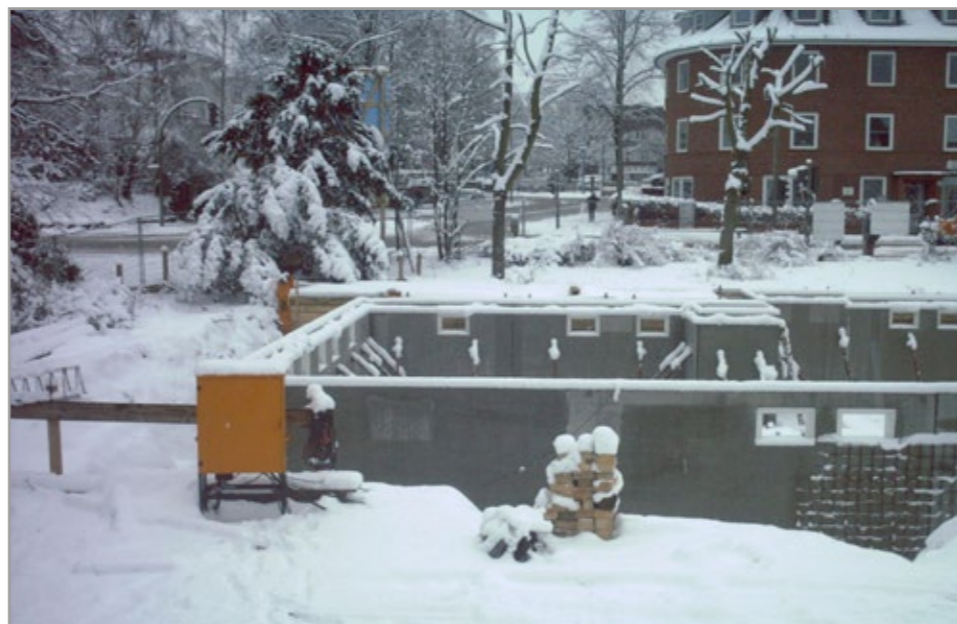
Wintereinbruch: Ende Januar 2004 legt Schneefall die Bauarbeiten still.
