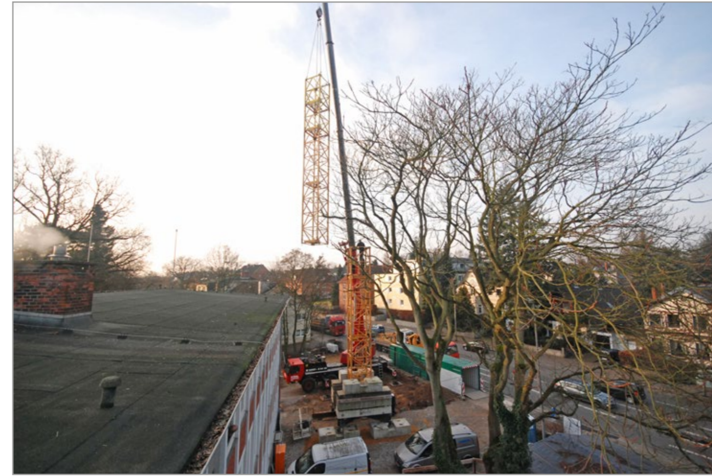
Am 21.12.2016 wird der Kran an der Hummelsbütteler Landstraße 46 c aufgebaut. Zwei der vier Kranfüße stehen hierbei auf dem Verbau.
