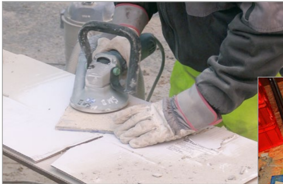
Der Ansetzmörtel auf den Rückseiten der Fliesen wird mit der Flex entfernt.
