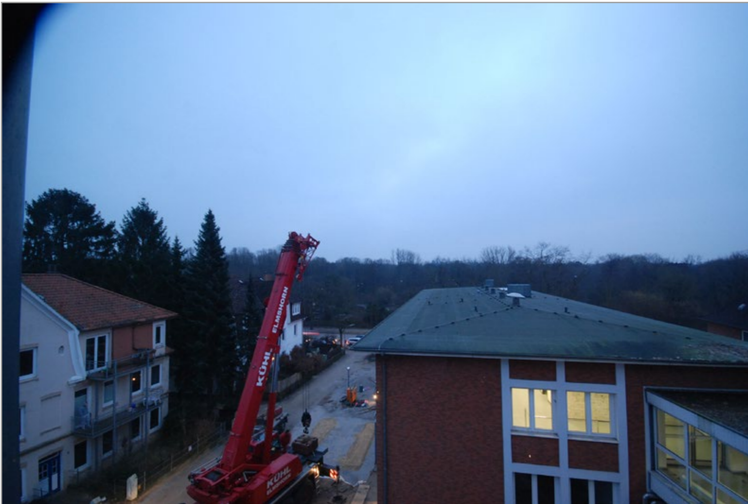
Am 9. Februar 2017 wird am Trift der zweite Kran aufgebaut
