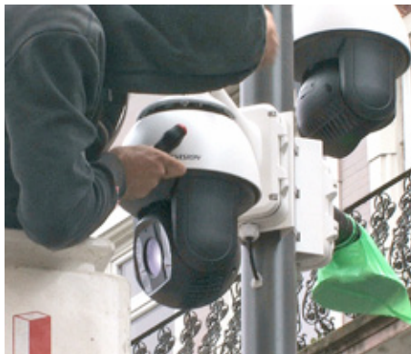
Montage der Überwachungskameras Foto: © Ulli Gehner
