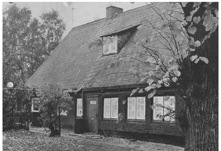
Foto 1. Das alte Haus Nr. 21 von der Südseite
