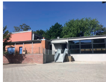
Neue Sporthalle an der Karstenstraße
