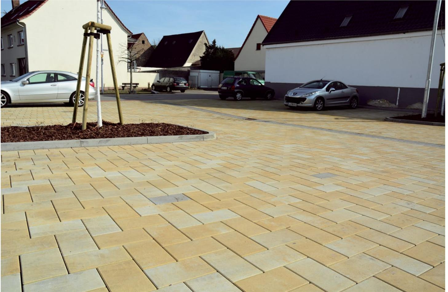
Lupenrein: Gemäß der DIN 18318 ergeben sich bei dem Steinsystem COMBICONNECT stets normgerechte Fugenbreiten von 4 mm. (Foto: Beton-Pfenning)
