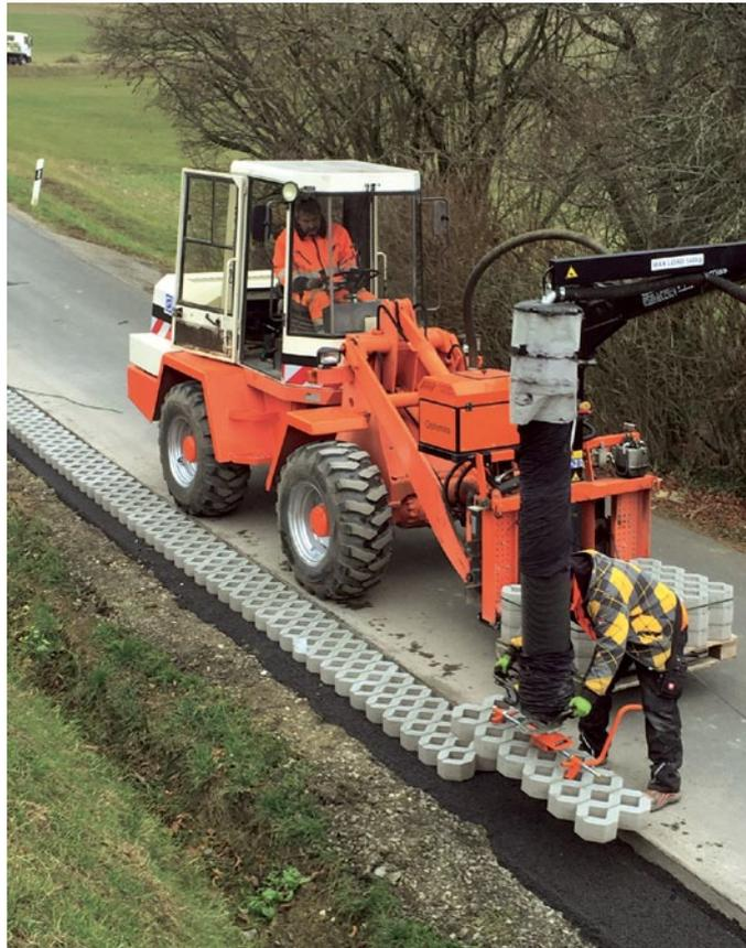
Mit Hilfe des Optimas Vacu-Lift wird das Verlegen von Rasengittersteinen zu einer leichten Angelegenheit. (Foto: Optimas GmbH)
