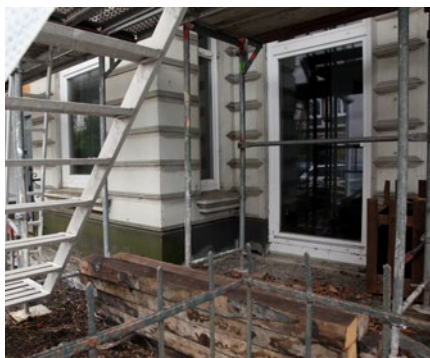
Modernisierung kann strapaziös aber nicht mehr unbegrenzt teuer sein.
