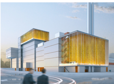
Zentrum für Ressourcen und Energie, kurz ZRE
