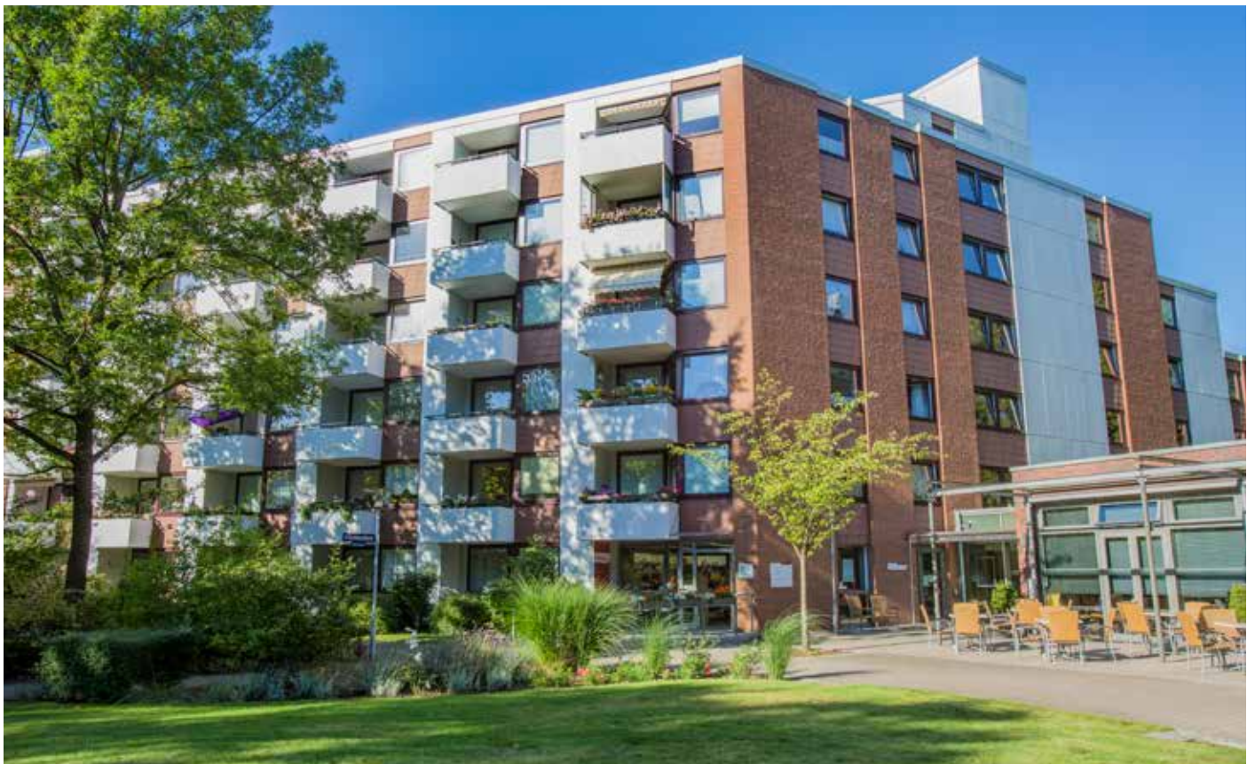
Auf dem Dach des Edmund-Matthaei-Hauses soll eine Wohn-Pflege-Gemeinschaft entstehen. Foto: Karin Desmarowitz
