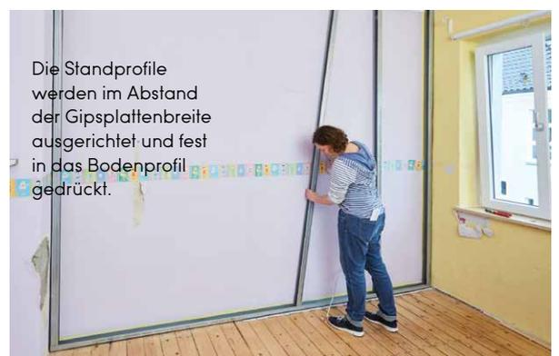
Die Standprofile werden im Abstand der Gipsplattenbreite ausgerichtet und fest in das Bodenprofil gedrückt.
