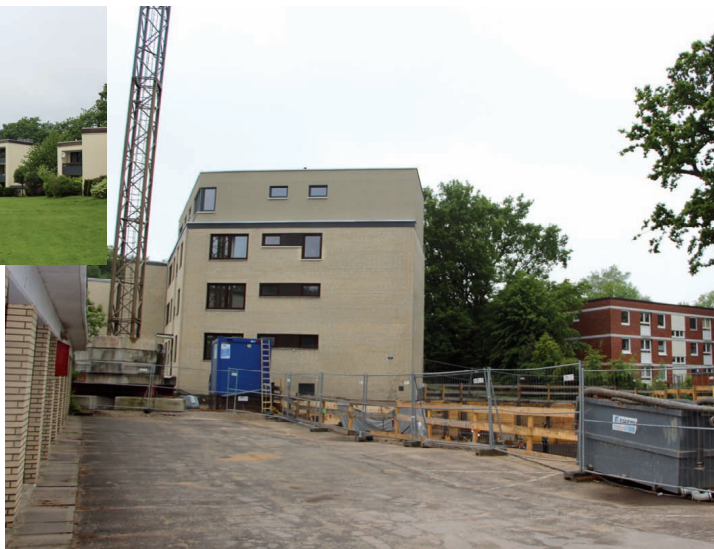
Nachverdichtung am Wesselburer Weg/Bockhorst hat begonnen
