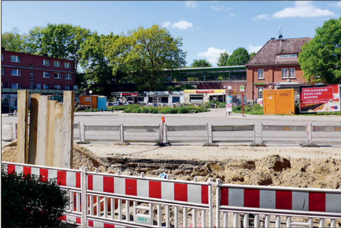
Die Bauarbeiten zur Umgestaltung des Ostpreußenplatzes haben begonnen. Foto: Thorsten Richter
