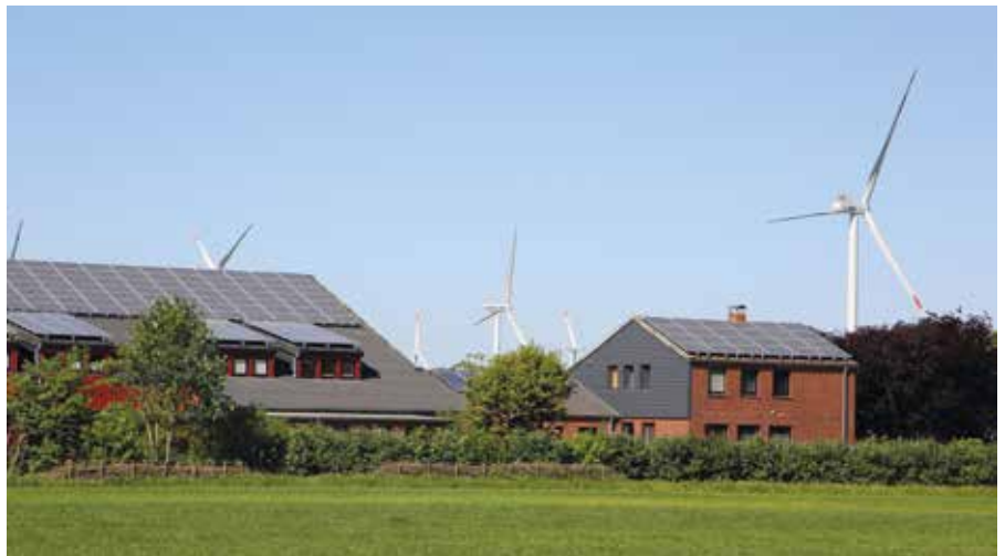
Erneuerbare Energien spielen in der Gemeinde Lübke-Koog seit vielen Jahren eine wichtige Rolle. Etwa 30 Windenergieanlagen mit etwa 75 Megawatt umfasst der Bürger-Windpark heute. Mehrere Jahre lang war Lübke-Koog auch Spitzenreiter der Solarbundesliga.
