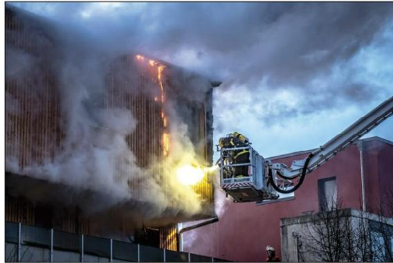
**Feuer 3:** In der Humboldtstraße brennt ein hölzernes Penthouse, das auf einem Bunker aus dem Zweiten Weltkrieg aufgesetzt ist. Der Einsatz wird durch erschwerte Zugänglichkeit behindert, Löschmaßnahmen, besonders in Bereichen der hölzernen Außenwände, sind nur über Hubrettungsfahrzeuge von der Straße möglich
