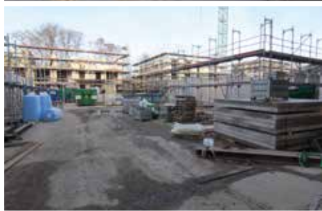
Beton und Asphalt: Mit einem Festakt wurde bereits die Gert-Marcus-Straße eingeweiht (lesen Sie dazu auch die Vertreterausfahrt ab Seite 6).
