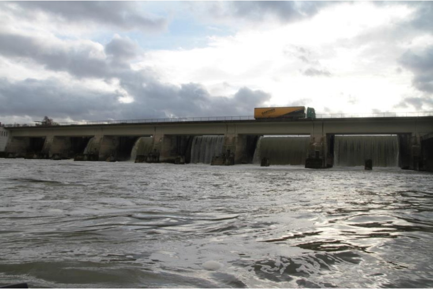
Abb. 3: Wehrfeld der Rheinstaustufe Iffezheim
