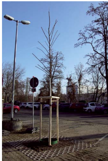
Nach der Pflanzung: Die BaumExperten von Wurotec roden, pflanzen und pflegen professionell. (Hier im Bild: Dieselbe Rodungsstelle nach der Erneuerung des Bodenbelags und der Neupflanzung.) (Fotos: Wurotec GmbH & Co. KG)
