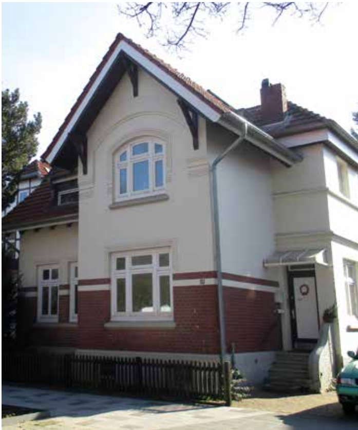
1909 wurde dieses Haus in der Tangstedter Landstraße gebaut. Man erkennt schön den charakteristischen Dachstuhl.
