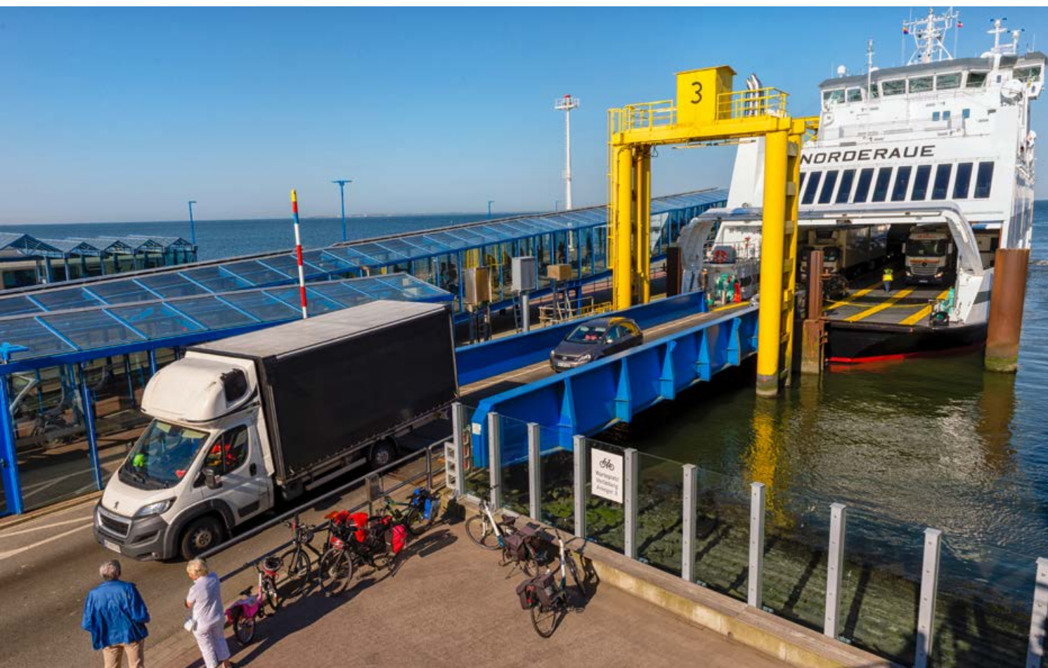
Zuwachs. Der Neubau bietet vier Spuren nebeneinander, die für Lkws nutzbar sind – Gesamtlänge: 270 Meter.
