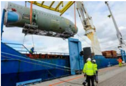
Rumpf. Der Schiffskran hievt das Teil an Bord.
