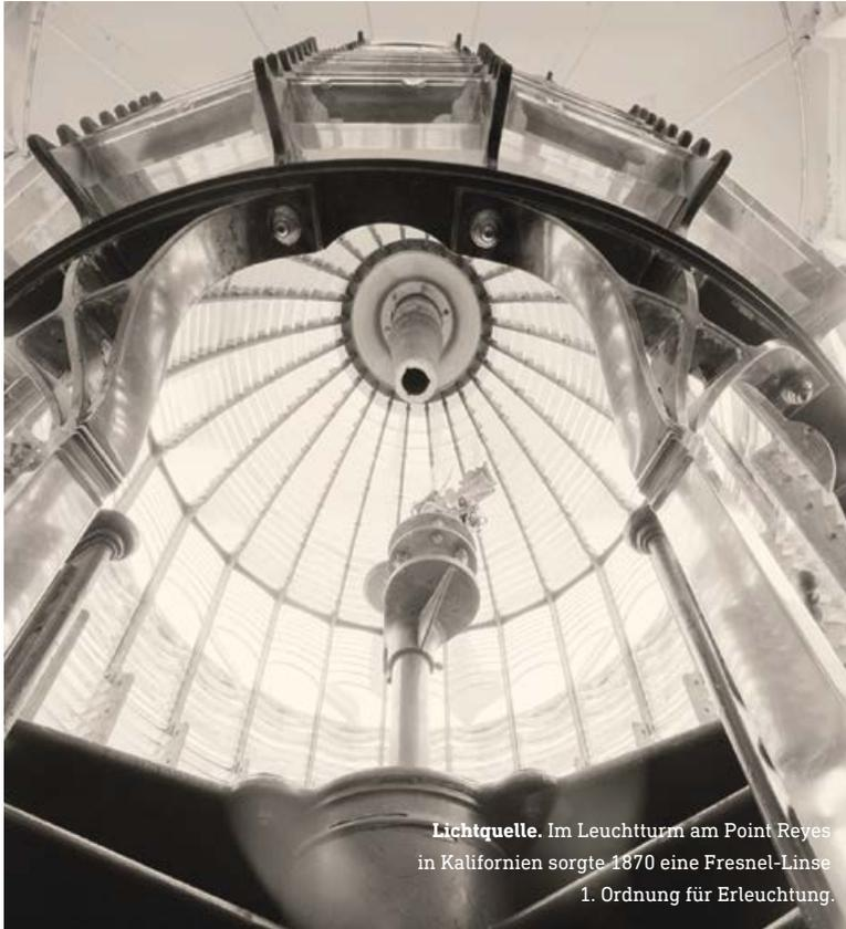
**Lichtquelle.** Im Leuchtturm am Point Reyes in Kalifornien sorgte 1870 eine Fresnel-Linse 1. Ordnung für Erleuchtung.
