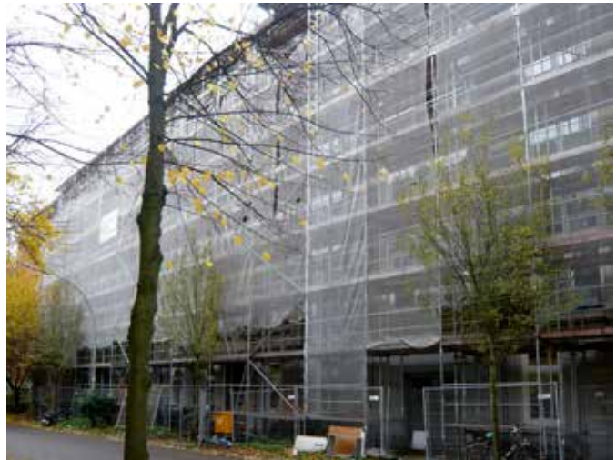
Hamburger Hochstraße: Zufriedenere Mieter bei Modernisierung
