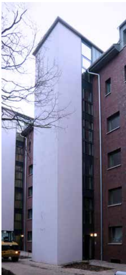
Wärmedämmung und Fahrstuhlneinbau lassen Mieten in die Höhe schnellen.
