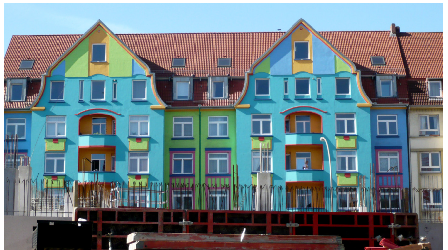
Verbauter Blick, wenn die Studentenwohnungen an der Stresemannstraße fertig sind.
