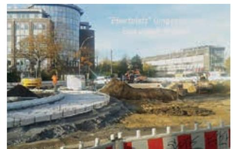
Auch in den Vorarbeiten an den beiden Brücken Chaussee und Von-Sauer-Str. ist ja ordentlich Bewegung. Die beiden Brücken sollen ja eines Tages abgerissen und durch Behelfsbrücken ersetzt werden, bevor die Straßenführung über den Deckel verläuft. Aber bis es soweit ist, kön-
