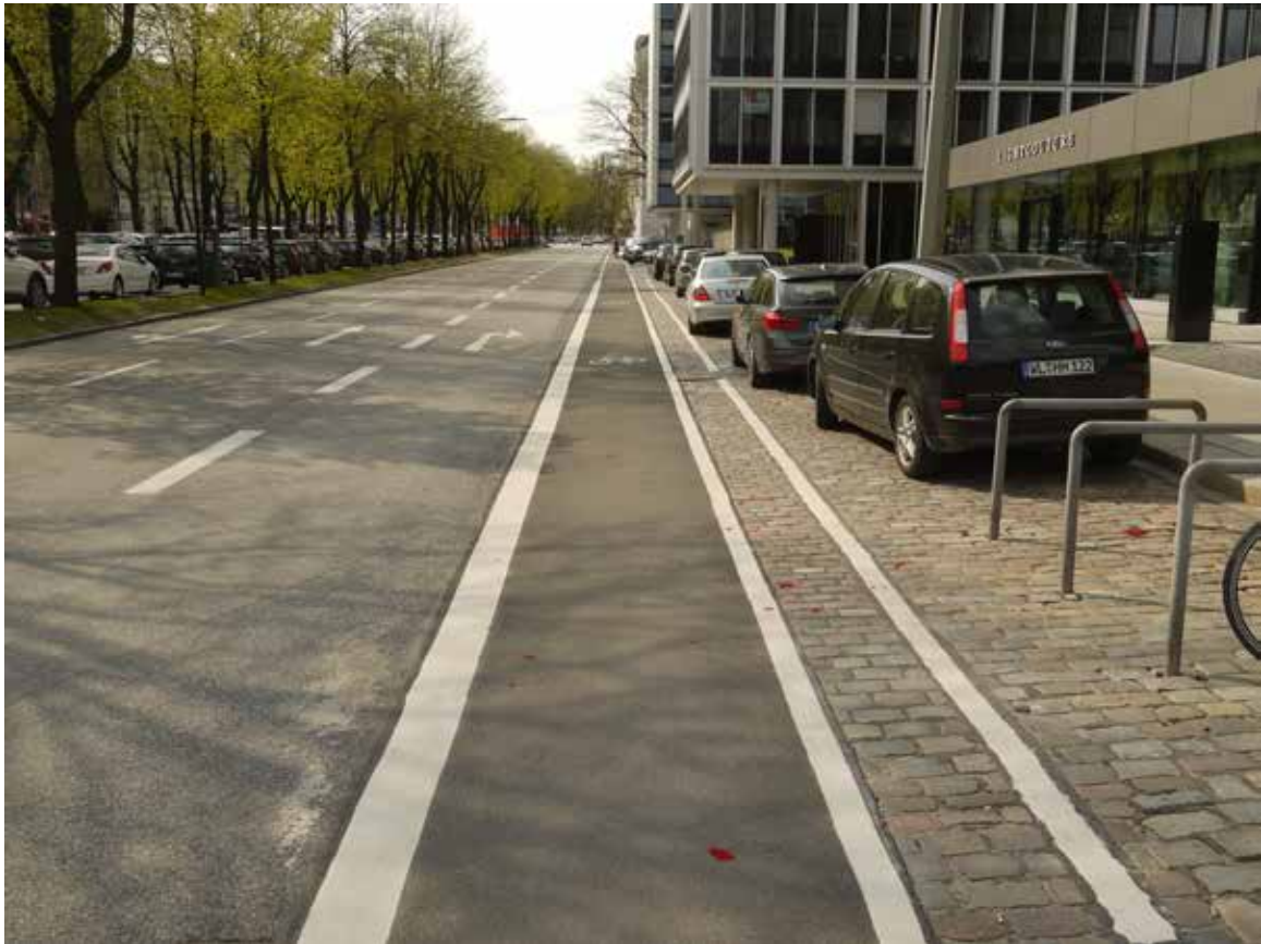
Bild 71: Esplanade, provisorischer Radfahrstreifen
