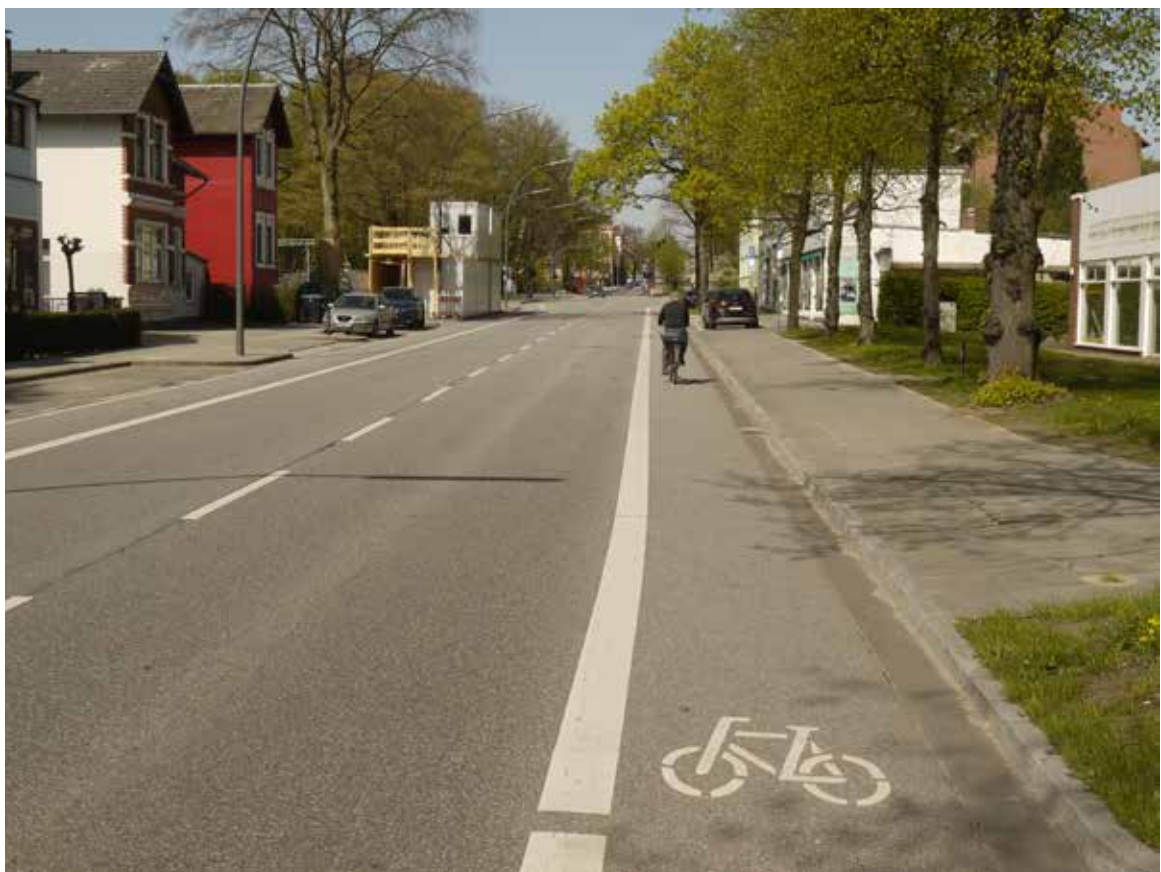
Bild 98: Bahrenfelder Chaussee, Radfahrstreifen
