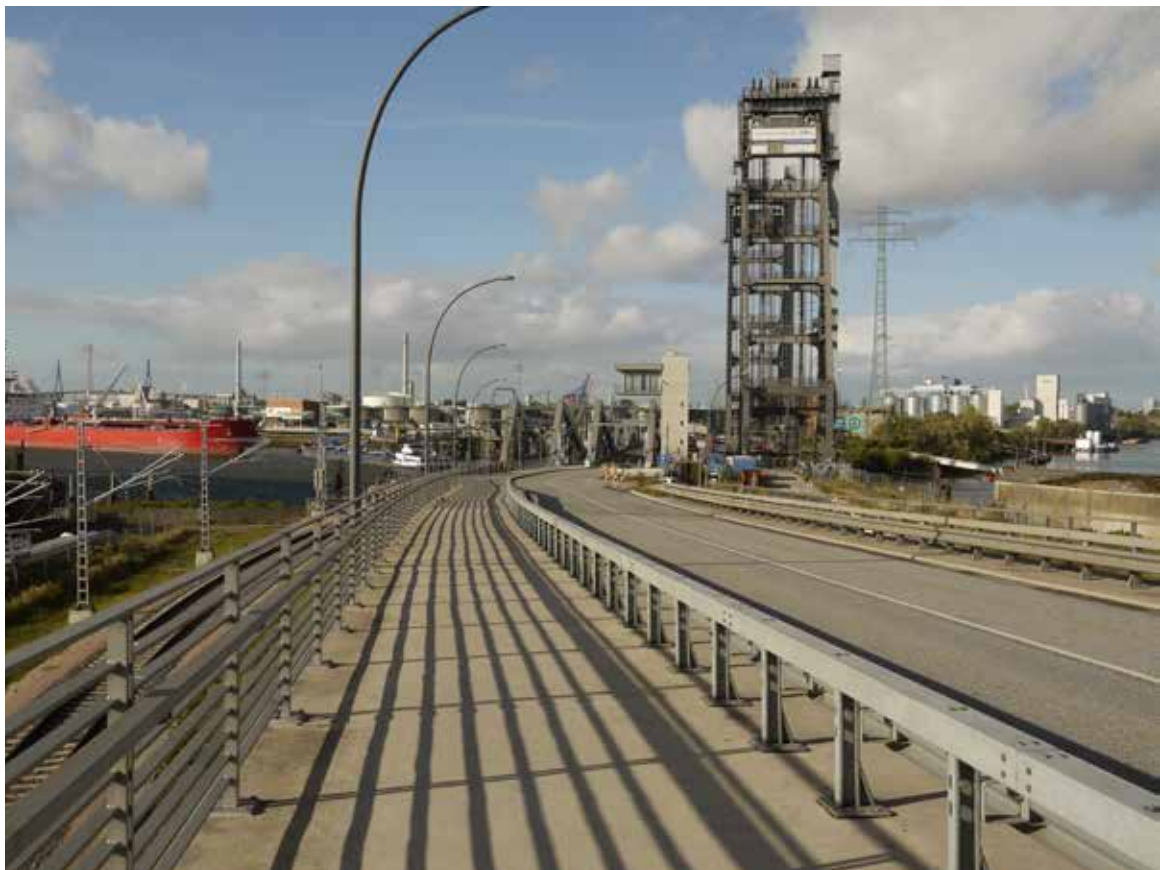
Bild 86: Rethedamm / Rethebrücke, gemeinsamer Geh- und Radweg
