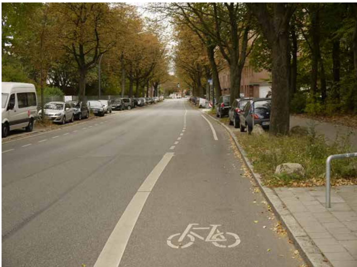
Bild 28: Rümkerstraße (Veloroute 5), Radfahr-/Schutzstreifen
