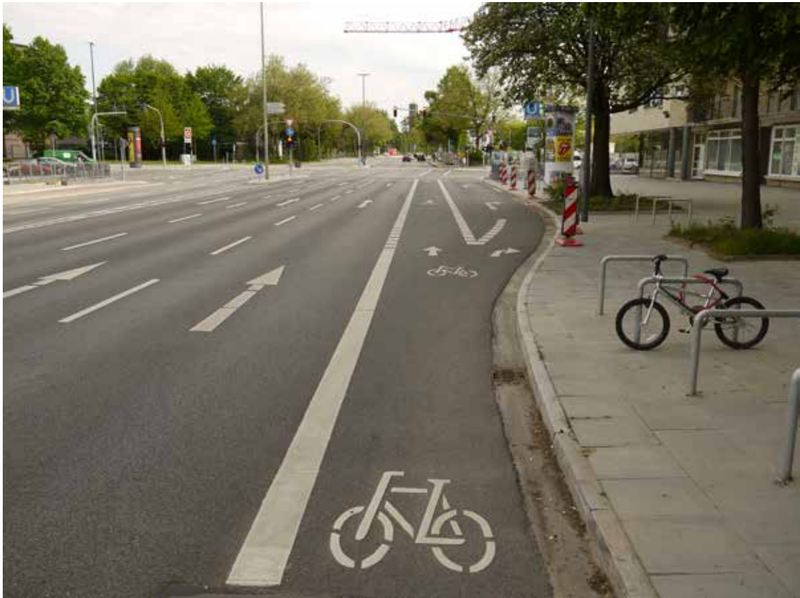
Bild 127: Mühlendamm / Lübecker Straße, Radfahrstreifen
