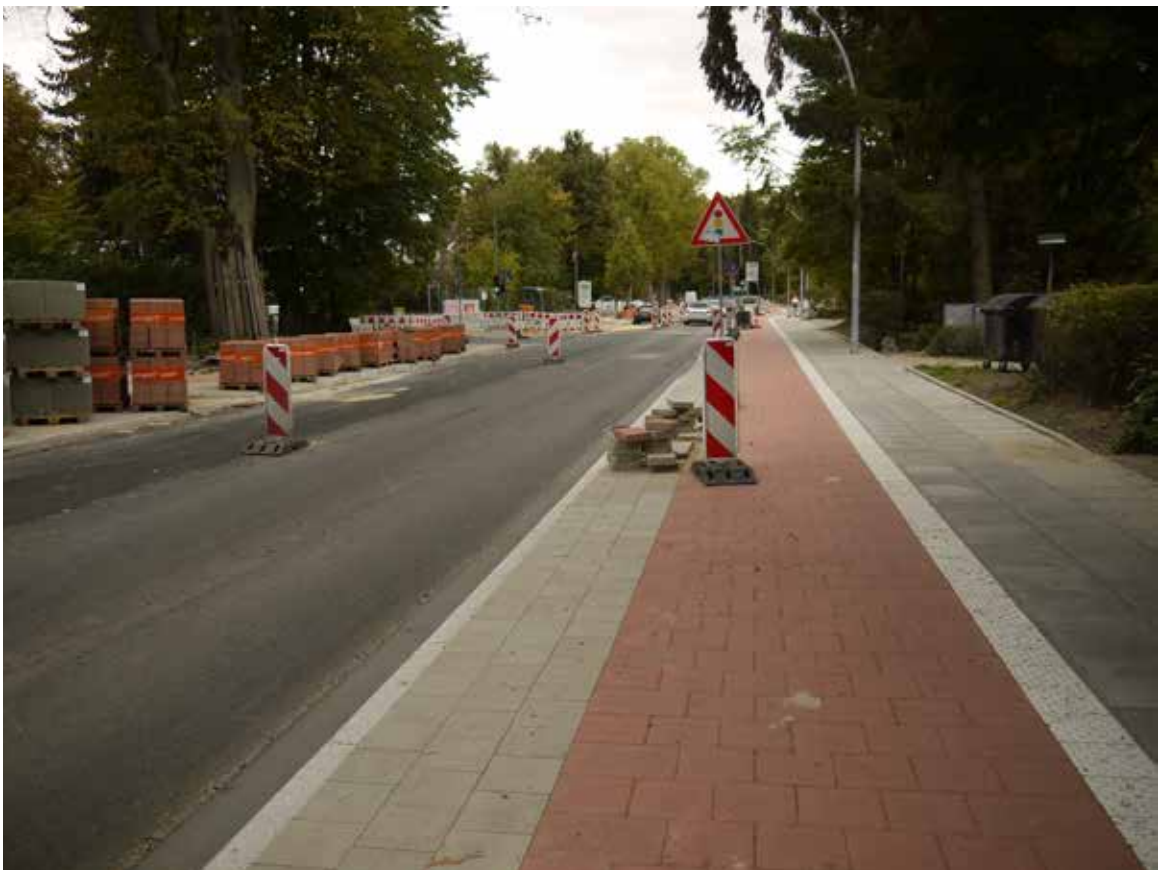
Bild 154: Meiendorfer Straße, Neubau der Radwege
