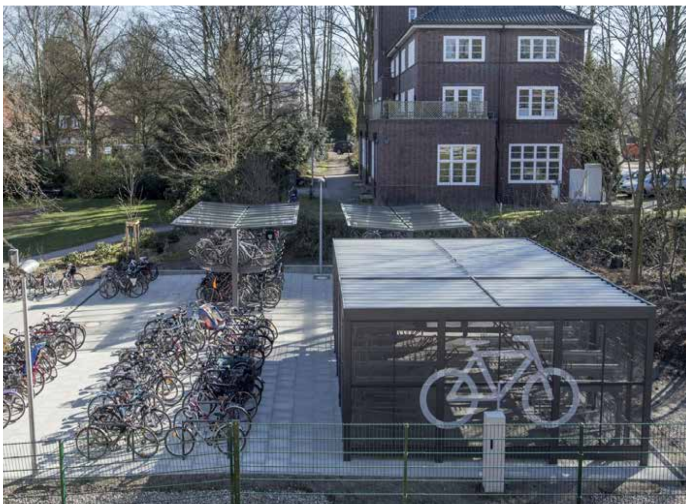
Bild 3.2: Bike+Ride-Anlage U-Bahnhof Ohlstedt (Bild: P+R GmbH)
