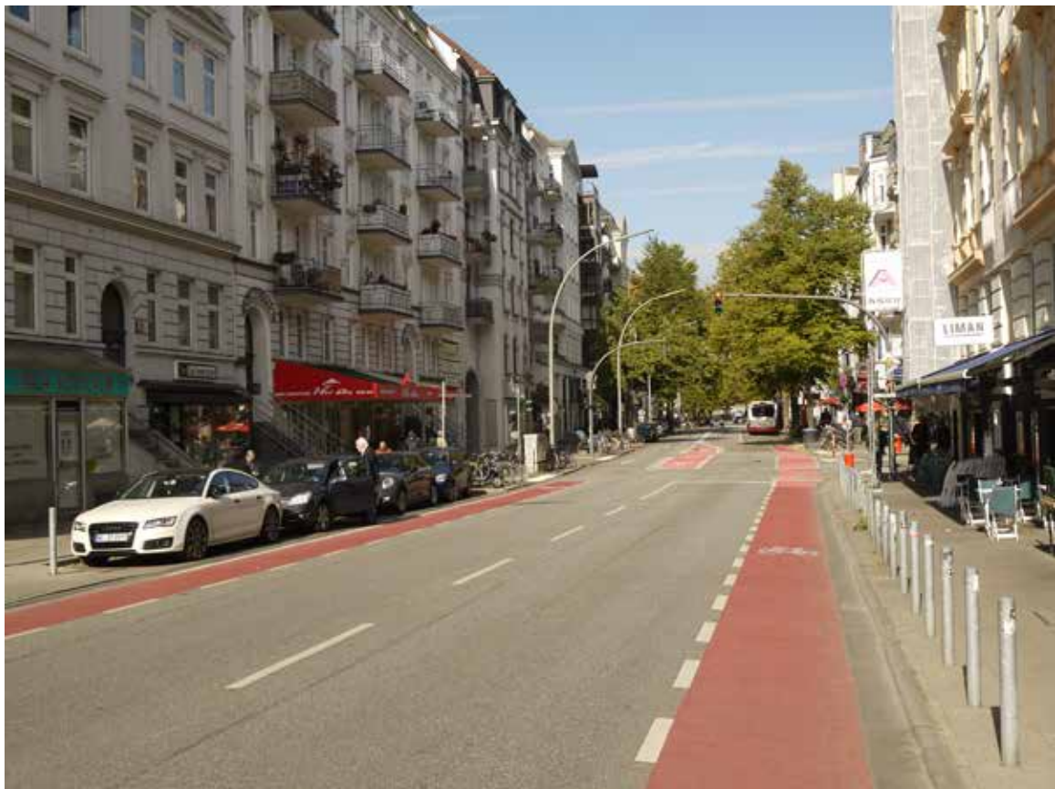
Bild 136: Mühlenkamp, Schutzstreifen mit Roteinfärbung
