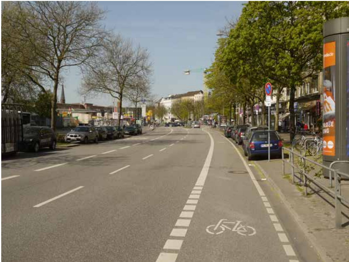
Bild 1: Feldstraße (Velorouten 1 / 2), Radfahrstreifen
