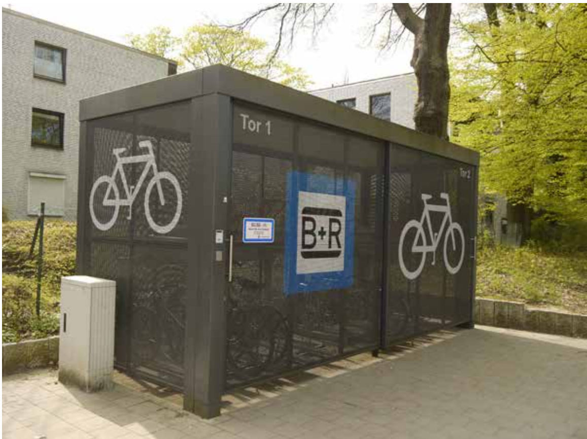
Bild 178: Bike+Ride-Anlage S-Bahn-Haltestelle Othmarschen, Sammelschließanlage
