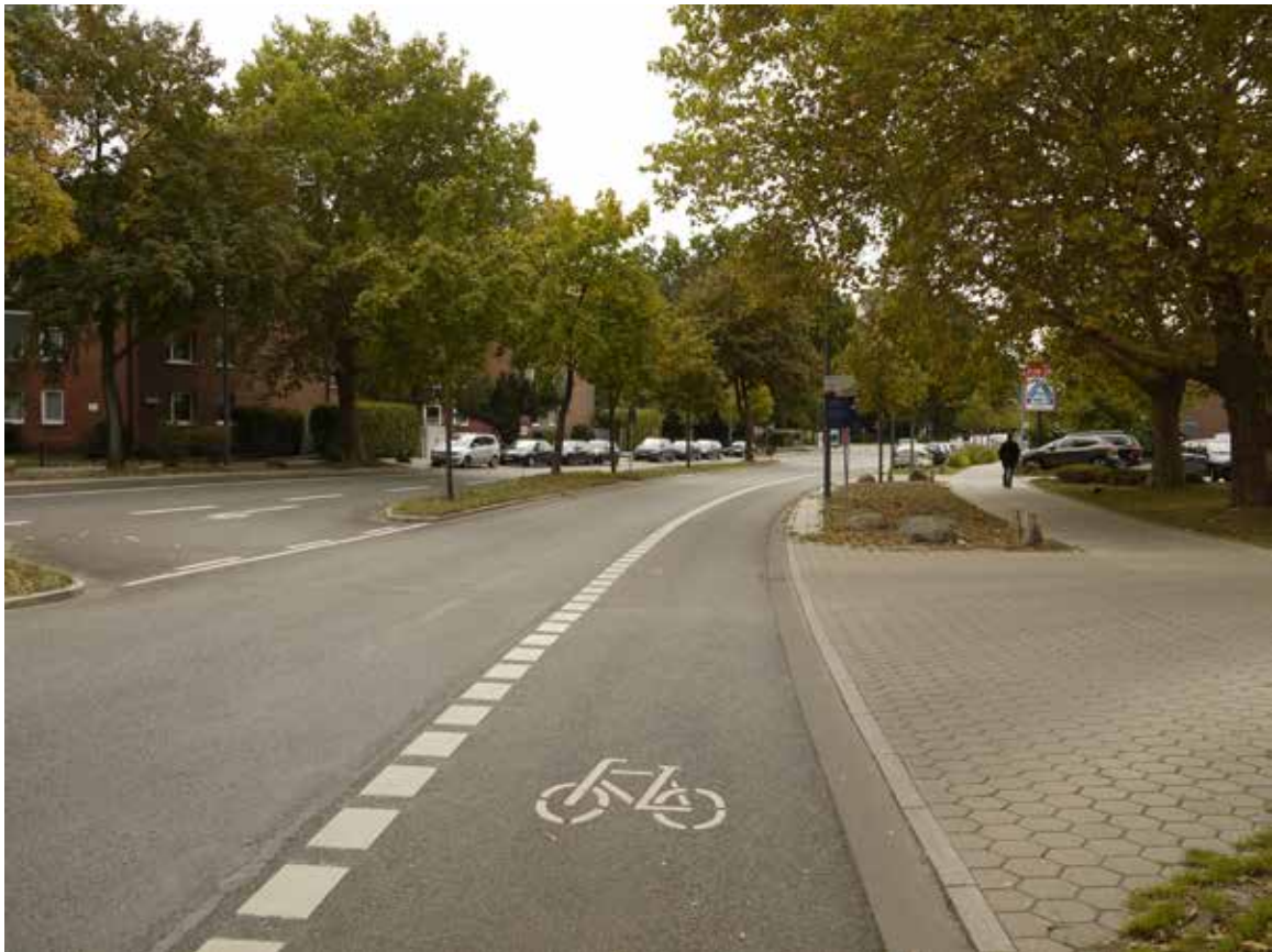
Bild 30: Steilshooper Straße (Veloroute 5), Radfahrstreifen
