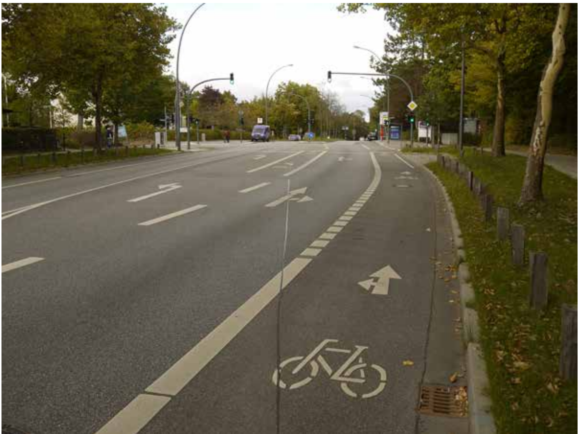
Bild 150: Alte Landstraße / Hinsbleek, Radfahrstreifen
