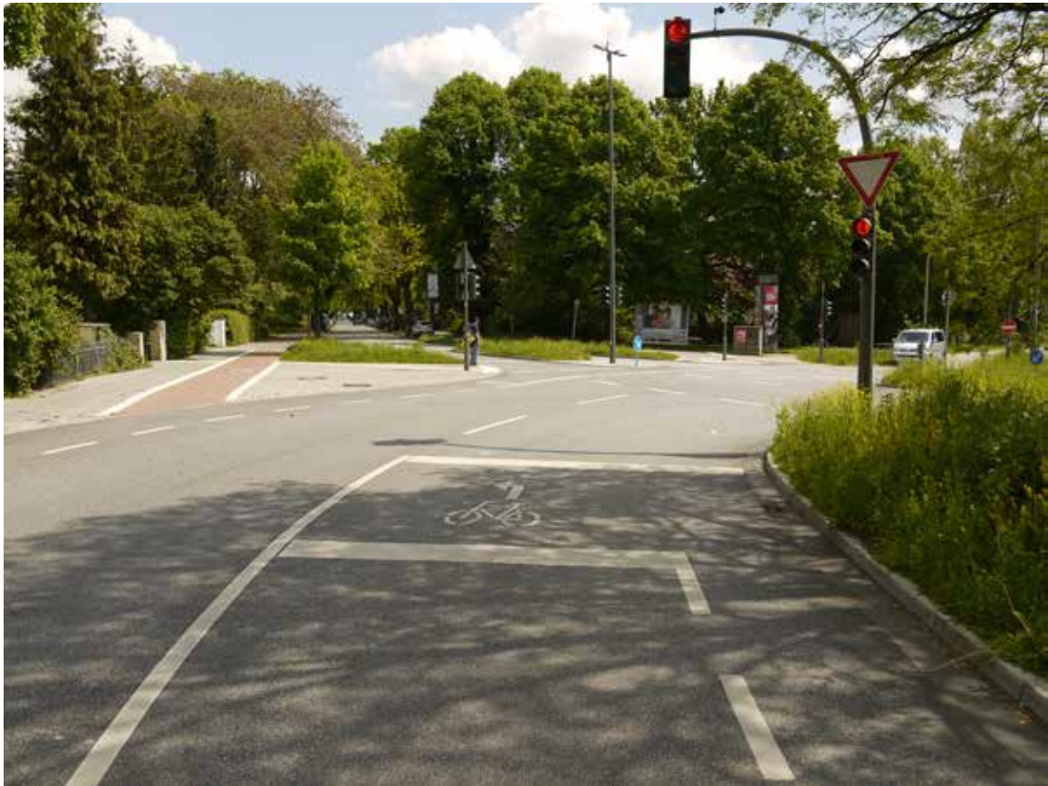
Bild 51: Lohbrügger Landstraße (Veloroute 8) / Bergedorfer Straße, aufgeweiteter Radaufstellstreifen (ARAS)
