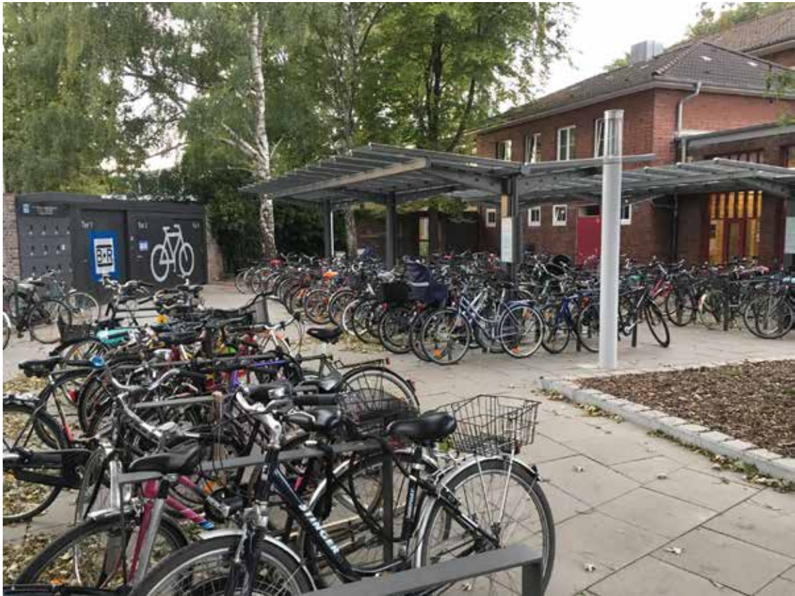
Bild 179: Bike+Ride-Anlage U-Bahn-Haltestelle Saarlandstraße
