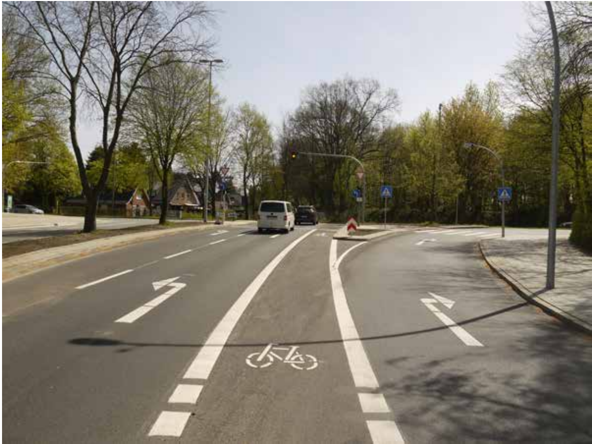
Bild 5: Bornheide (Veloroute 1) / Rugenbarg, Radfahrstreifen Richtung Grubenstieg
