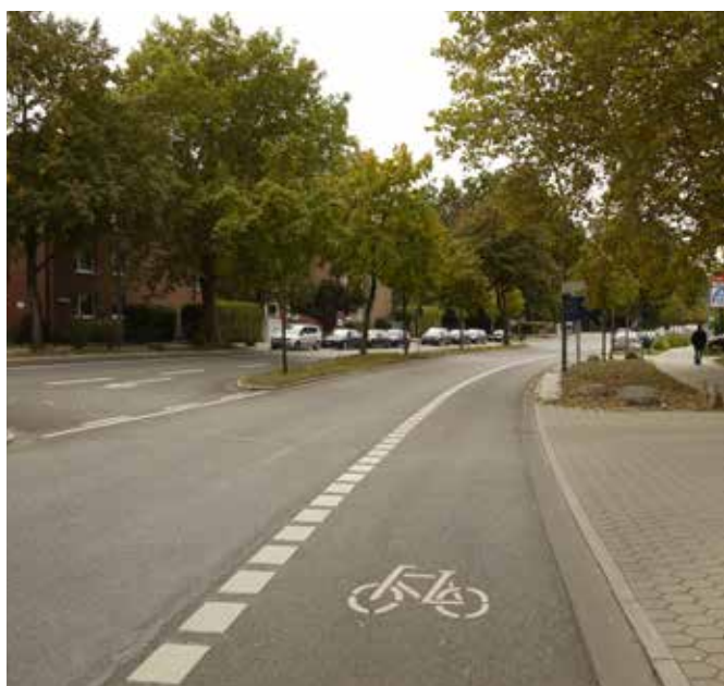
Bild 1.4: Radfahrstreifen, Veloroute 5, Steilshooper Straße (Bild: BWVI)
