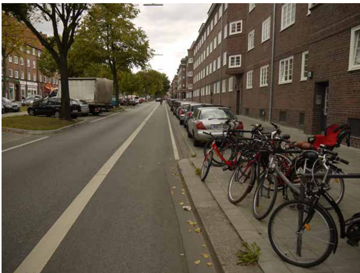
Bild 146: Straßburger Straße, Radfahrstreifen
