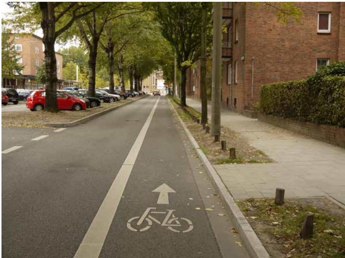
Bild 148: Straßburger Straße, Radfahrstreifen
