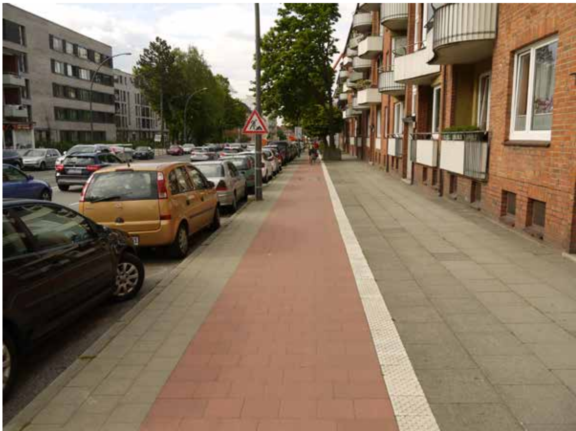
Bild 128: Mühlendamm, Instandsetzung des Radwegs
