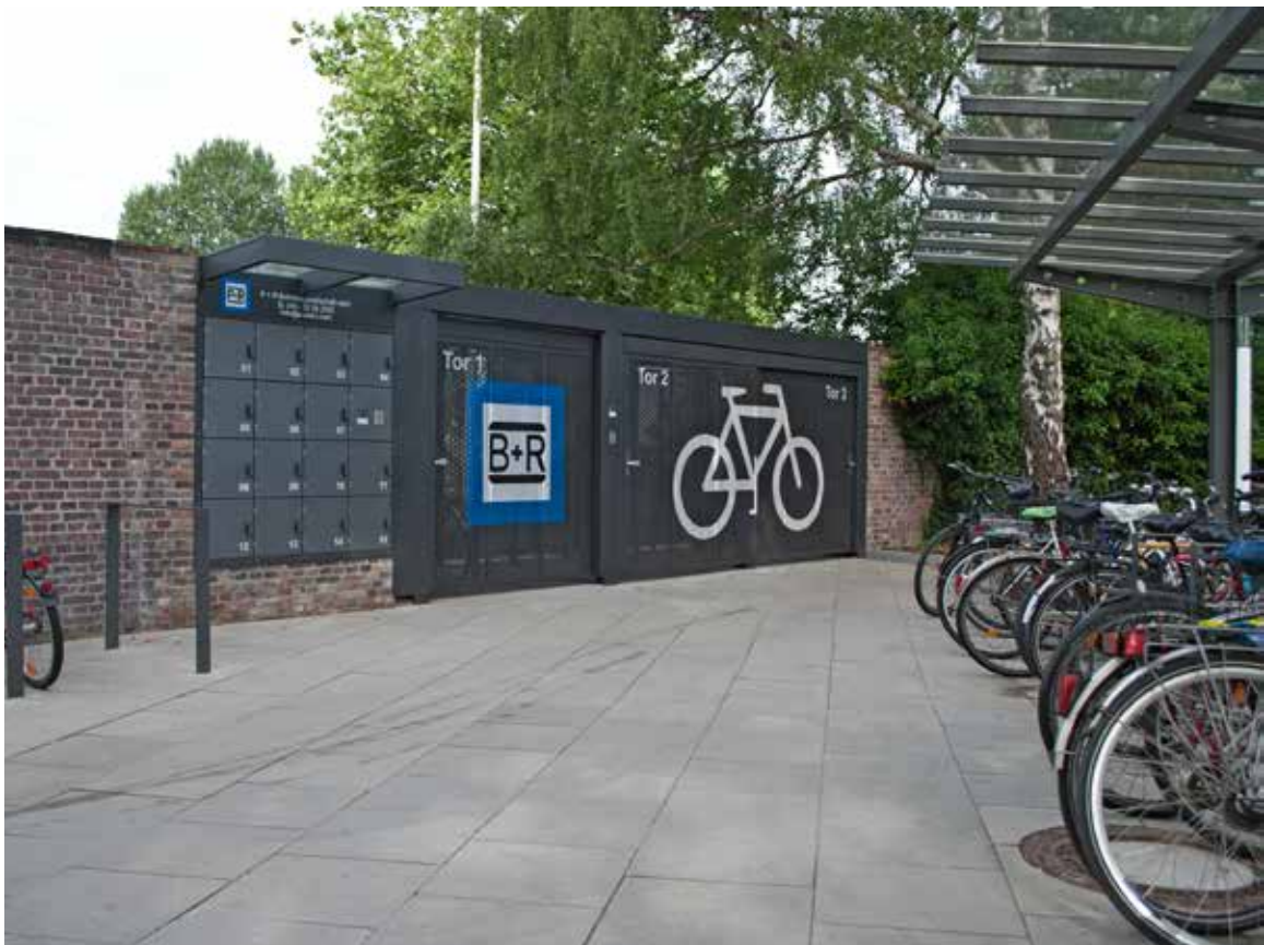
Bild 180: Bike+Ride-Anlage U-Bahn-Haltestelle Saarlandstraße, Sammel-schließenanlage und Schließfächer
