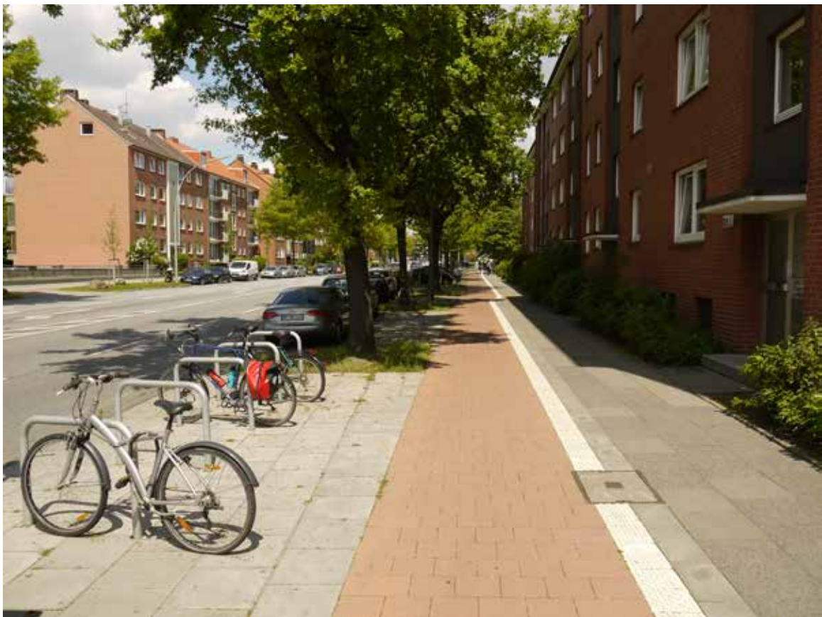
Bild 76: Grevenweg, Instandsetzung des Radwegs und neue Fahrradbügel
