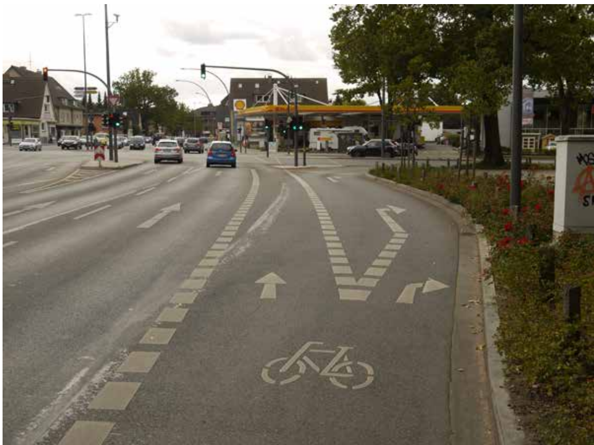
Bild 152: Stadtbahnstraße / Saseler Chaussee, Radfahrstreifen
