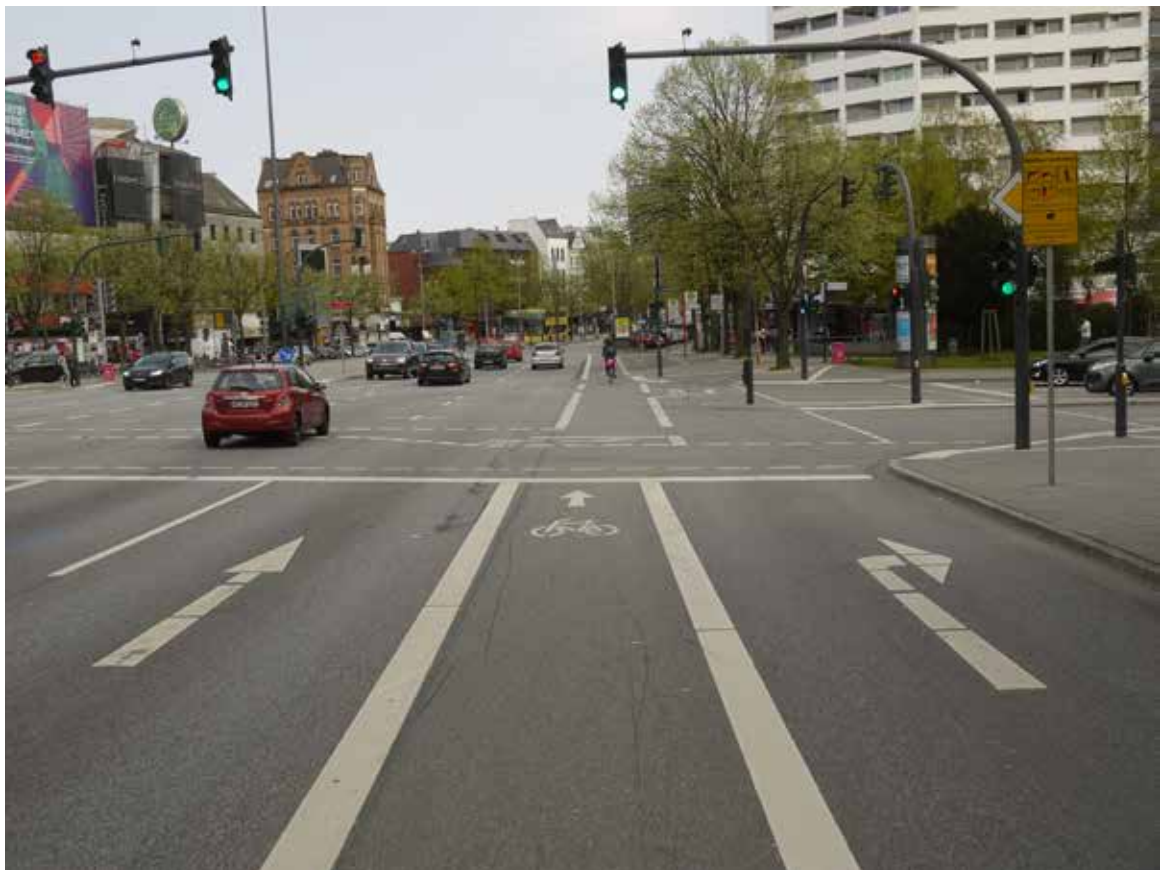
Bild 90: Pepermölenbek / Reeperbahn / Holstenstraße / Königstraße, Radfahrstreifen
