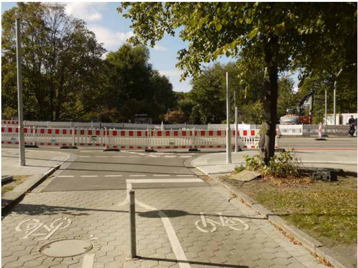
Bild 36: Uferstraße (Veloroute 6) / Lerchenfeld, Einbau einer signalisierten Querung für Radverkehr
