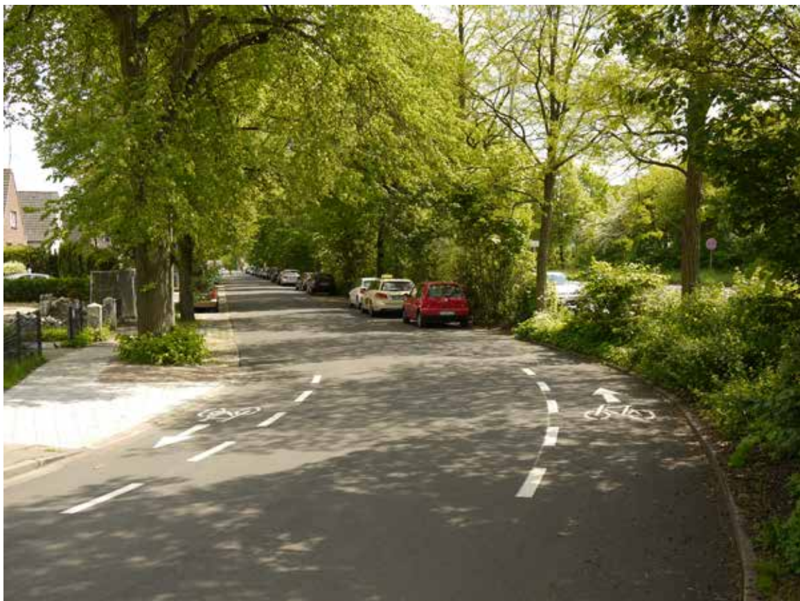
Bild 50: Lohbrügger Landstraße (Veloroute 8), Instandsetzung der Fahrbahn einschließlich angedeuteter Schutzstreifen
