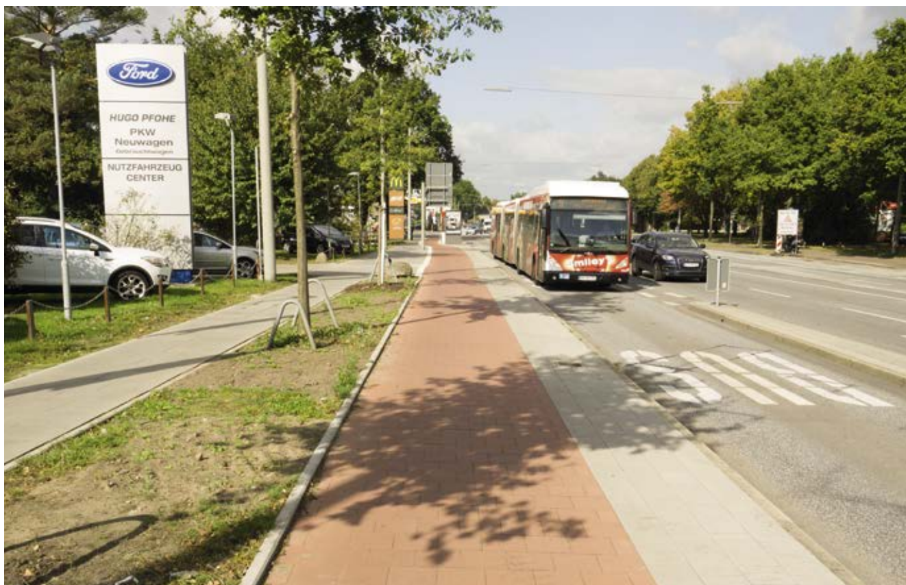
Bild 92: Kollastraße, Ausbau und Verbreiterung des Radwegs im Rahmen der Busoptimierung
