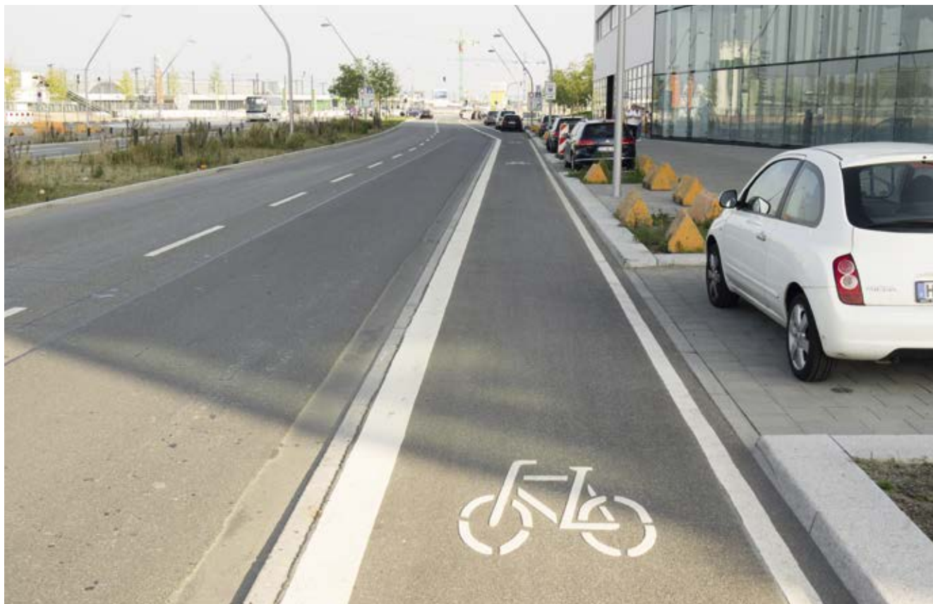
Bild 35: Überseeallee (Veloroute 10), Radfahrstreifen mit Bordkante
