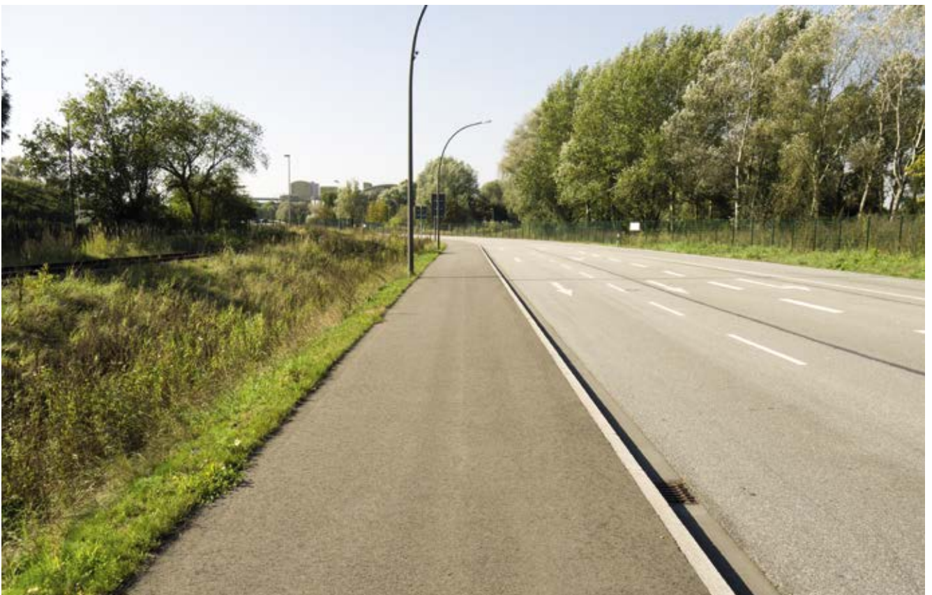
Bild 114: An der Alten Süderelbe (Umgehung Finkenwerder, Freizeitroute 11), Bau eines gemeinsamen Geh- und Radwegs
