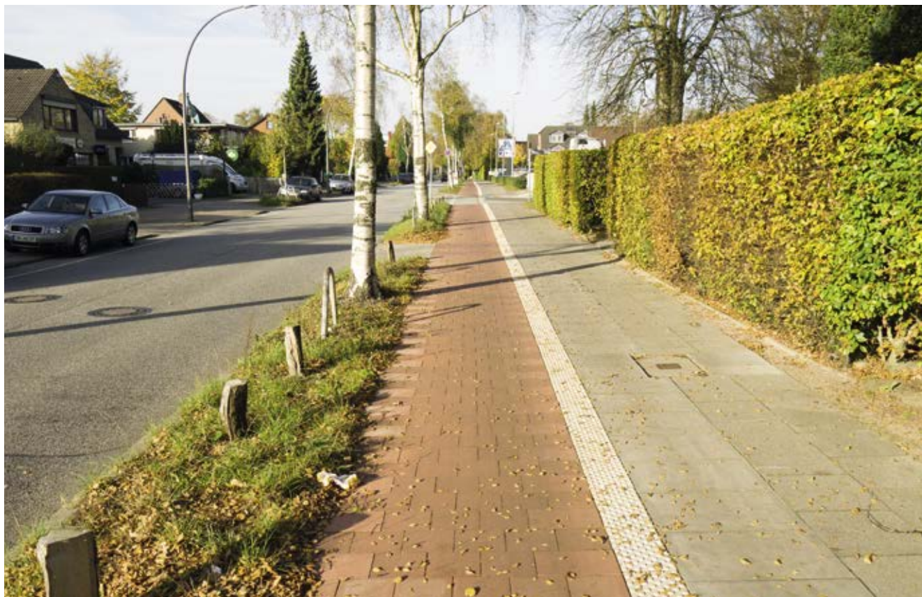
Bild 107: Bekassinenu, Ausbau und Verbreiterung des Radwegs
