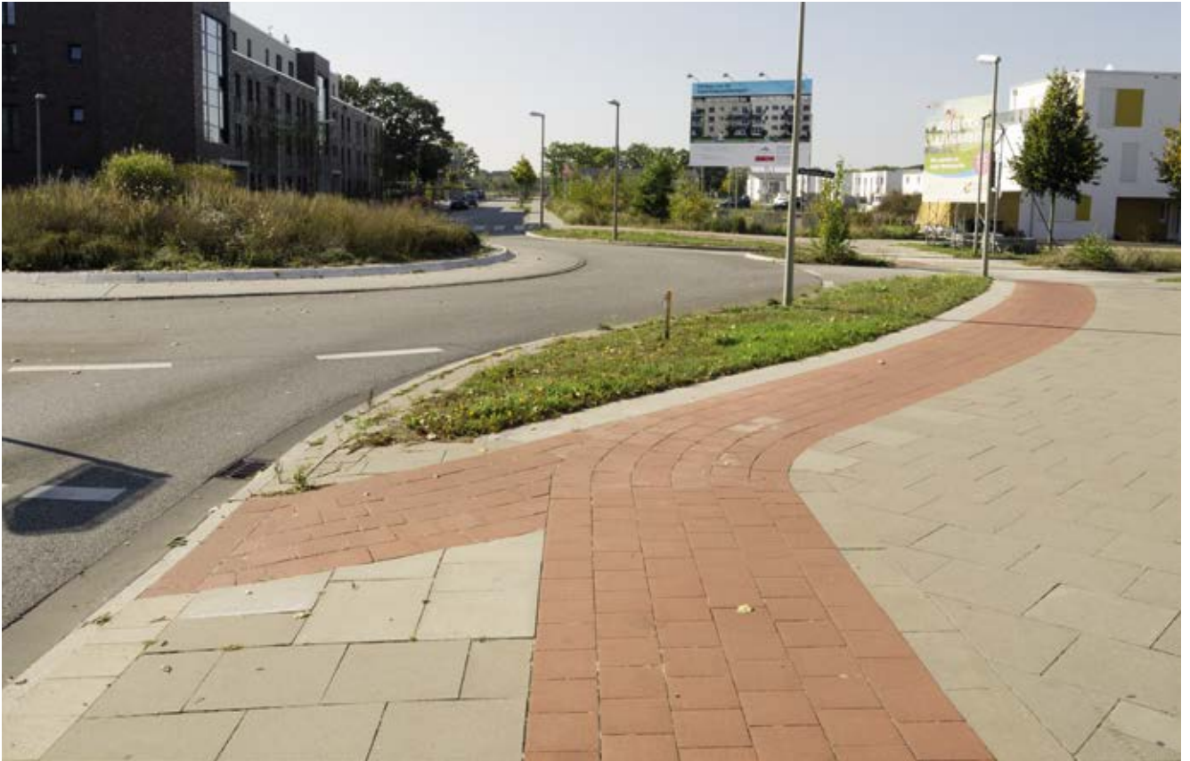
Bild 113: Süderelbebogen / Neuwiedenthaler Straße, Bau von Radwegen am Kreisverkehr
