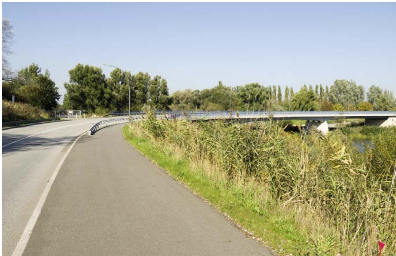
Bild 115: An der Alten Süderelbe (Umgehung Finkenwerder, Freizeitroute 11), Bau eines gemeinsamen Geh- und Radwegs
