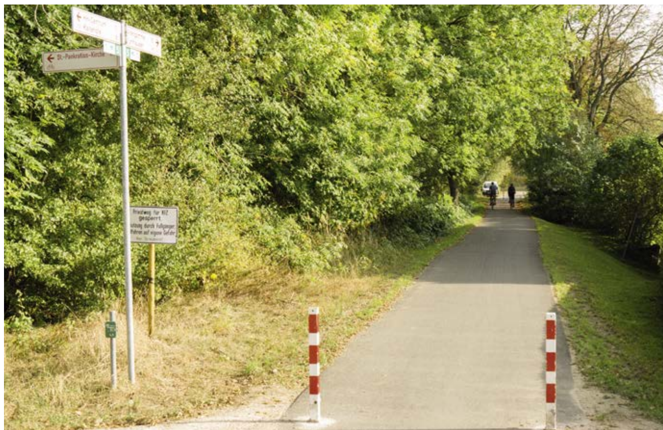
Bild 55: Marschbahndamm in Ochsenwerder (Freizeitroute 5, Elberadweg, Radfernweg Hamburg – Rügen), Ausbau des selbstständig geführten gemeinsamen Geh- und Radwegs
