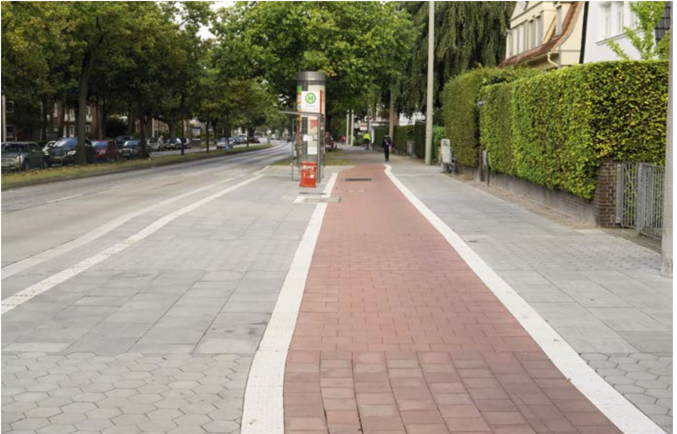
Bild 85: Lokstedter Steindamm, Ausbau und Verbreiterung des Radwegs im Rahmen des Bushaltestellenausbaus
