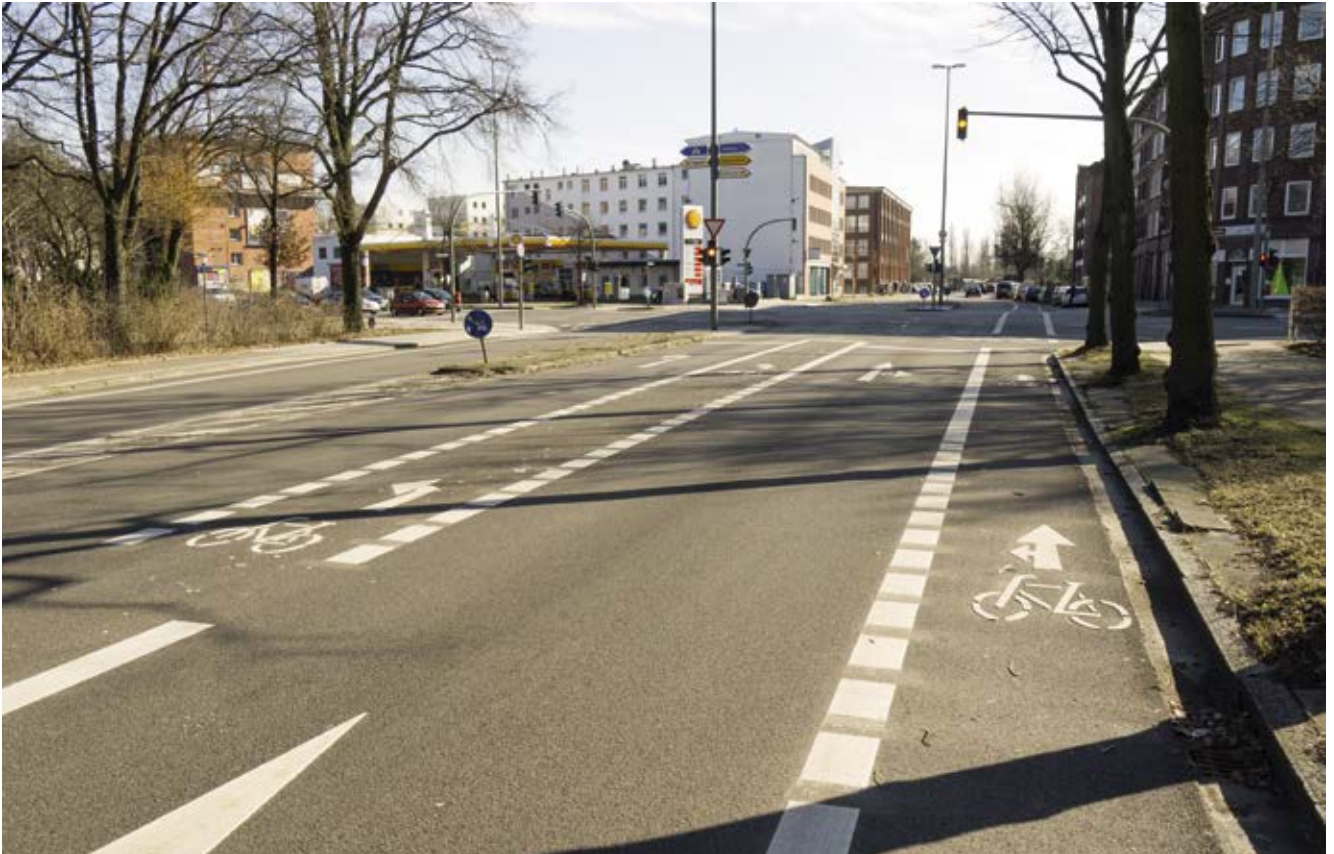
Bild 117: Diagonalstraße / Eiffestraße, Radfahrstreifen, Linksabbiegestreifen für Radverkehr, geradlinige Führung im Knoten
