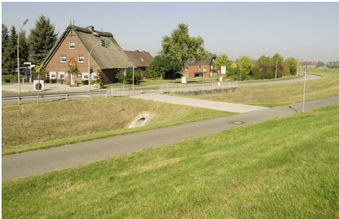
Bild 71: Aue-Hauptdeich (Elberadweg, Nordseeküstenradweg, Hafenerlebnisroute), Neubau einer Verbindung vom Radweg zur Lichtsignalanlage im Verlauf der Fahrradroutes
