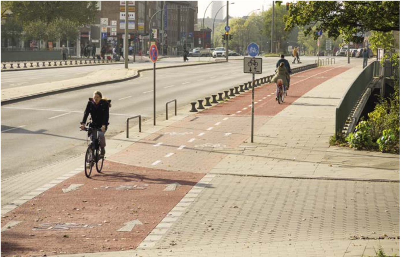
Bild 29: Berlinertordamm (Veloroute 8, Freizeitroute 4) / Klaus-Groth-Straße, Verbreiterung des Zweirichtungsradweges, Aufpflasterung der Einmündung
