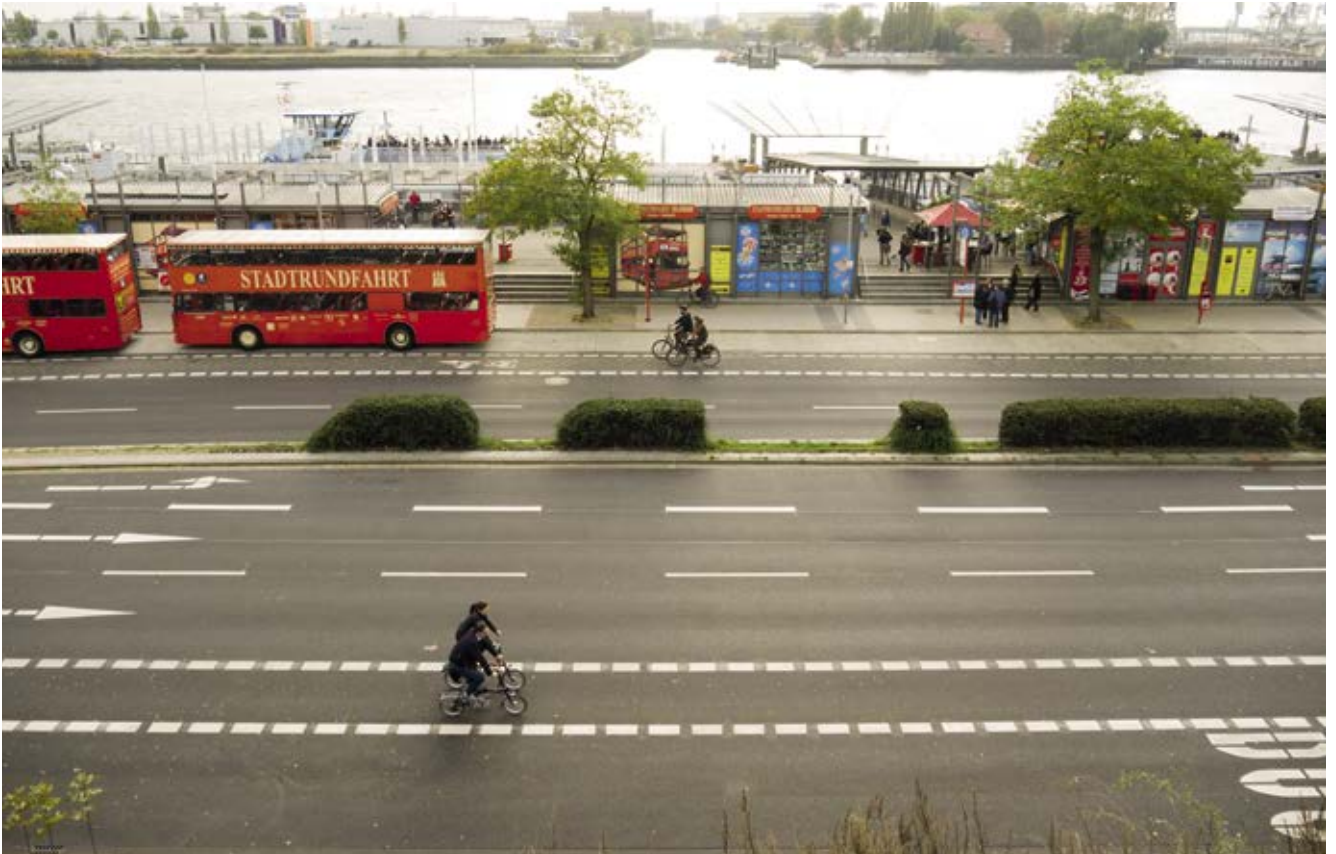
Bild 41: Bei den St. Pauli Landungsbrücken (Velorouten 11, 12, Elberadweg), Radfahrstreifen, konfliktfreie Radverkehrsführung entlang der Bushaltestelle
