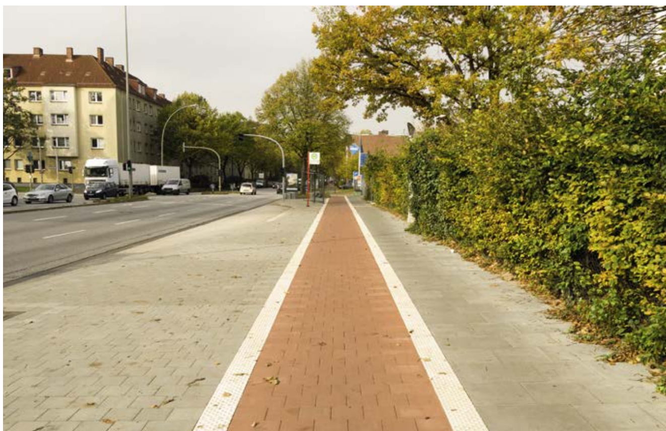
Bild 104: Habichtstraße, Ausbau und Verbreiterung des Radwegs im Rahmen des Bushaltestellenausbaus
