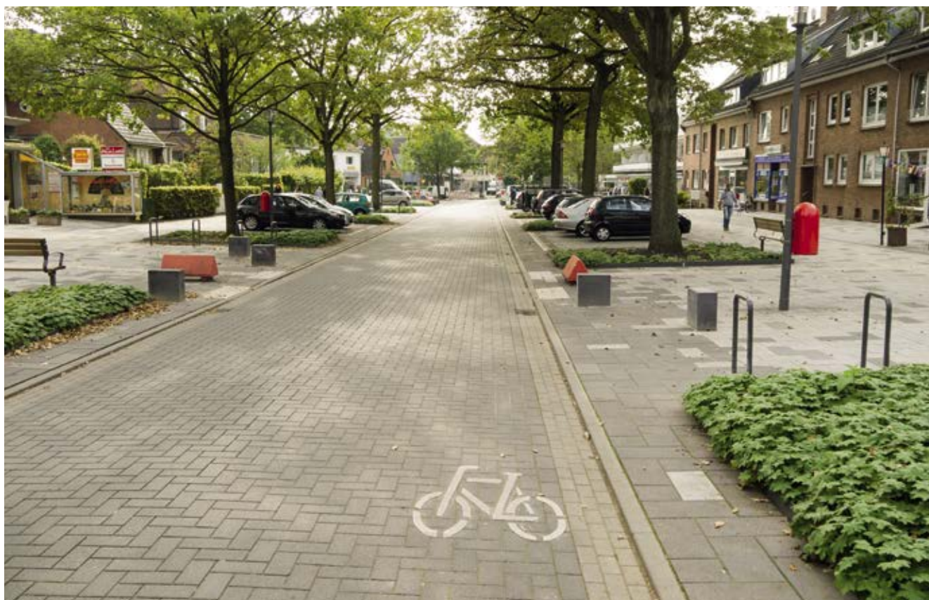
Bild 148: Tangstedter Landstraße, Fahrradpiktogramme entgegen der Einbahnstraße, Aufstellung von Fahrradbügeln
