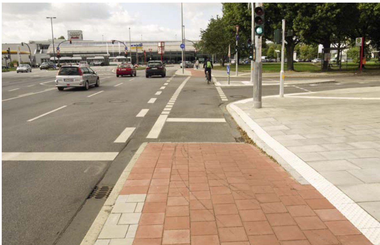
Bild 100: Nedderfeld / Alte Kollastraße, Ausbau und Verbreiterung des Radwegs, „Berliner Lösung“ ohne Konflikte mit wartenden Fußgängern
