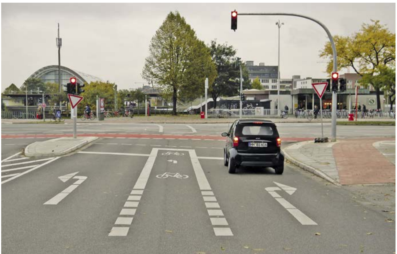
Bild 28: Berliner Tor / Beim Strohhouse (Veloroute 8, Freizeitroute 4), Linksabbiegestreifen für Radverkehr
