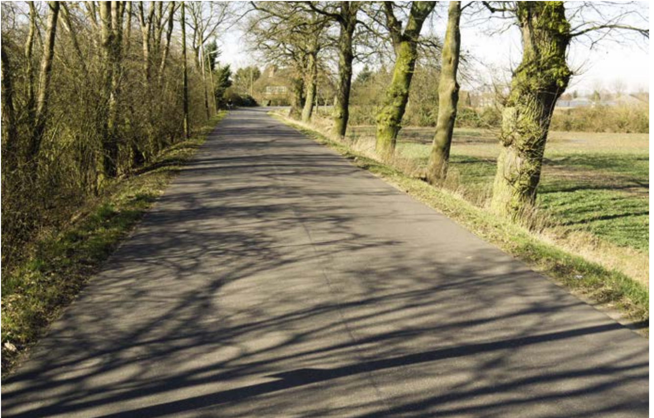
Bild 73: Ochsenwerder Norderdeich (Rosentour), Fahrbahnsanierung
