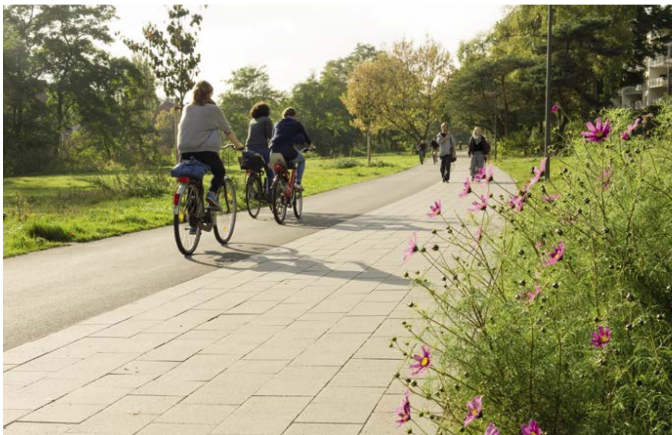
Bild 32: Oben Borgfelde (Veloroute 8, Freizeitroute 4), Ausbau des selbstständig geführten getrennten Geh- und Radweges, Ausstattung mit öffentlicher Beleuchtung und Sitzbänken
