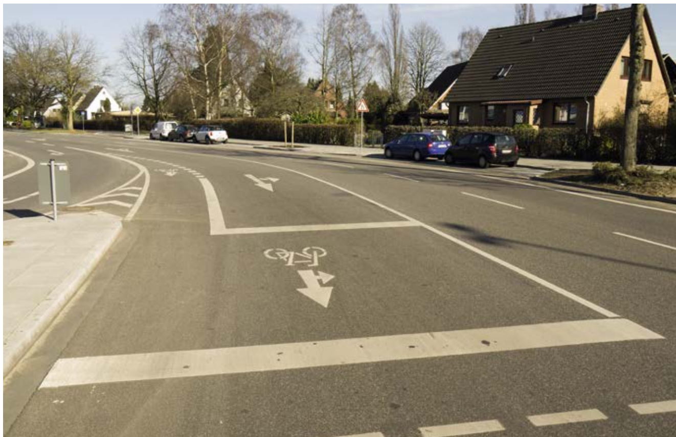
Bild 19: Schimmelmannstraße (Veloroute 7) / Holstenhofweg, aufgeweiteter Radaufstellstreifen
