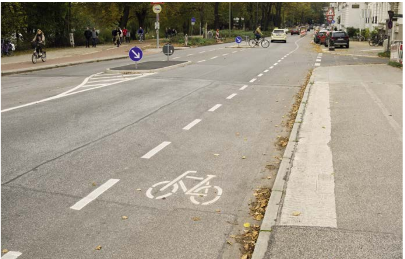
Bild 134: Schwanenwik, Schutzstreifen, Einbau von Mittelinseln als Querungshilfe
