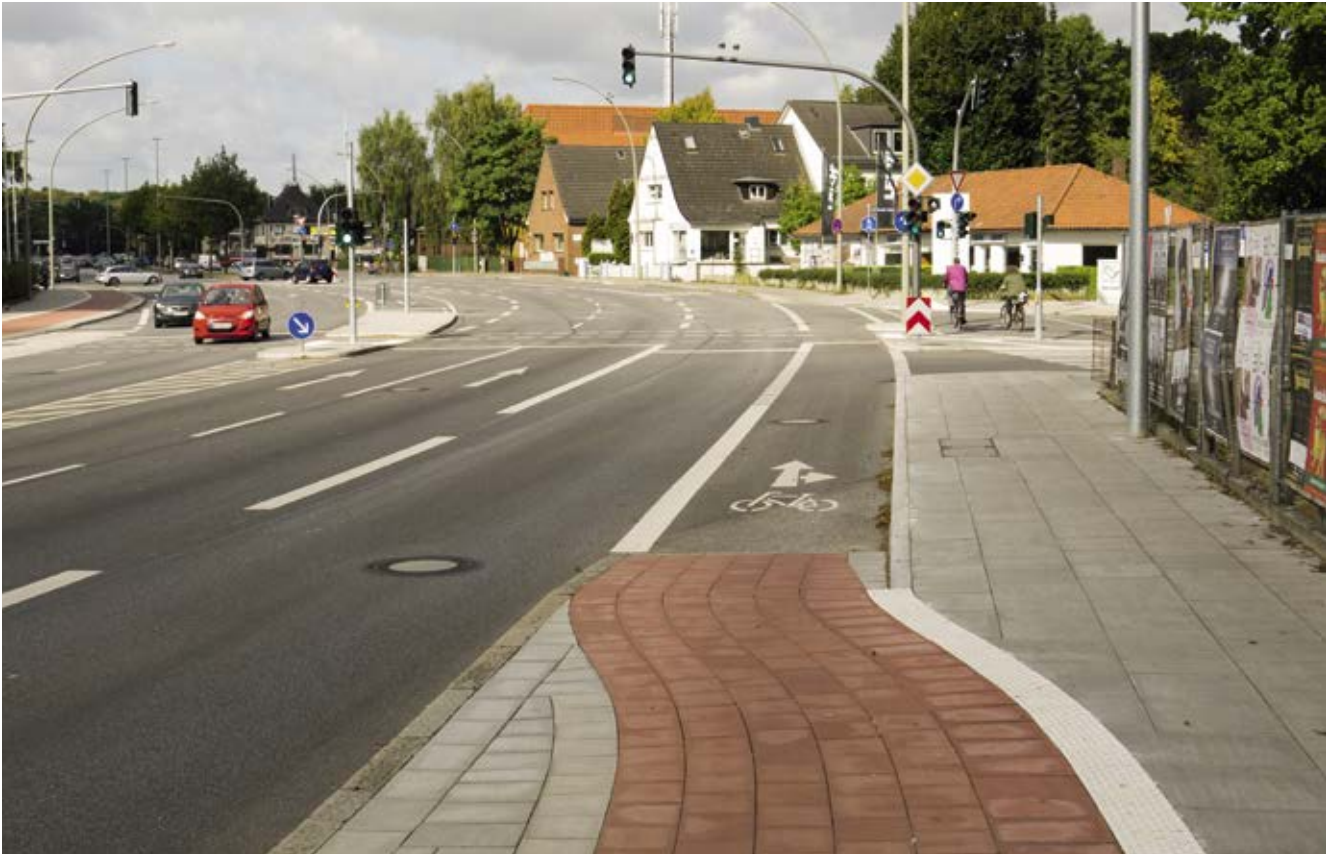
Bild 97: Kollaustraße / Groß Borsteler Straße, Ausbau und Verbreiterung des Radwegs, „Berliner Lösung“ ohne Konflikte mit wartenden Fußgängern
