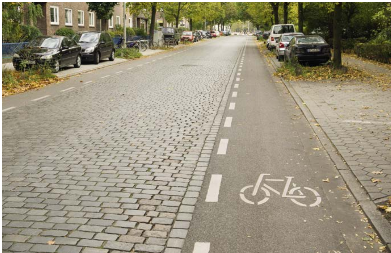
Bild 135: Hellbrookstraße, Schutzstreifen neben Kernfahrbahn aus Natursteinpflaster
