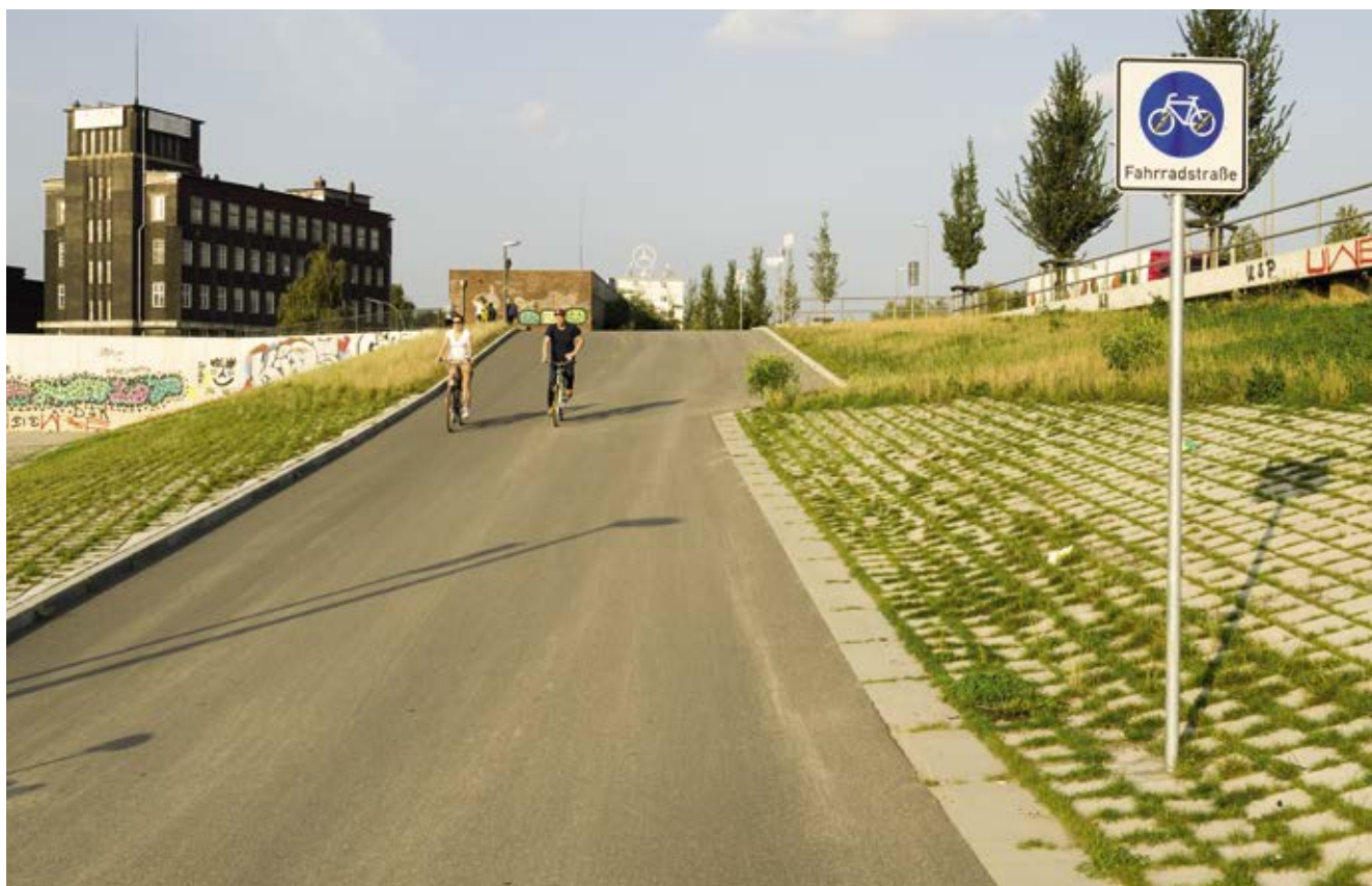
Bild 64: Billhorner Löschplatz (Freizeitrouten 5, 6, Elberadweg, Radfernweg Hamburg – Rügen), Fahrradstraße als westliche Rampe zur Unterführung Billhorner Brückenstraße
