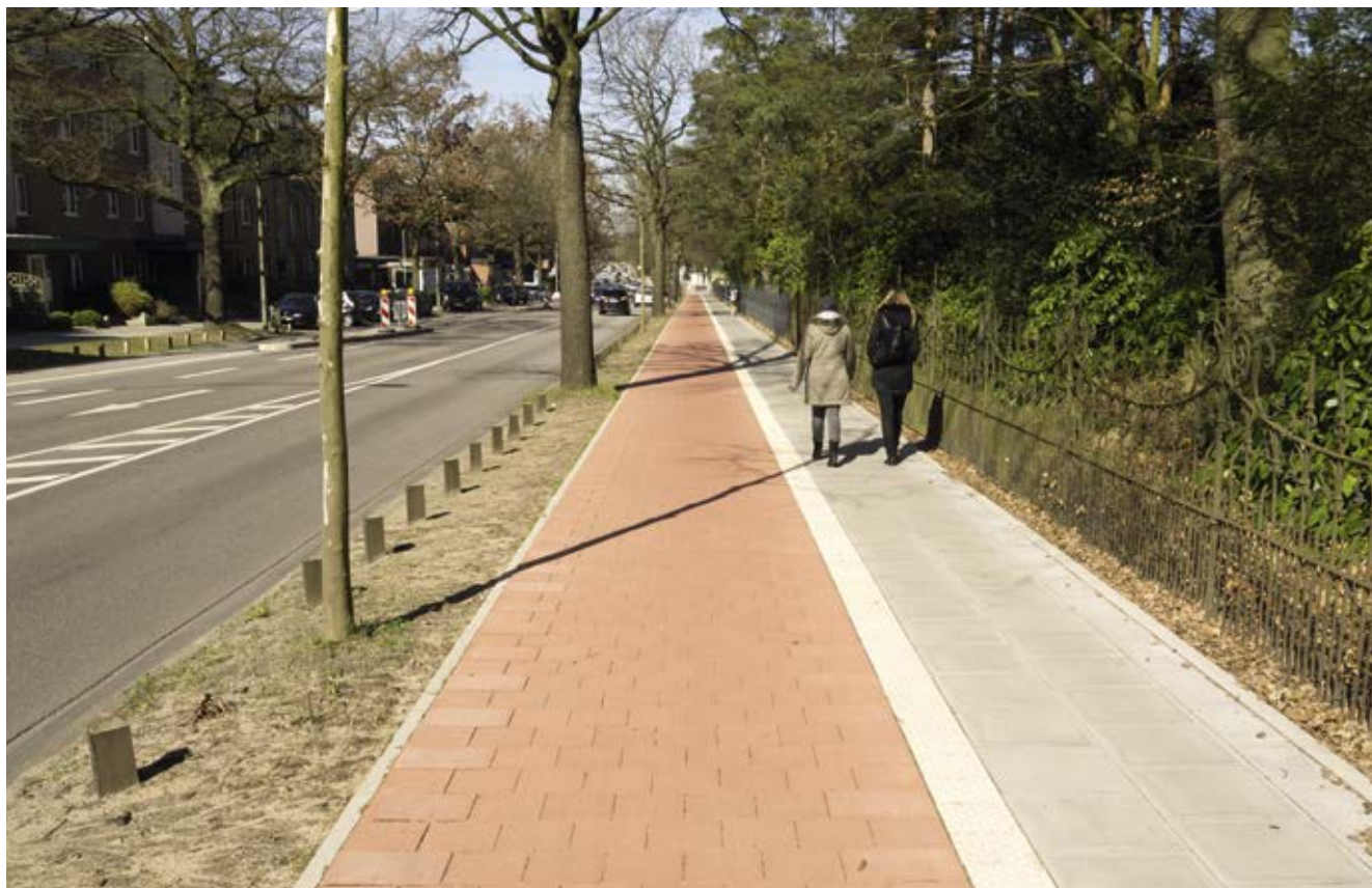
Bild 103: Fuhlsbüttler Straße, Ausbau und Verbreiterung des Radwegs im Rahmen der EMS-Maßnahme
