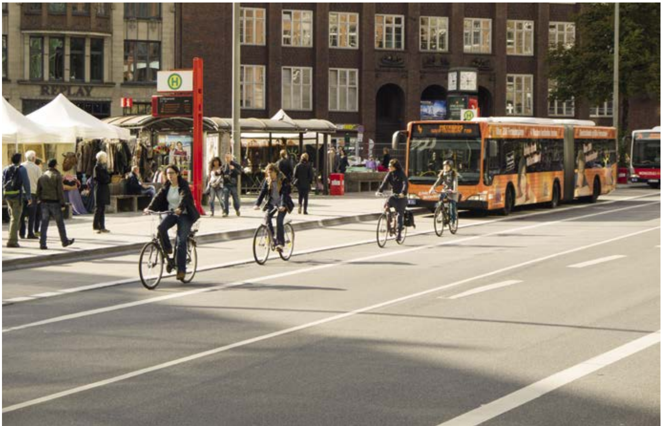
Bild 7: Gänsemarkt (Veloroute 3), Radfahrstreifen zwischen Kfz-Fahrstreifen und Bushaltestelle
