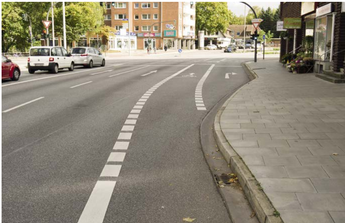
Bild 131: Vogt-Wells-Straße / Siemersplatz, Radfahrstreifen zwischen Geradeaus- und Rechtsabbiegefahrstreifen im Rahmen der Busoptimierung
