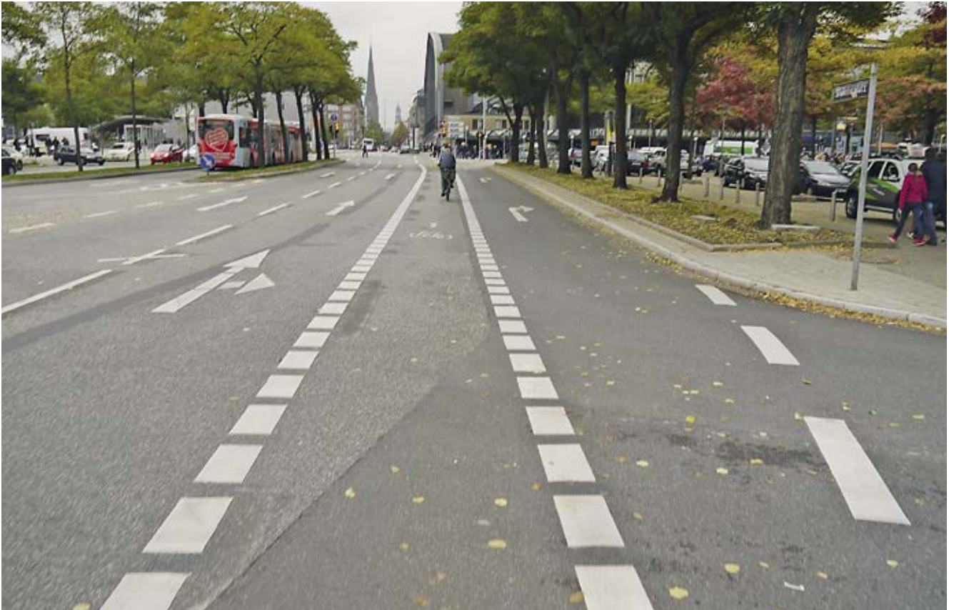
Bild 21: Steintordamm (Velorouten 7, 8) / Steintorplatz, Radfahrstreifen zwischen Geradeaus- und Rechtsabbiegefahrstreifen
