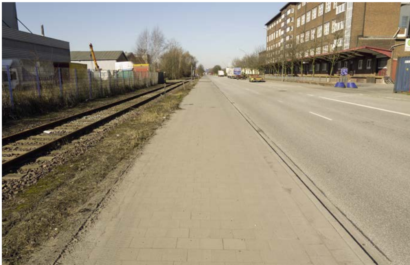
Bild 75: Peutestraße, Ausbau und Verbreiterung des gemeinsamen Geh- und Radwegs
