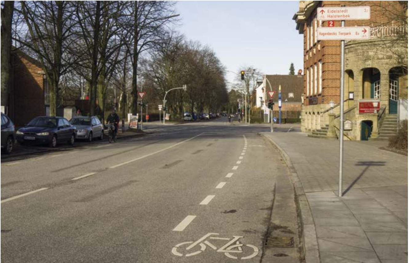
Bild 1: Basselweg (Veloroute 2) / Sportplatzring, Schutzstreifen und aufgeweiteter Radaufstellstreifen
