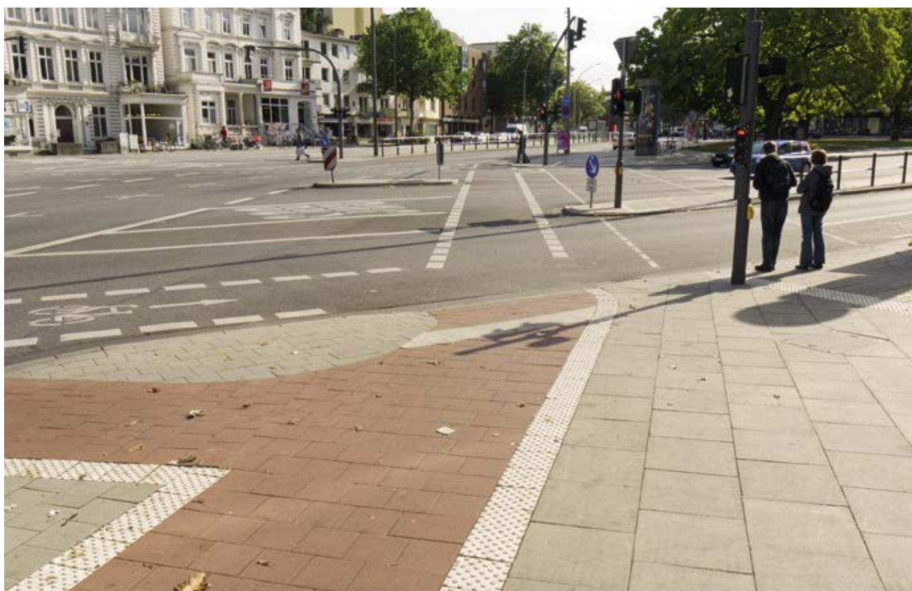
Bild 84: Grindelberg / Beim Schlump, Umgestaltung der Radverkehrsanlagen im Rahmen der Busoptimierung
