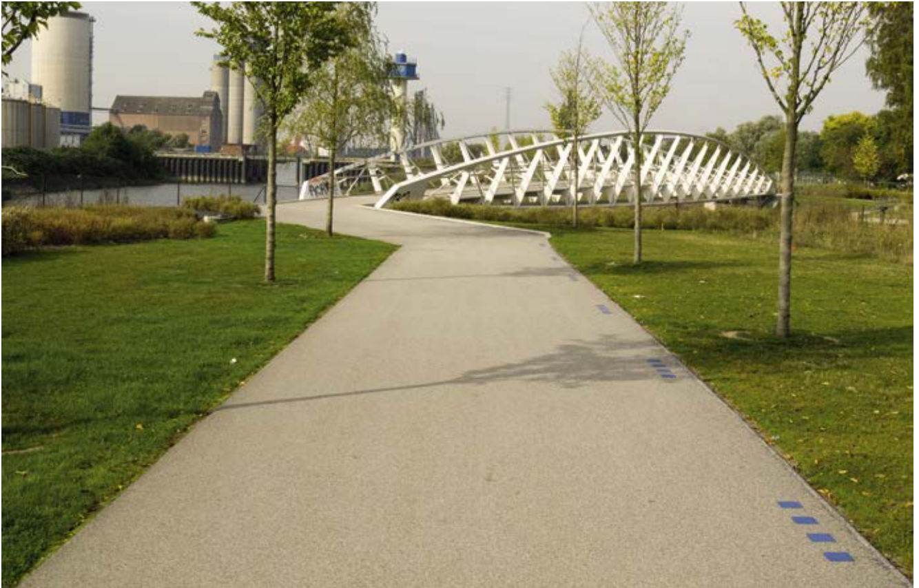
Bild 53: Weg entlang dem Äußeren Veringkanal (LOOP Wilhelmsburg), Neubau des Weges und der Brücke über den Kanal, Ausstattung mit Bänken
