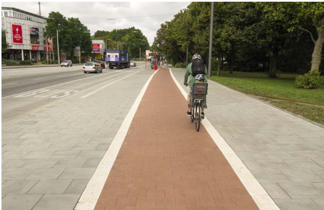
Bild 95: Kollaustraße, Ausbau und Verbreiterung des Radwegs
