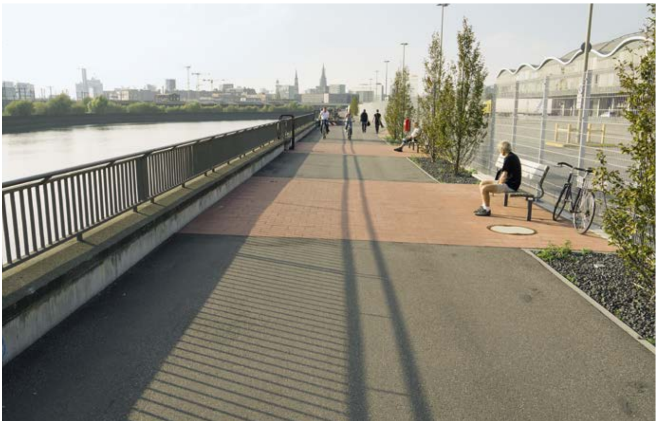
Bild 60: Radweg entlang Oberhafen / Großmarkt (Freizeitrouten 5, 6, Elberadweg, Radfernweg Hamburg – Rügen), Neubau einer Promenade auf der Hochwasserschutzanlage einschließlich zweier Brücken, Ausstattung mit Bäumen und Bänken
