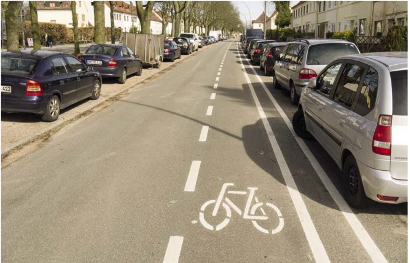
Bild 125: Ebertallee, Schutzstreifen im Rahmen der EMS-Maßnahme
