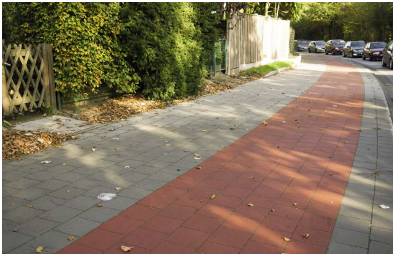
Bild 111: Binnenfeldredder, Ausbau und Verbreiterung des Radwegs
