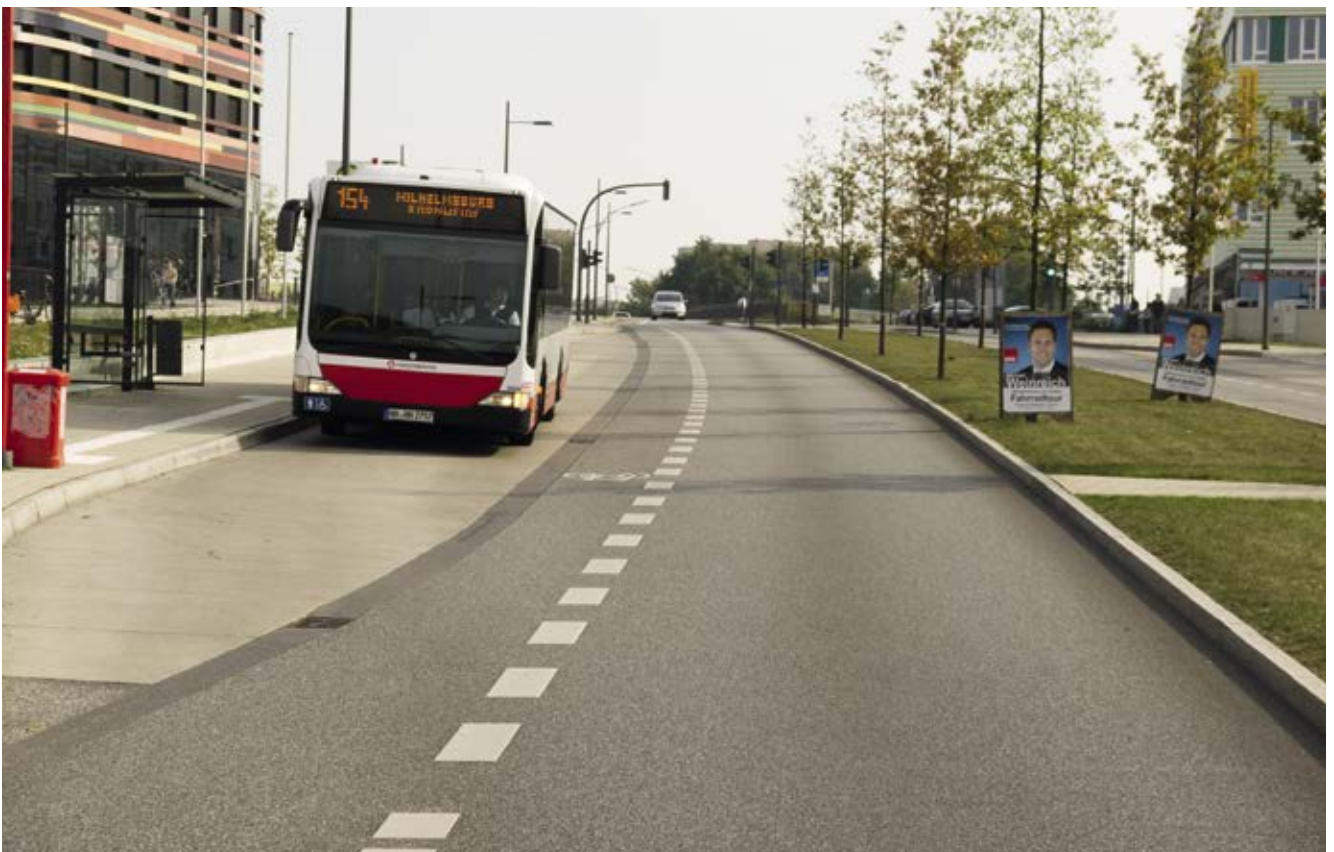
Bild 122: Neuenfelder Straße, Radfahrstreifen zwischen Kfz-Fahrtstreifen und Bushaltestelle
