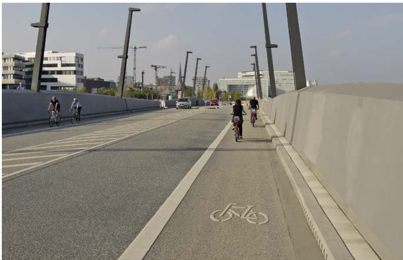
Bild 120: Grandeswerderstraße (Baakenhafenbrücke), Radfahrstreifen
