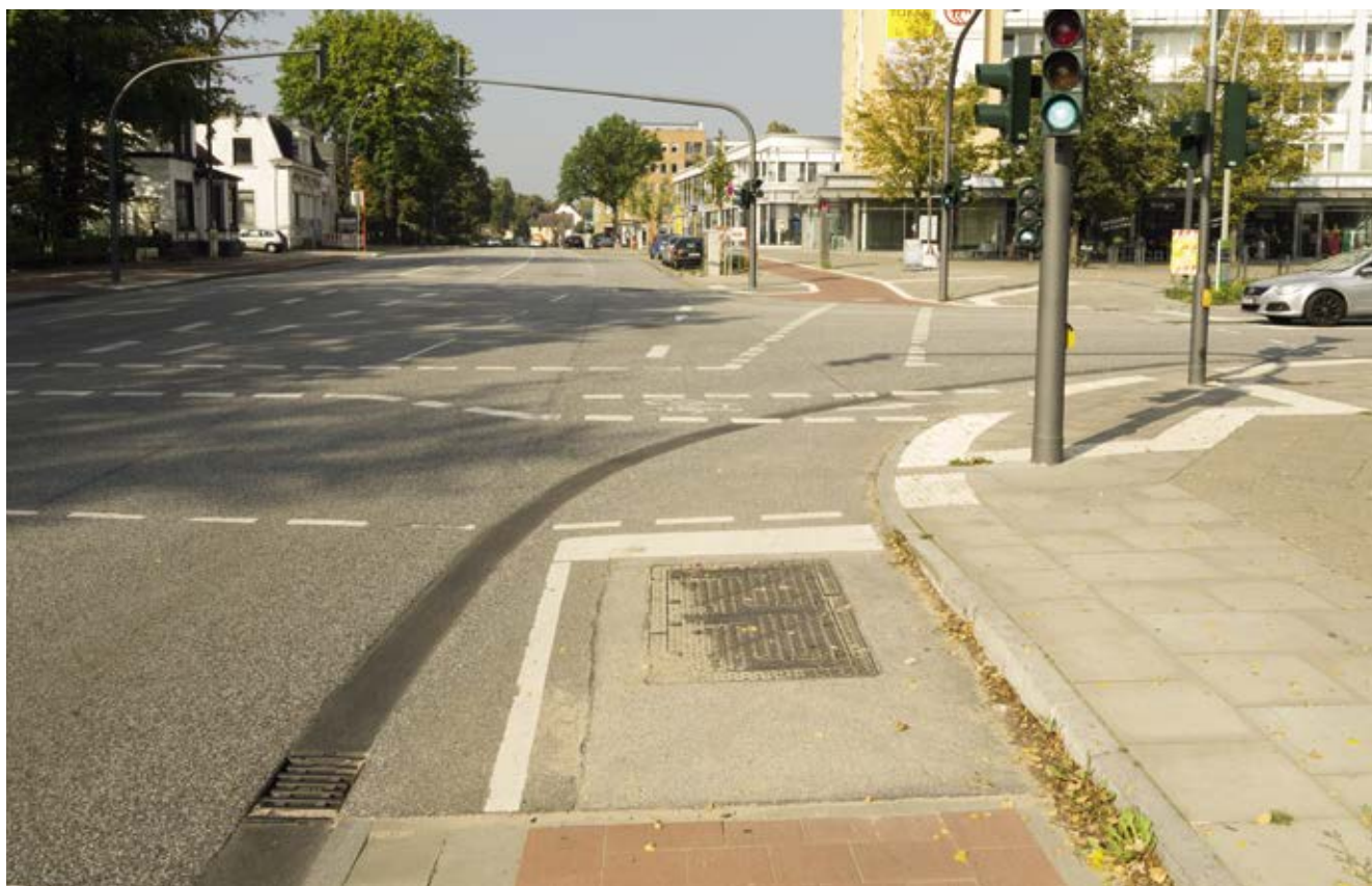
Bild 80: Luruper Hauptstraße / Eckhoffplatz, Ausbau und Verbreiterung des Radwegs, „Berliner Lösung“ ohne Konflikte mit wartenden Fußgängern
