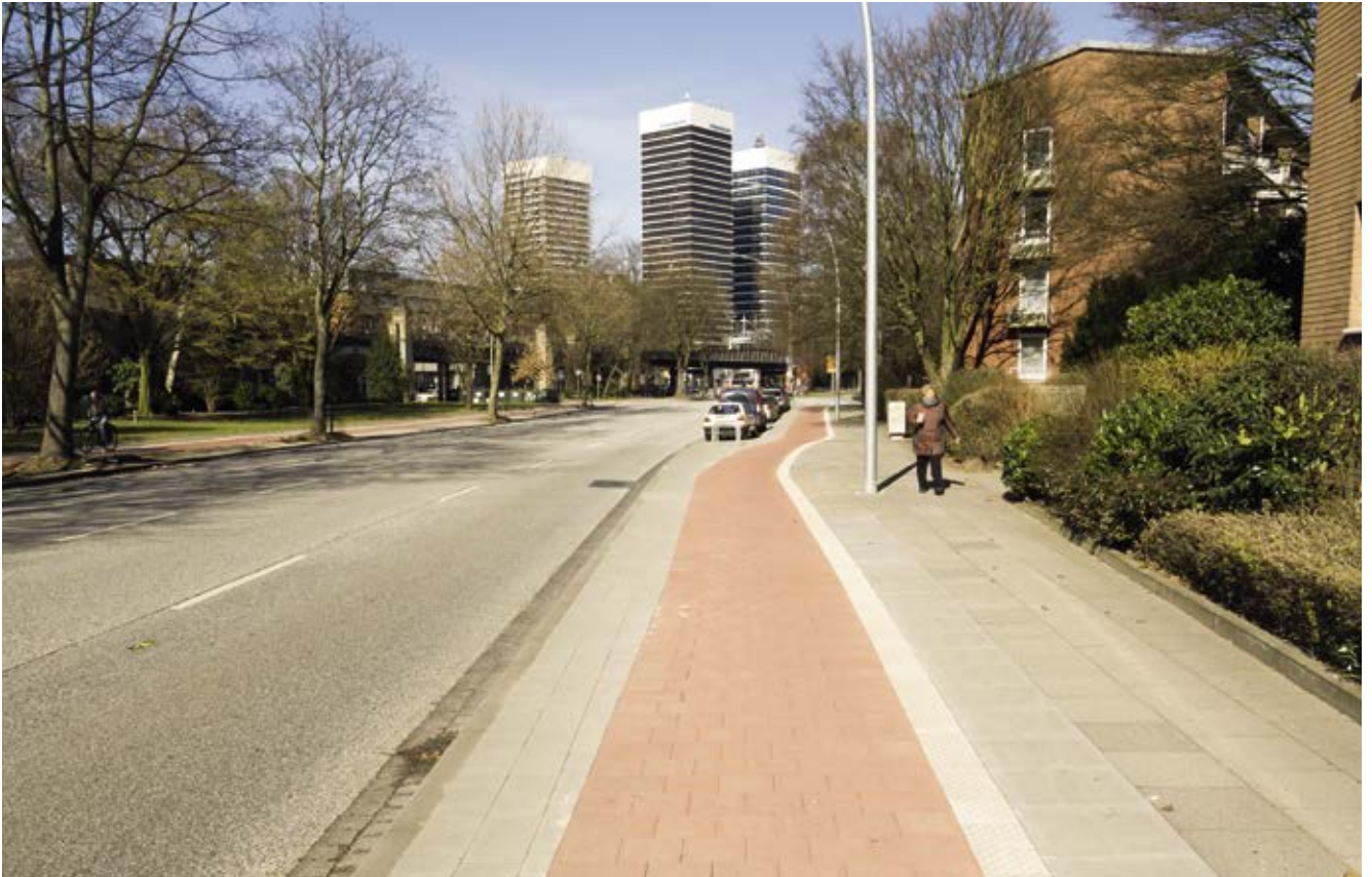
Bild 105: Schürbeker Straße, Ausbau und Verbreiterung der Radwege
