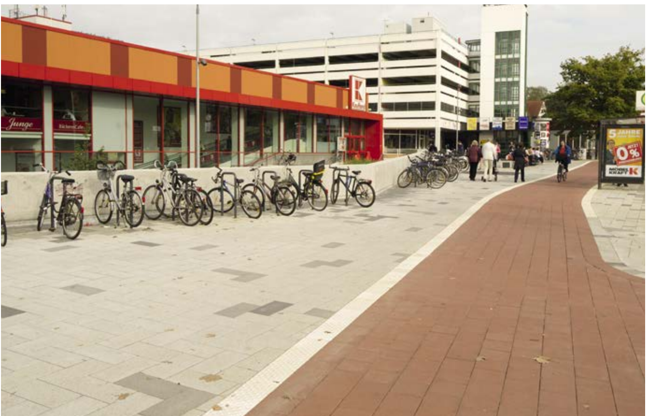
Bild 106: Tangstedter Landstraße, Ausbau und Verbreiterung des Radwegs sowie Aufstellung von Fahrradbügeln
