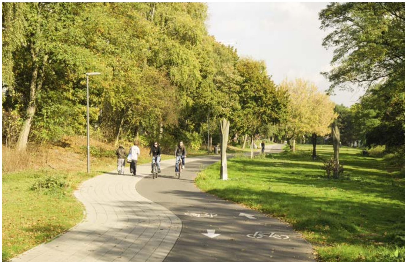
Bild 31: Oben Borgfelde (Veloroute 8, Freizeitroute 4), Ausbau des selbstständig geführten getrennten Geh- und Radweges, Ausstattung mit öffentlicher Beleuchtung und Sitzbänken
