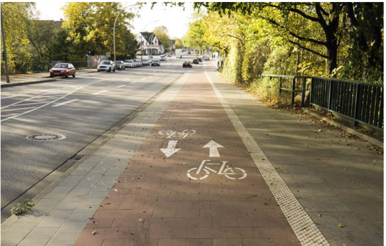
Bild 110: Scharbeutzer Straße, Ausbau und Verbreiterung des Radwegs im Rahmen der EMS-Maßnahme
