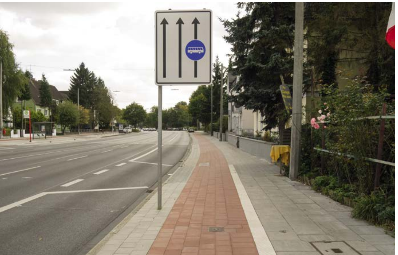
Bild 94: Kollaustraße, Ausbau und Verbreiterung des Radwegs
