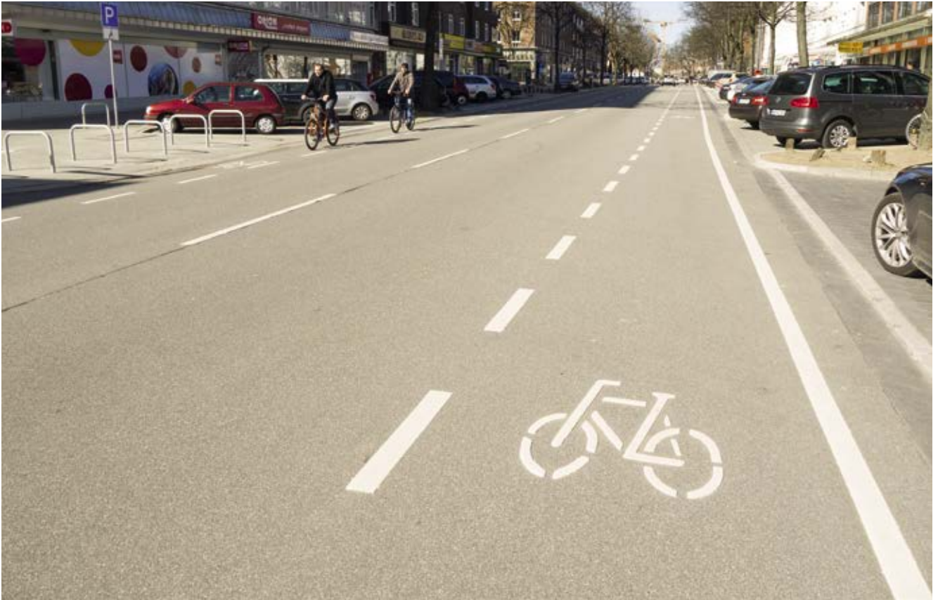
Bild 141: Fuhlsbüttler Straße, Schutzstreifen und Aufstellung von Fahrradbügeln im Rahmen der Busoptimierung
