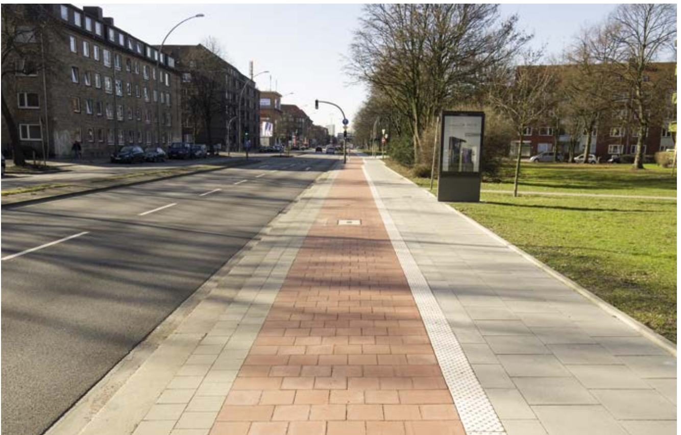
Bild 78: Eiffestraße, Ausbau und Verbreiterung des Radwegs
