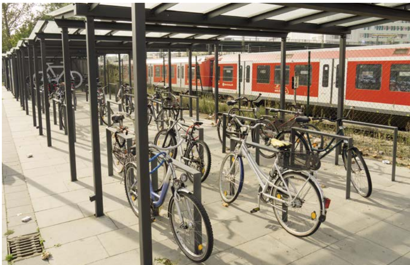
Bild 183: Überdachte Bike-Ride-Anlage an der S-Bahn-Haltestelle Wilhelmsburg
