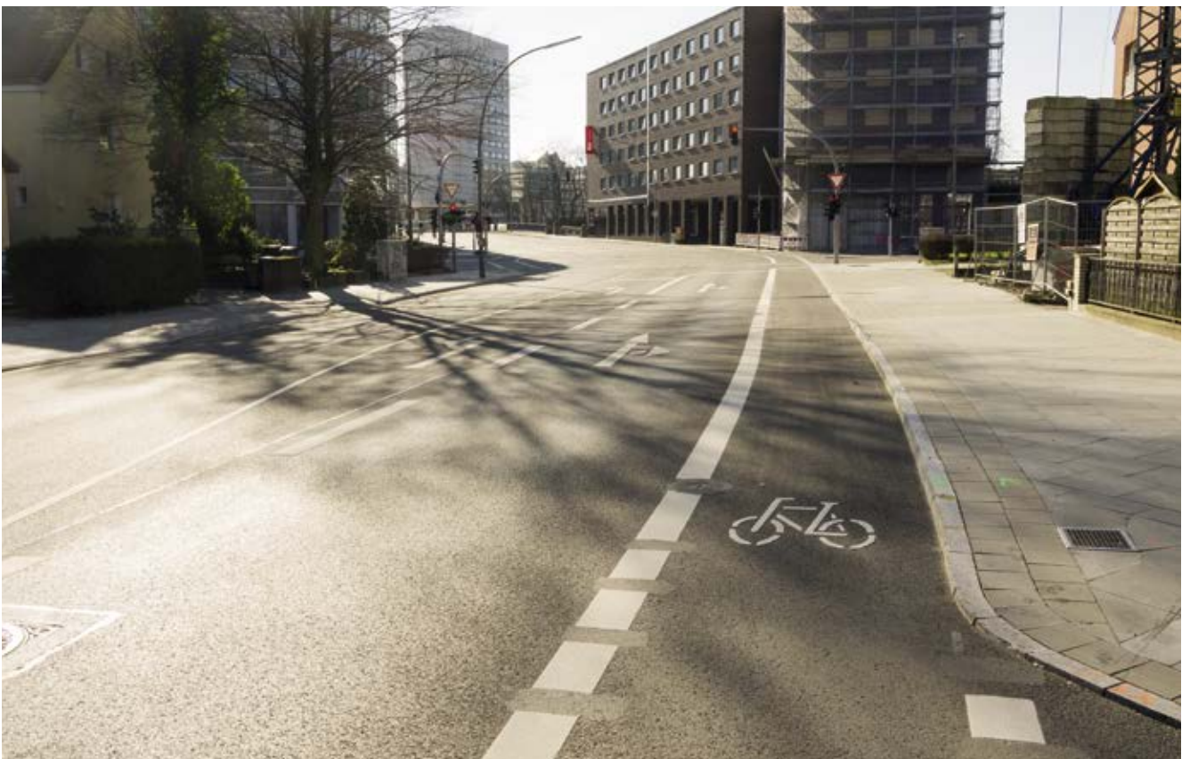
Bild 18: Bärenallee (Veloroute 7) / Hammer Straße, Radfahrstreifen
