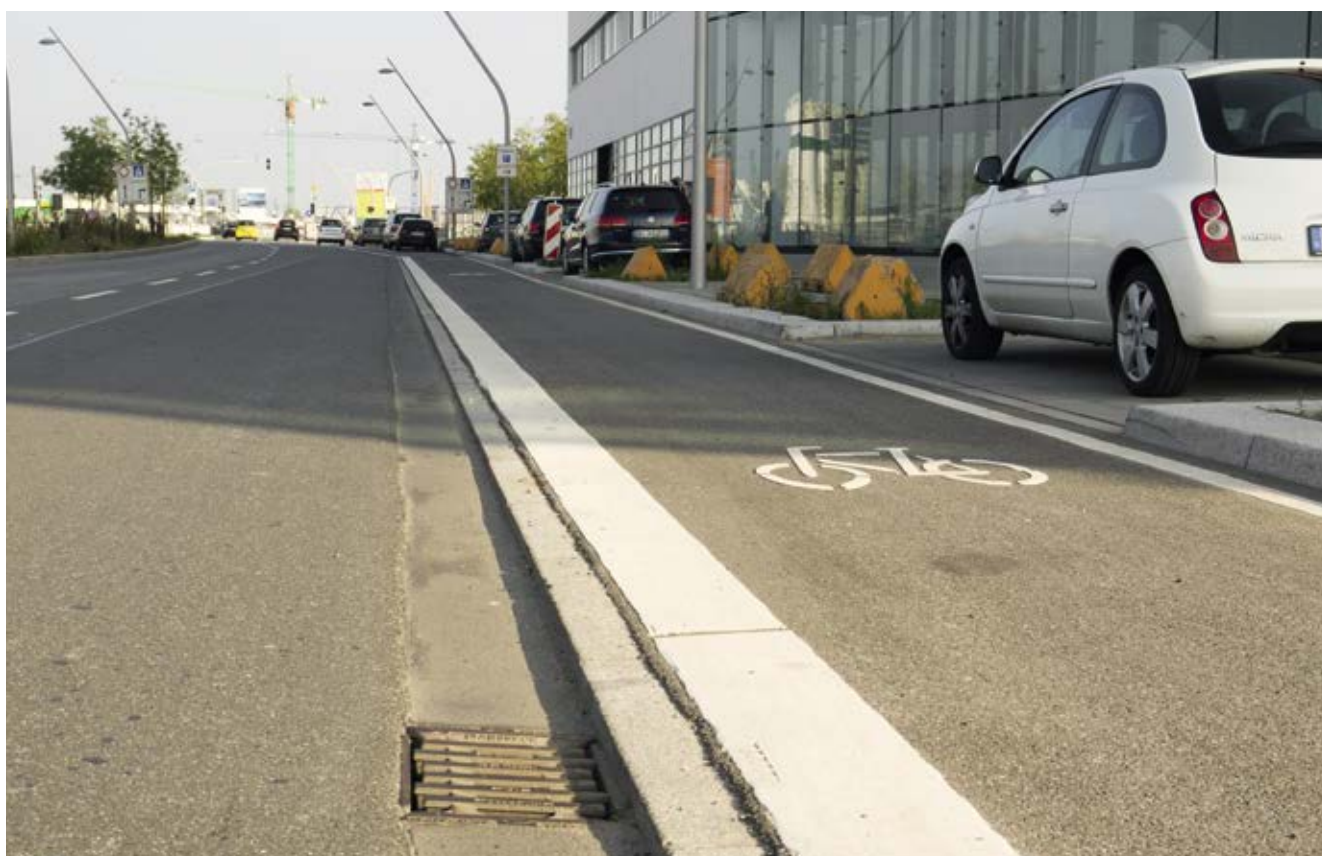
Bild 36: Überseeallee (Veloroute 10), Radfahrstreifen mit Bordkante
