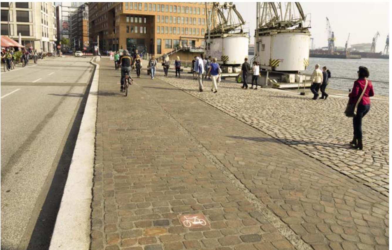
Bild 70: Große Elbstraße (Freizeitroute 8, Elberadweg, Nordseeküstenradweg) / Am Altonaer Holzhafen, Bau eines getrennten Geh- und Radwegs mit geschnittenem Großpflaster zur gestalterischen Einbindung in die Umgebung
