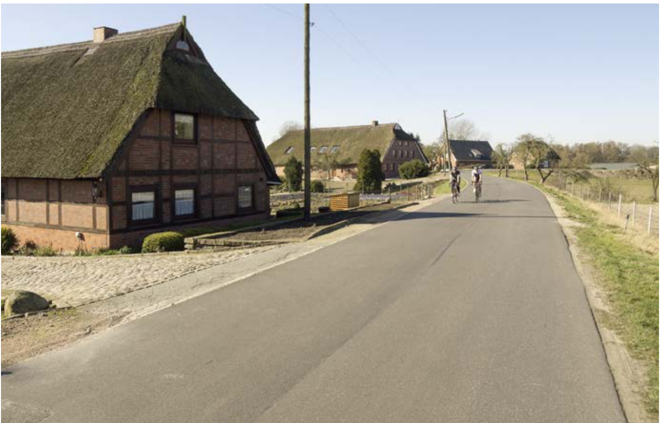
Bild 74: Ochsenwerder Norderdeich (Rosentour), Fahrbahnsanierung
