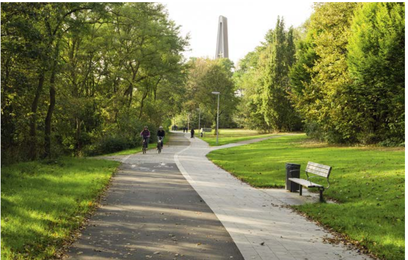
Bild 34: Grünzug Hammer Kirche (Veloroute 8, Freizeitroute 4), Ausbau des selbstständig geführten getrennten Geh- und Radweges, Ausstattung mit öffentlicher Beleuchtung und Sitzbänken
