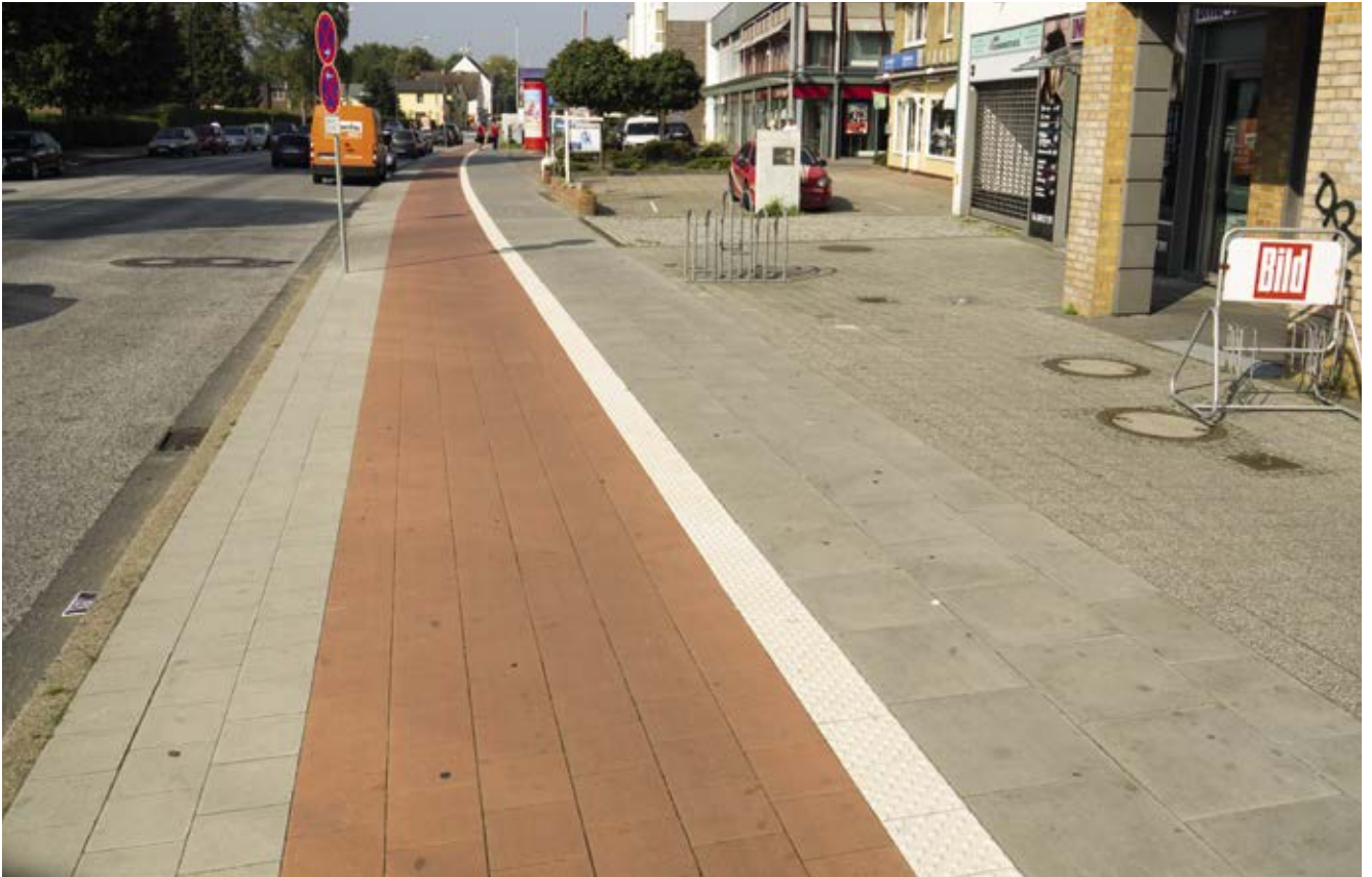
Bild 81: Luruper Hauptstraße, Ausbau und Verbreiterung des Radwegs
