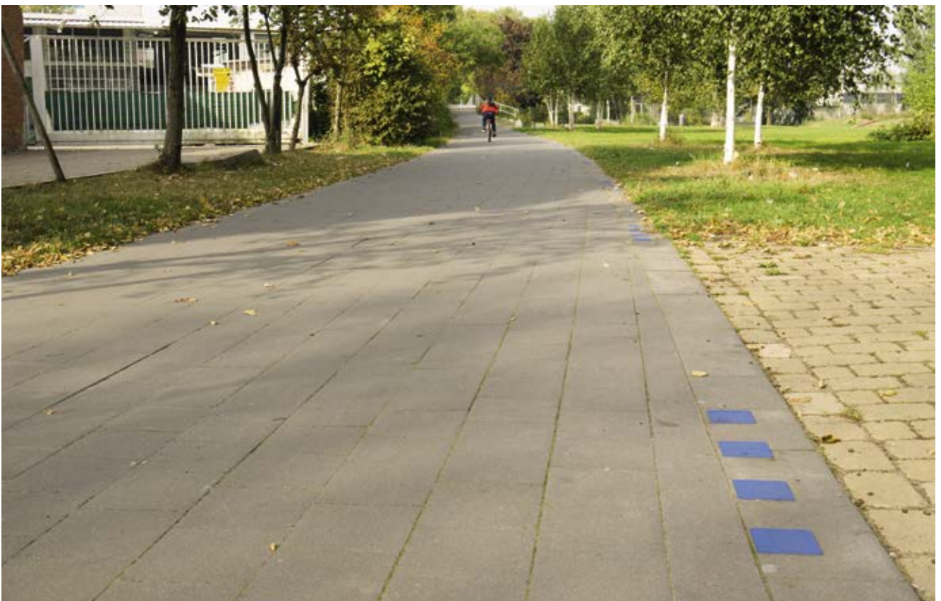
Bild 50: Gert-Schwämmle-Weg (LOOP Wilhelmsburg, Blickrichtung Veringkanal), Ausbau und Verbreiterung des Weges
