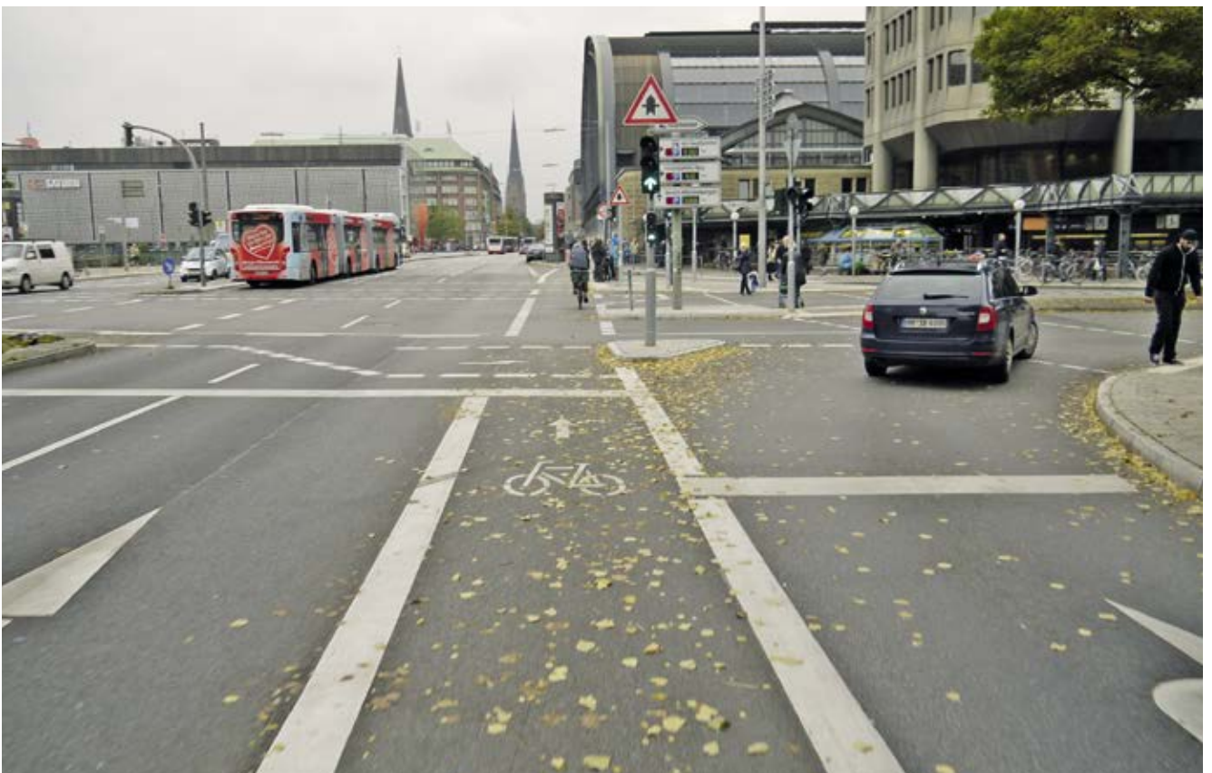
Bild 22 Steintordamm (Velorouten 7, 8) / Kirchenallee, geradlinige Radverkehrsführung
