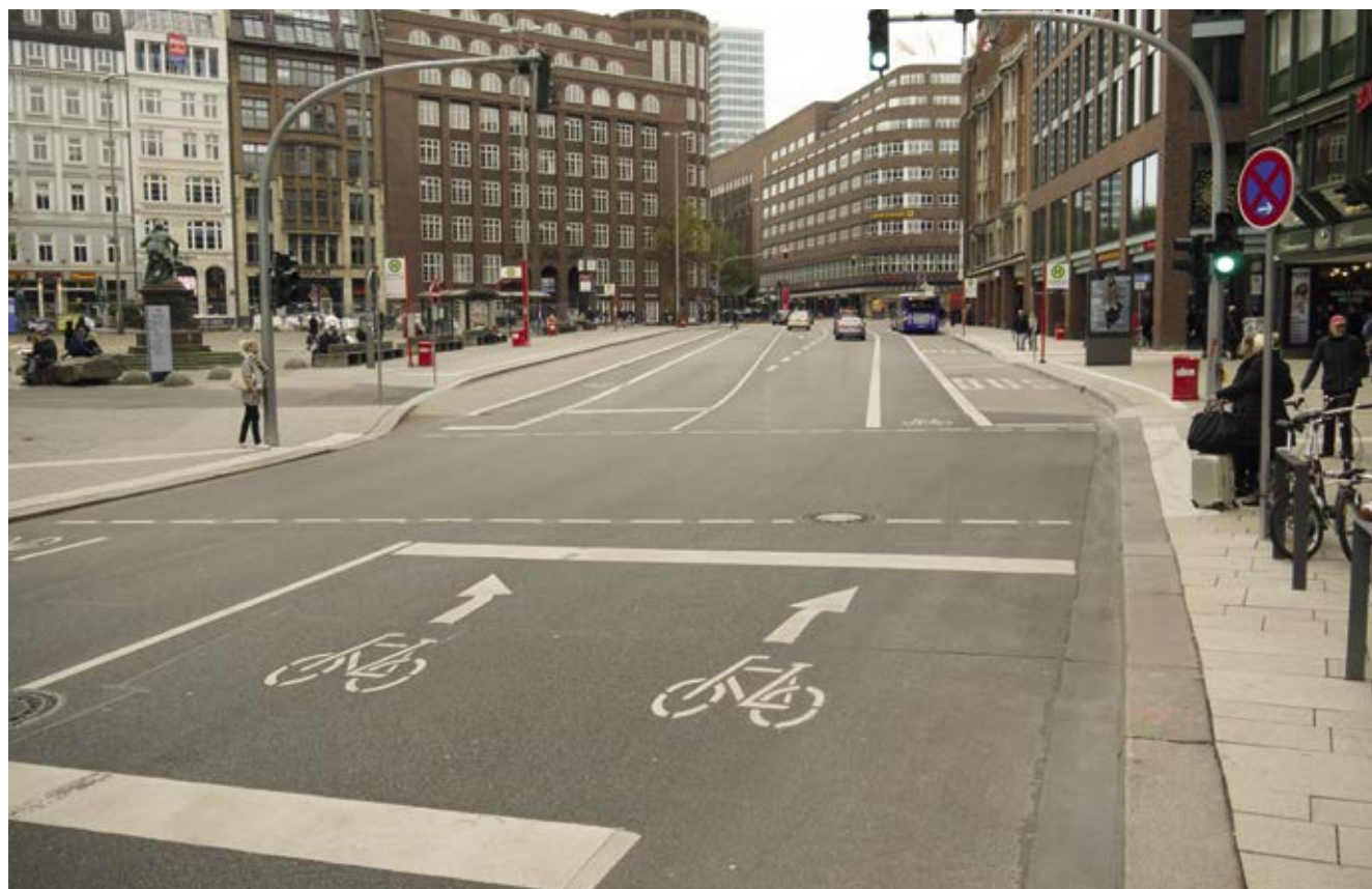
Bild 3: Jungfernstieg / Gänsemarkt (Veloroute 3), aufgeweiteter Radaufstellstreifen
