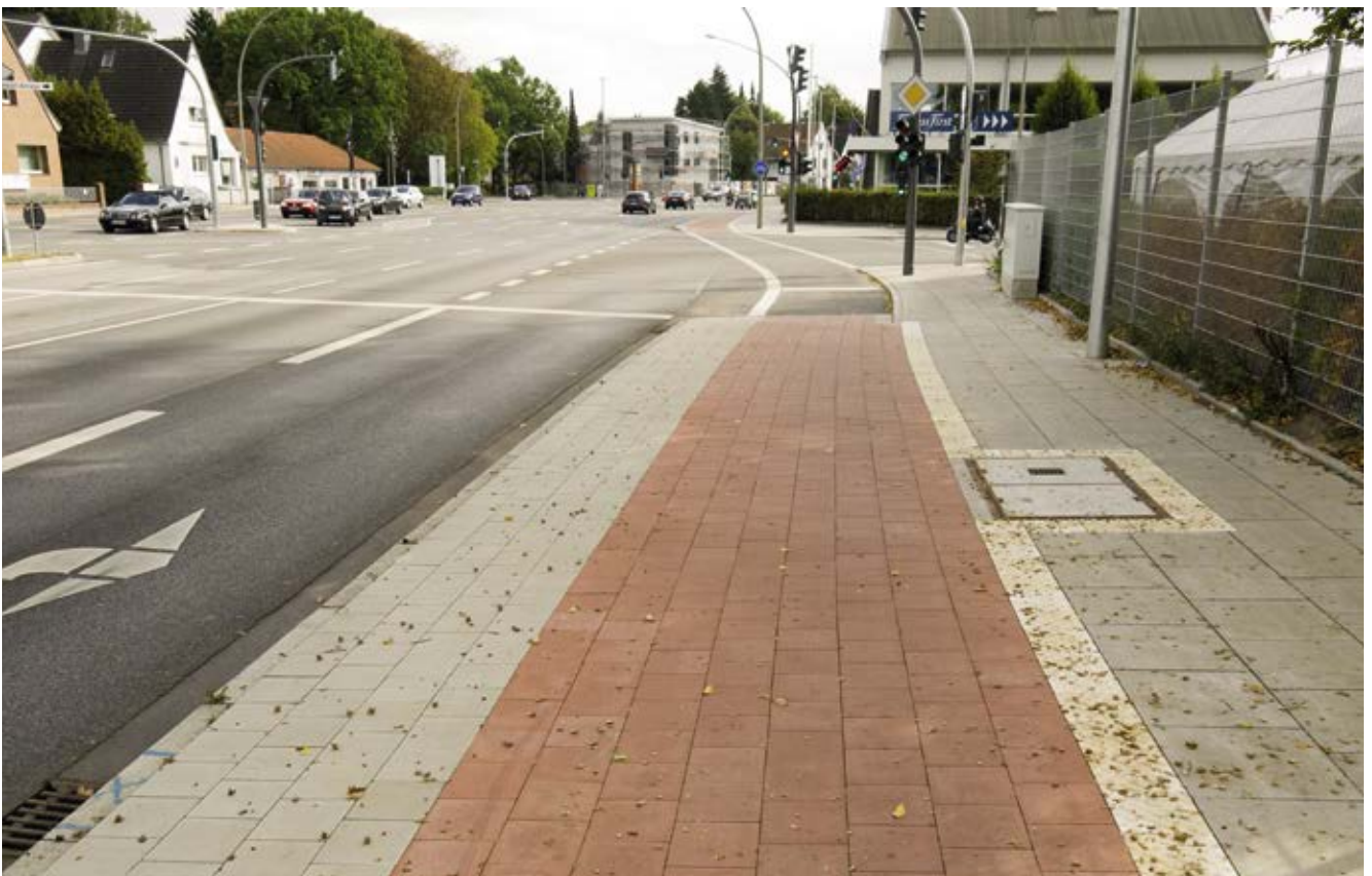
Bild 98: Kollaustraße / Niendorfer Straße, Ausbau und Verbreiterung des Radwegs, „Berliner Lösung“ ohne Konflikte mit wartenden Fußgängern
