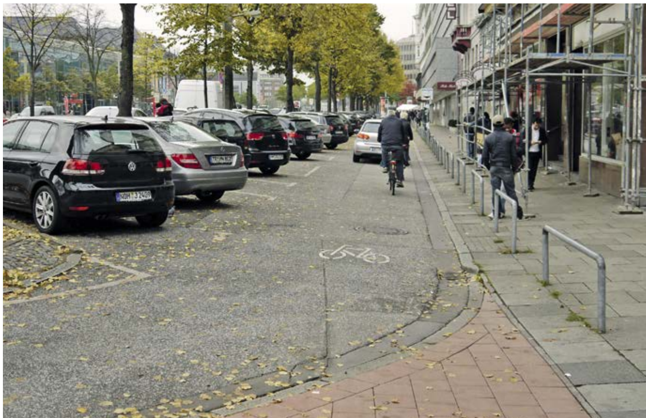
Bild 23: Adenauerallee (Veloroute 8), Schaffung einer Ableitung und Nutzung der nördlichen Nebenfahrbahn für Radverkehr, Aufgabe des Radwegs
