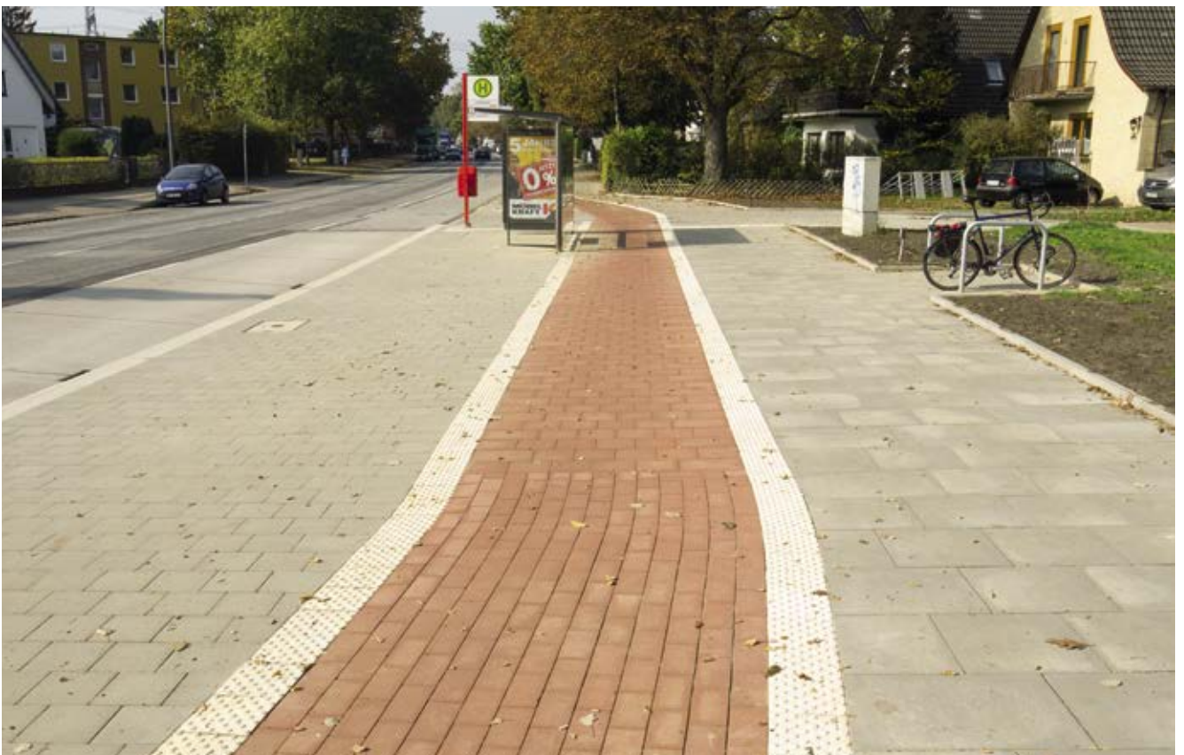
Bild 82: Luruper Hauptstraße, Ausbau und Verbreiterung des Radwegs und Aufstellung von Fahrradbügeln im Rahmen des Bushaltestellenausbaus
