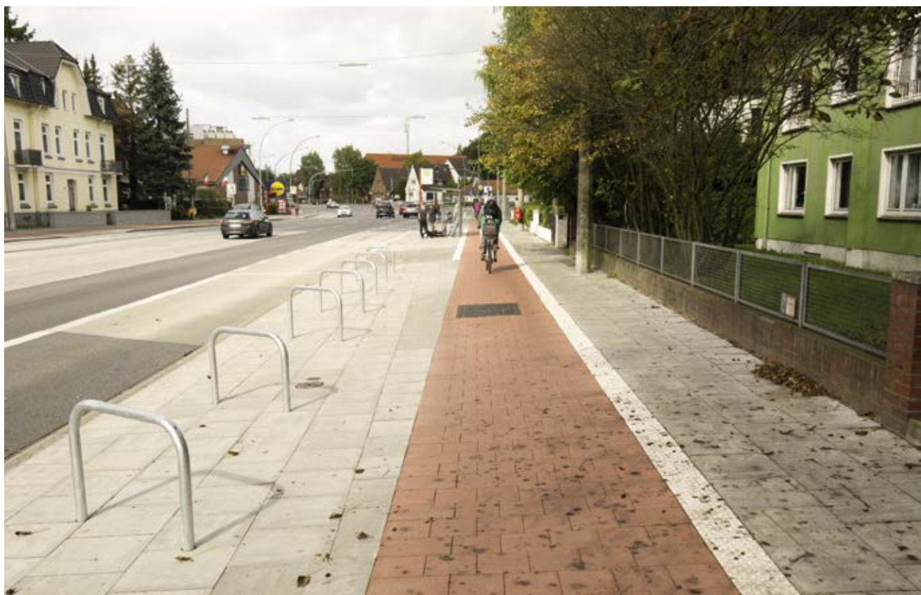
Bild 96: Kollaustraße, Ausbau und Verbreiterung des Radwegs sowie Aufstellung von Fahrradbügeln im Rahmen des Bushaltestellenausbaus
