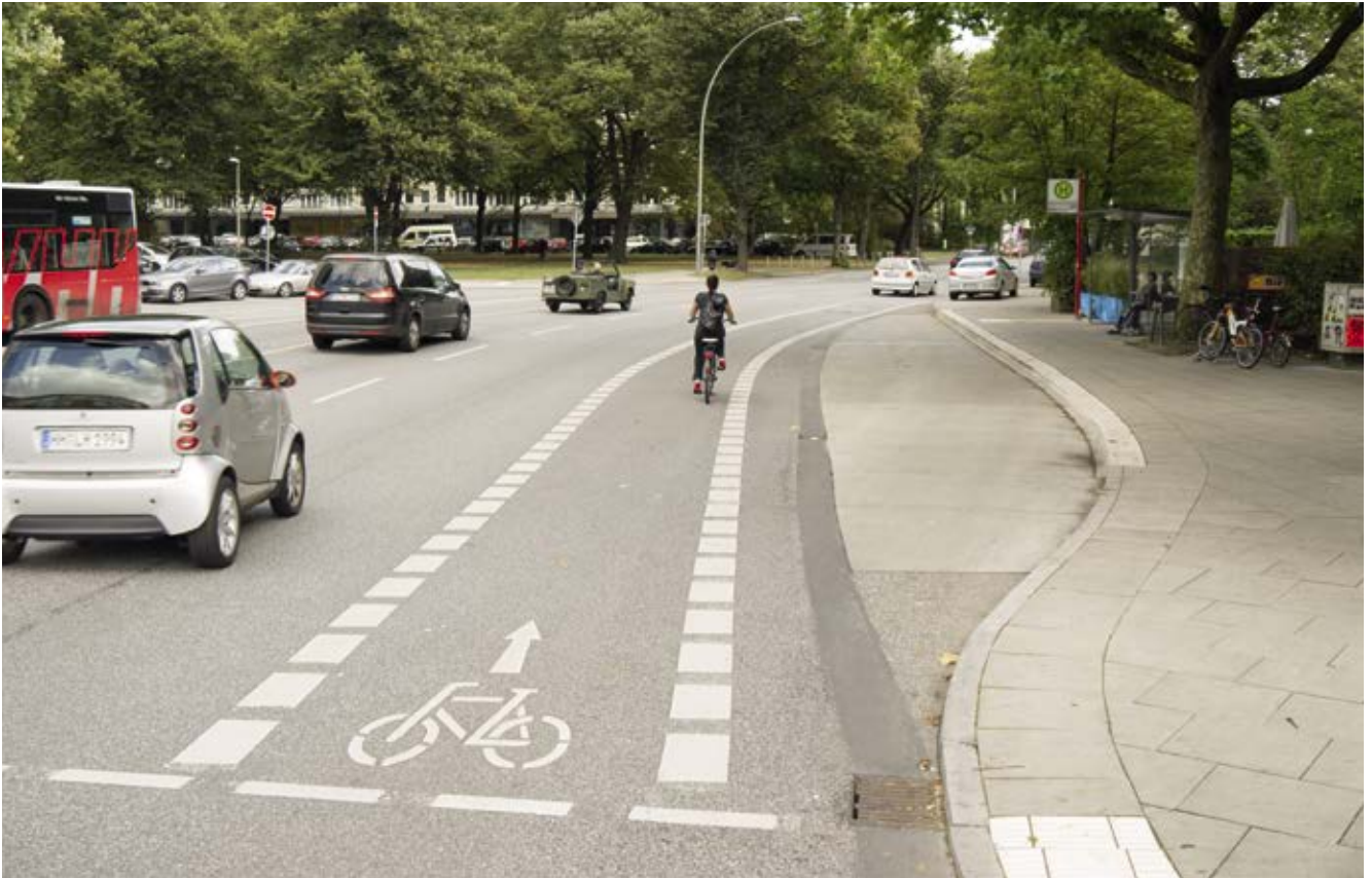
Bild 129: Hallerstraße, Radfahrstreifen zwischen Kfz-Fahrstreifen und Bushaltestelle im Rahmen der Busoptimierung
