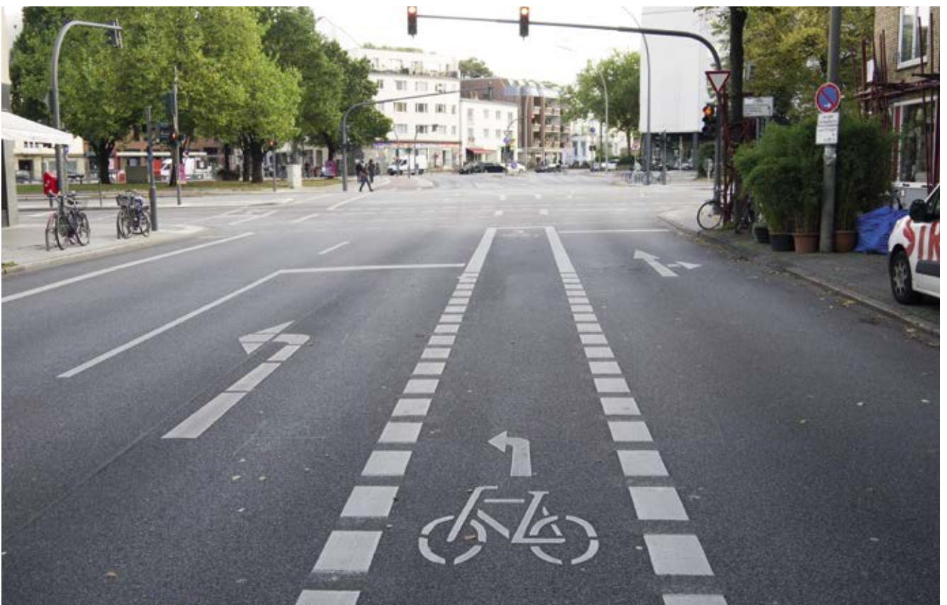
Bild 10: Bogenstraße (Veloroute 3) / Beim Schlump. Linksabbiegestreifen für Radverkehr im Verlauf der Veloroute Richtung Rutschbahn
