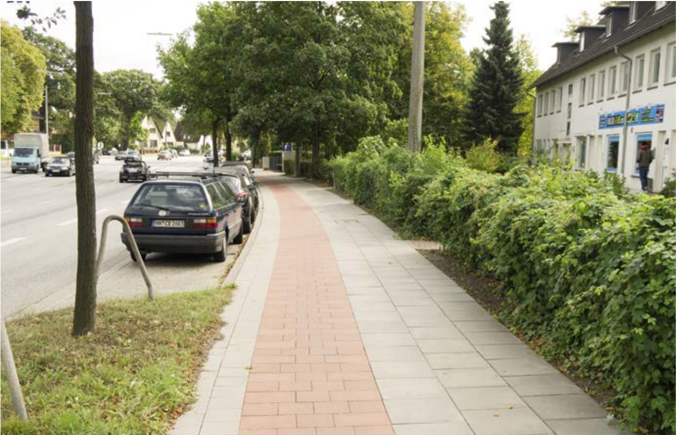
Bild 93: Kollaustraße, Ausbau des Radwegs (Engstelle)
