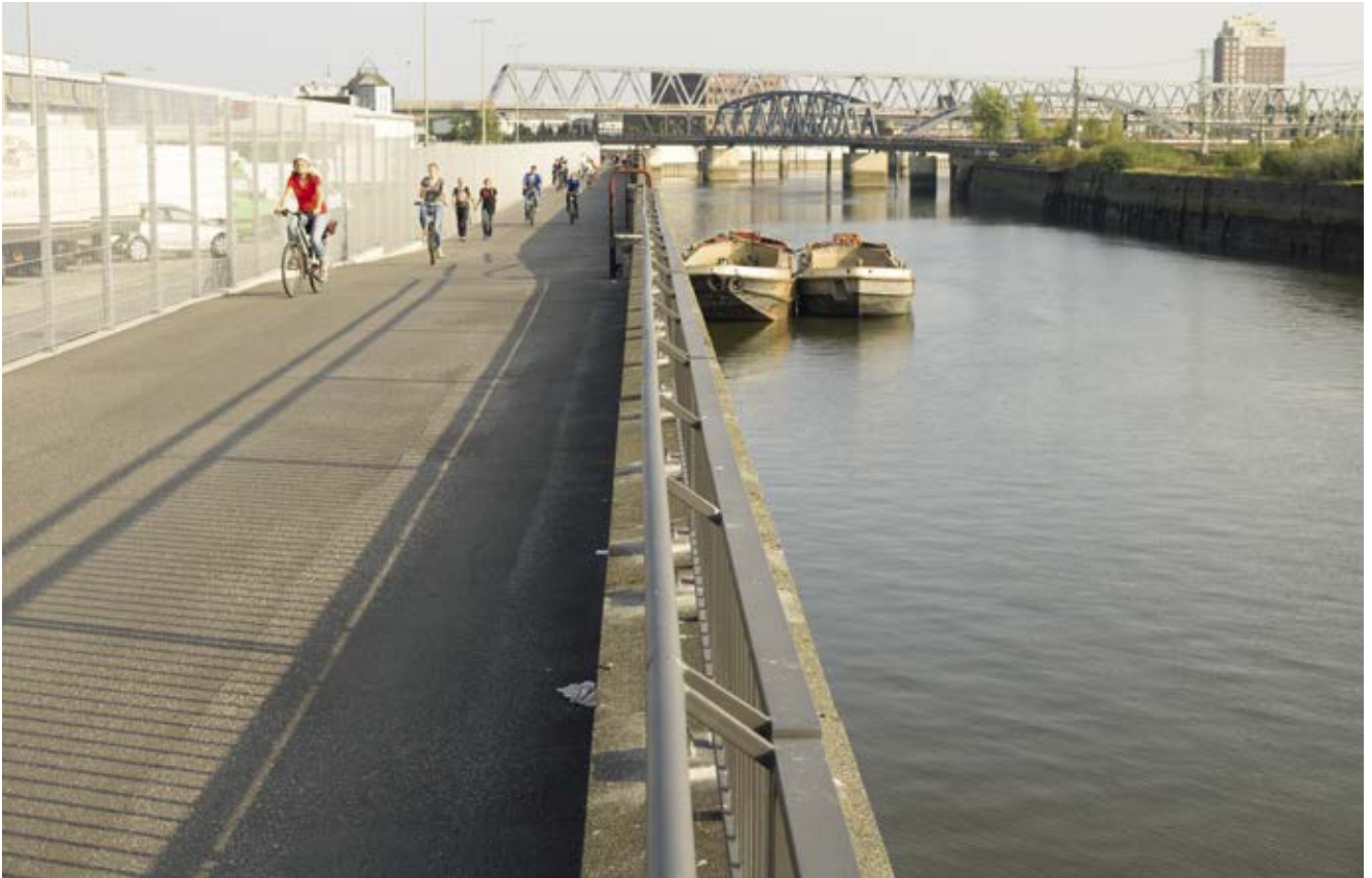
Bild 61: Radweg entlang Oberhafen / Großmarkt (Freizeitrouuten 5, 6, Elberadweg, Radfernweg Hamburg – Rügen), Neubau einer Promenade auf der Hochwasserschutzanlage einschließlich zweier Brücken
