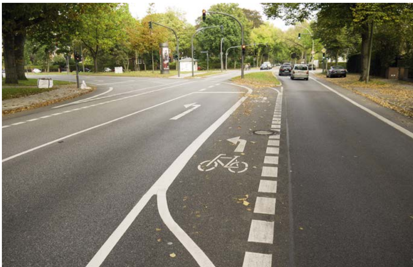
Bild 16: Bebelallee / Rathenaustraße (Veloroute 4), Linksabbiegestreifen für Radverkehr im Verlauf der Veloroute
