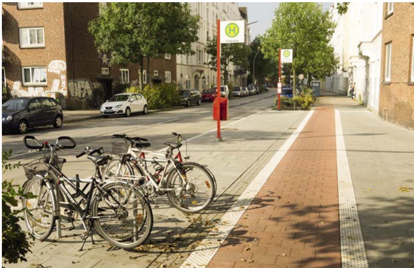
Bild 79: Bahrenfelder Steindamm, Ausbau und Verbreiterung des Radwegs und Aufstellung von Fahrradbügeln im Rahmen des Bushaltestellenausbaus
