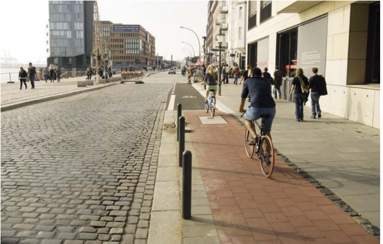
Bild 69: Große Elbstraße (Freizeitroute 8, Elberadweg, Nordseeküstenradweg) / Carsten-Rehder-Straße, Überleitung des Radwegs stadtauswärts in Schutzstreifen
