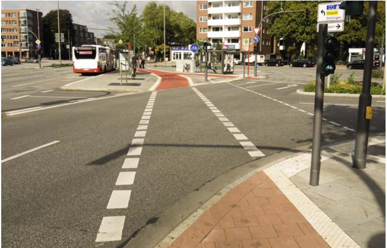
Bild 87: Lokstedter Steindamm / Siemersplatz, Umgestaltung der Radverkehrsanlagen und verbesserte Radverkehrsführung im Rahmen der Busoptimierung
