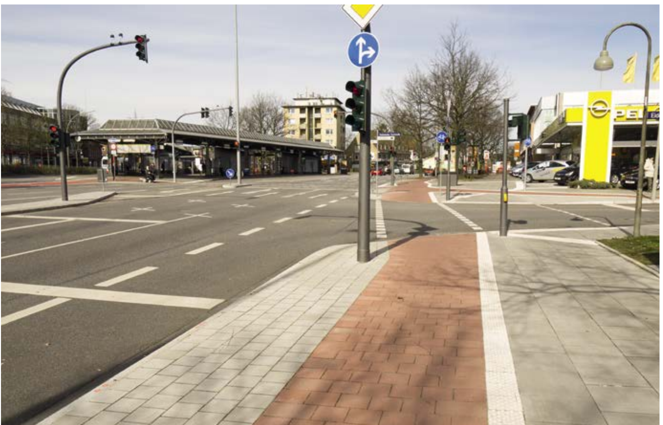
Bild 102: Eidelstedter Platz, Ausbau und Verbreiterung des Radwegs im Rahmen der Busoptimierung
