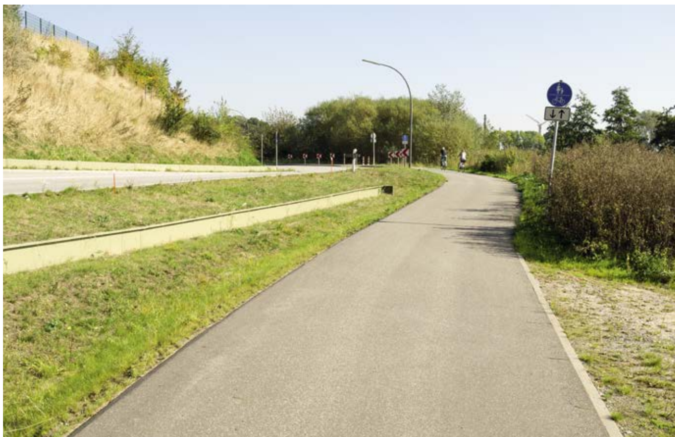
Bild 116: An der Alten Süderelbe (Umgehung Finkenwerder, Freizeitroute 11), Bau eines gemeinsamen Geh- und Radwegs
