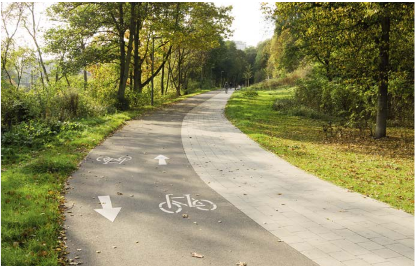
Bild 30: Oben Borgfelde (Veloroute 8, Freizeitroute 4), Ausbau des selbstständig geführten getrennten Geh- und Radweges, Ausstattung mit öffentlicher Beleuchtung und Sitzbänken
