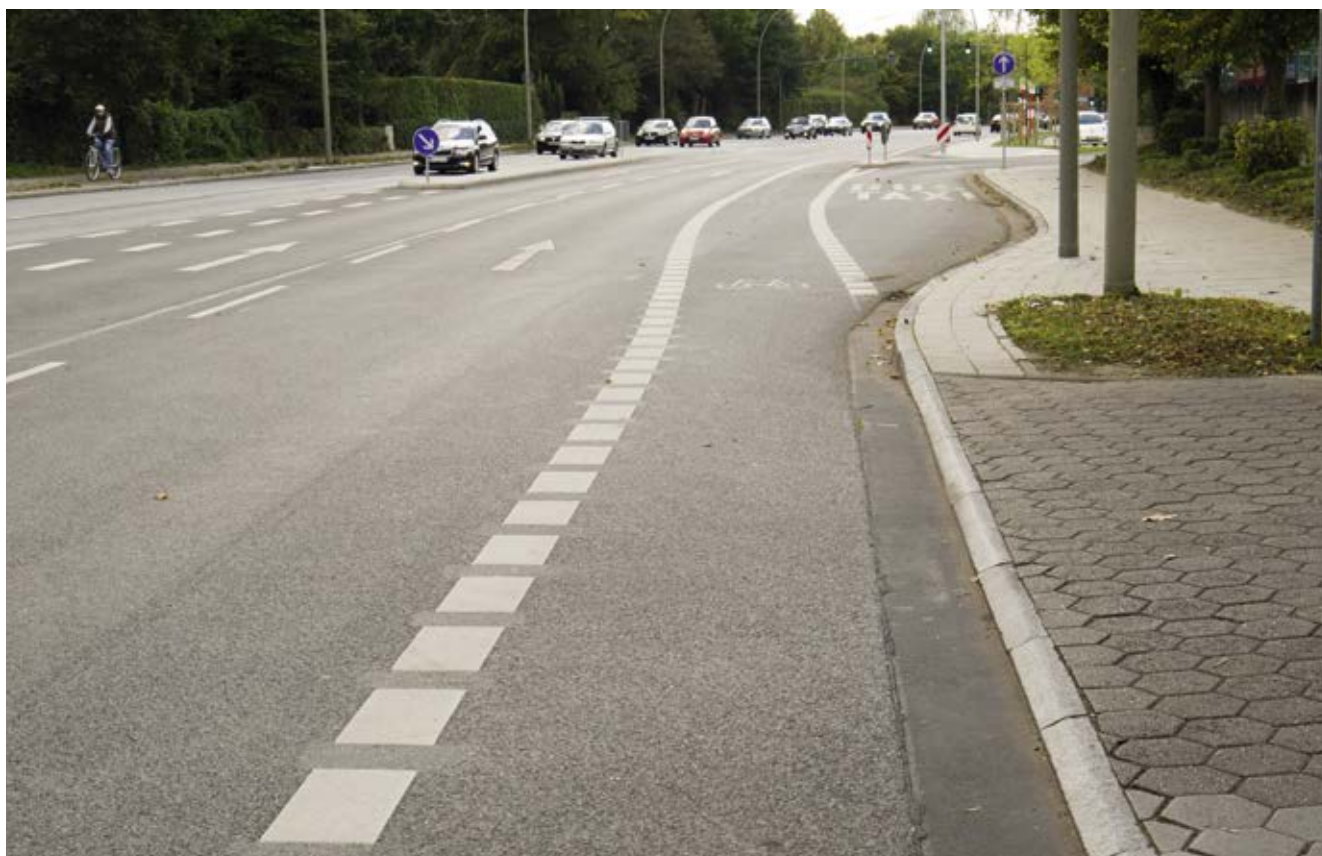
Bild 132 Garstedter Weg, Radfahrstreifen im Rahmen der Busoptimierung
