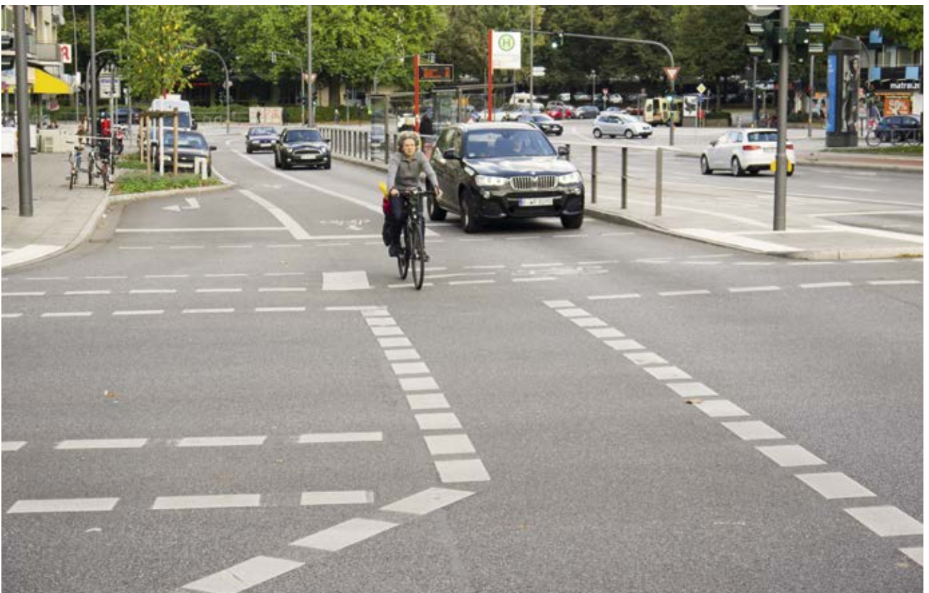
Bild 126: Beim Schlump, Radfahrstreifen zwischen Geradeaus- und Rechtsabbiegefahrstreifen im Rahmen der Busoptimierung
