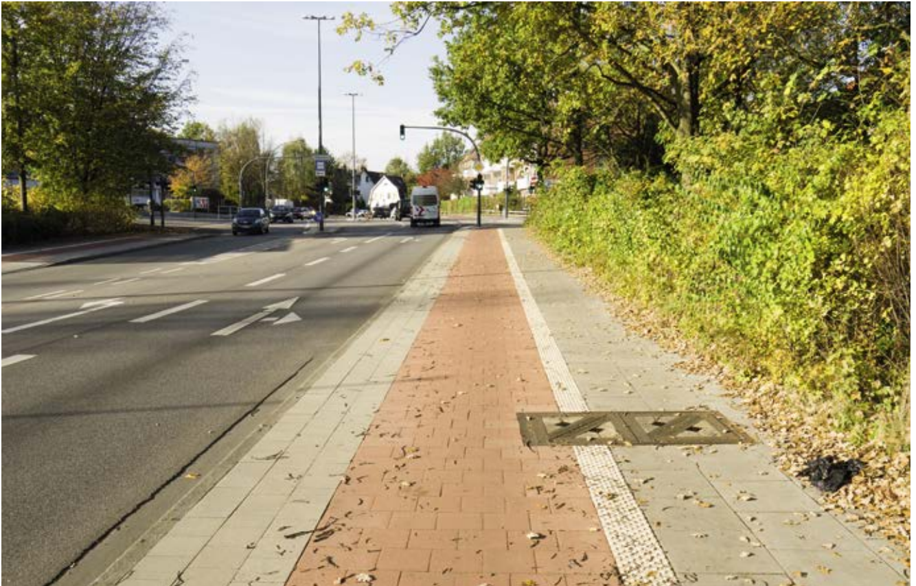
Bild 109: Rahlstedter Bahnhofstraße, Ausbau und Verbreiterung des Radwegs im Rahmen der EMS-Maßnahme
