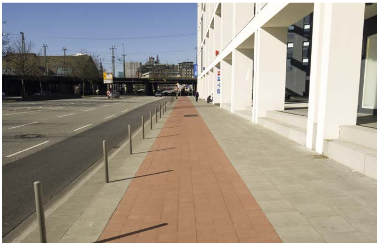
Bild 76: Amsinckstraße, Ausbau und Verbreiterung des Radwegs
