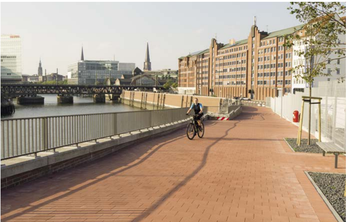
Bild 58: Radweg entlang Oberhafen / Großmarkt (Freizeitroutes 5, 6, Elberadweg, Radfernweg Hamburg – Rügen), Neubau einer Promenade auf der Hochwasserschutzanlage einschließlich zweier Brücken, Ausstattung mit Bäumen und Bänken
