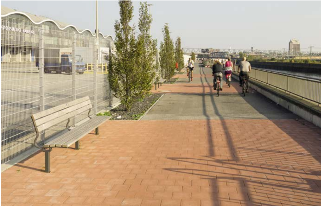
Bild 59: Radweg entlang Oberhafen / Großmarkt (Freizeitrouten 5, 6, Elberadweg, Radfernweg Hamburg – Rügen), Neubau einer Promenade auf der Hochwasserschutzanlage einschließlich zweier Brücken, Ausstattung mit Bäumen und Bänken
