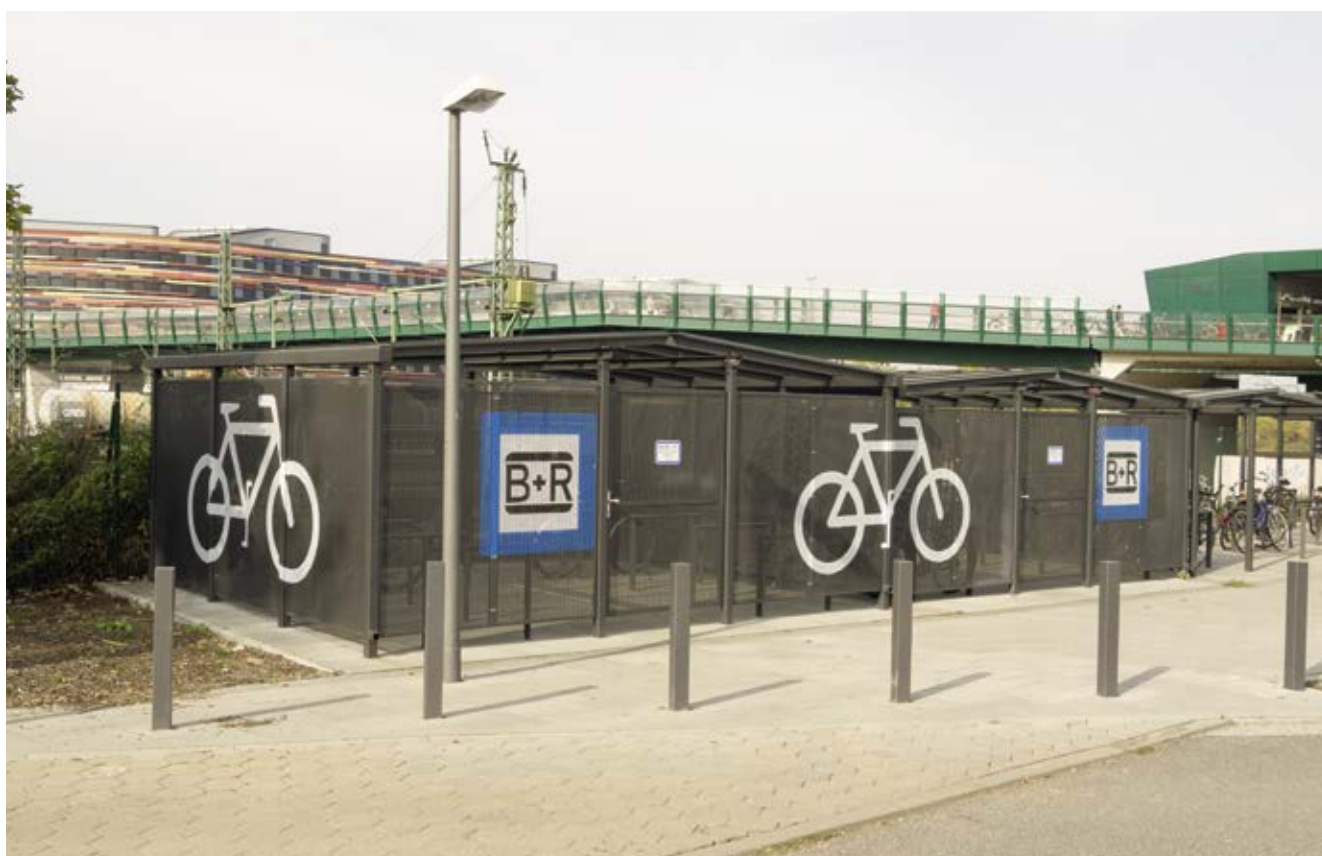
Bild 184: Bike+Ride-Sammelschließanlage an der S-Bahn-Haltestelle Wilhelmsburg
