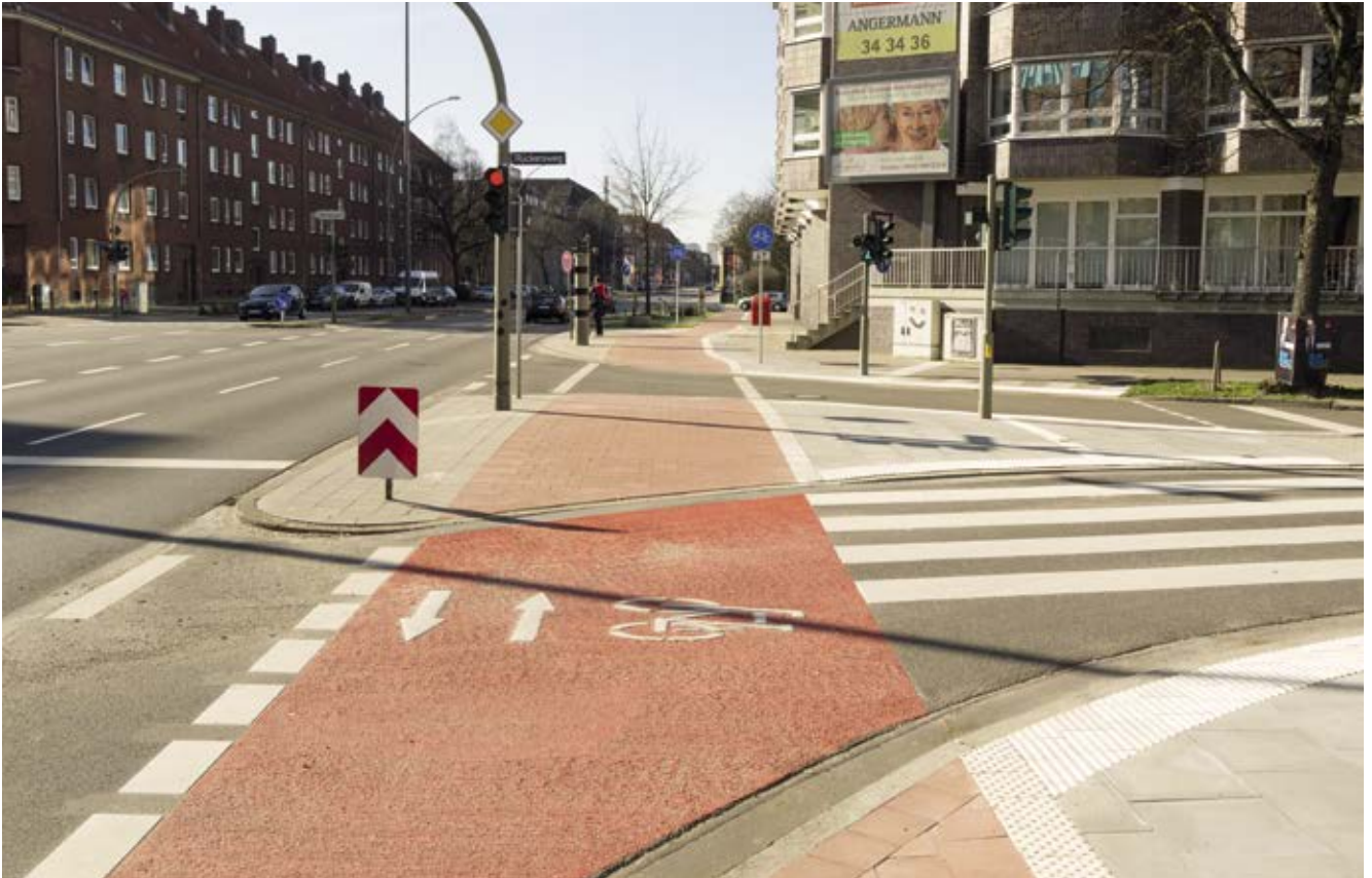
Bild 77: Eiffestraße / Rückersweg, Ausbau und Verbreiterung des Radwegs, geradlinige Radverkehrsführung im Knoten
