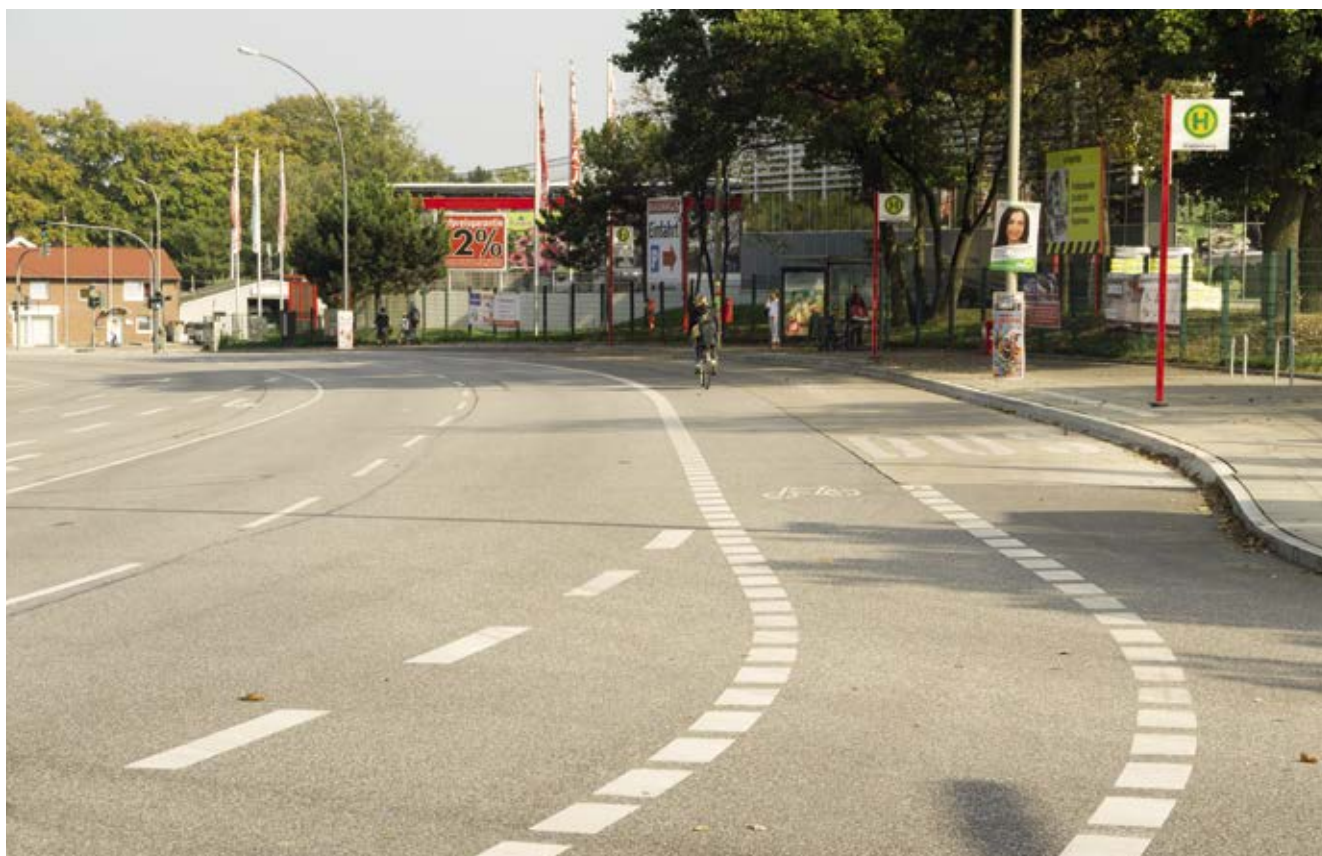
Bild 48: Rugenbarg (Veloroute 14), Radfahrstreifen zwischen Kfz-Fahrstreifen und Bushaltestelle
