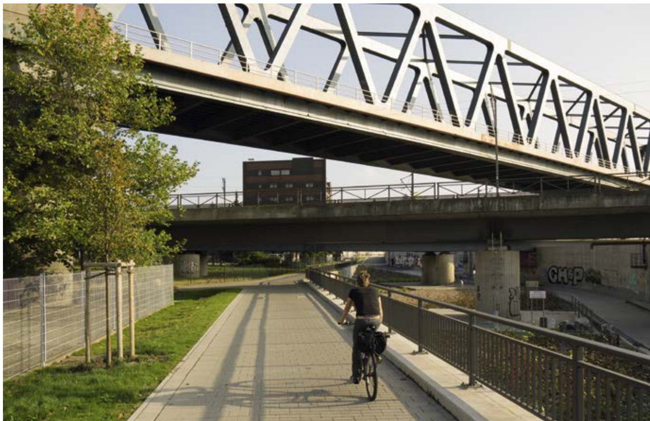
Bild 63: Radweg entlang Oberhafen / Großmarkt (Freizeitrouten 5, 6, Elberadweg, Radfernweg Hamburg – Rügen), Neubau einer Promenade auf der Hochwasserschutzanlage
