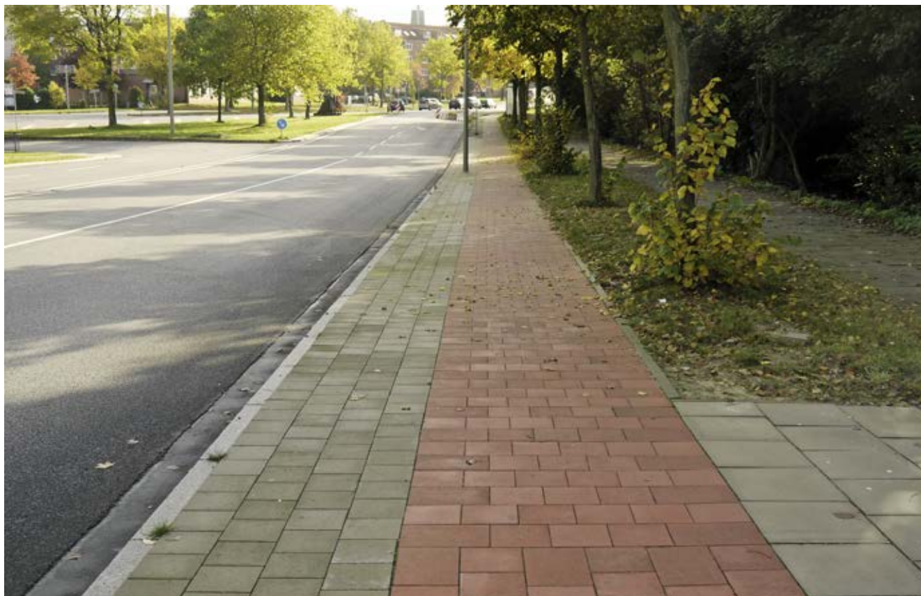
Bild 29: Billhorner Röhrendamm westlich Billhorner Mühlenweg (Veloroute 9, Freizeitroute 5, Elberadweg, Radfernweg Hamburg – Rügen), Ausbau und Verbreiterung des Radweges
