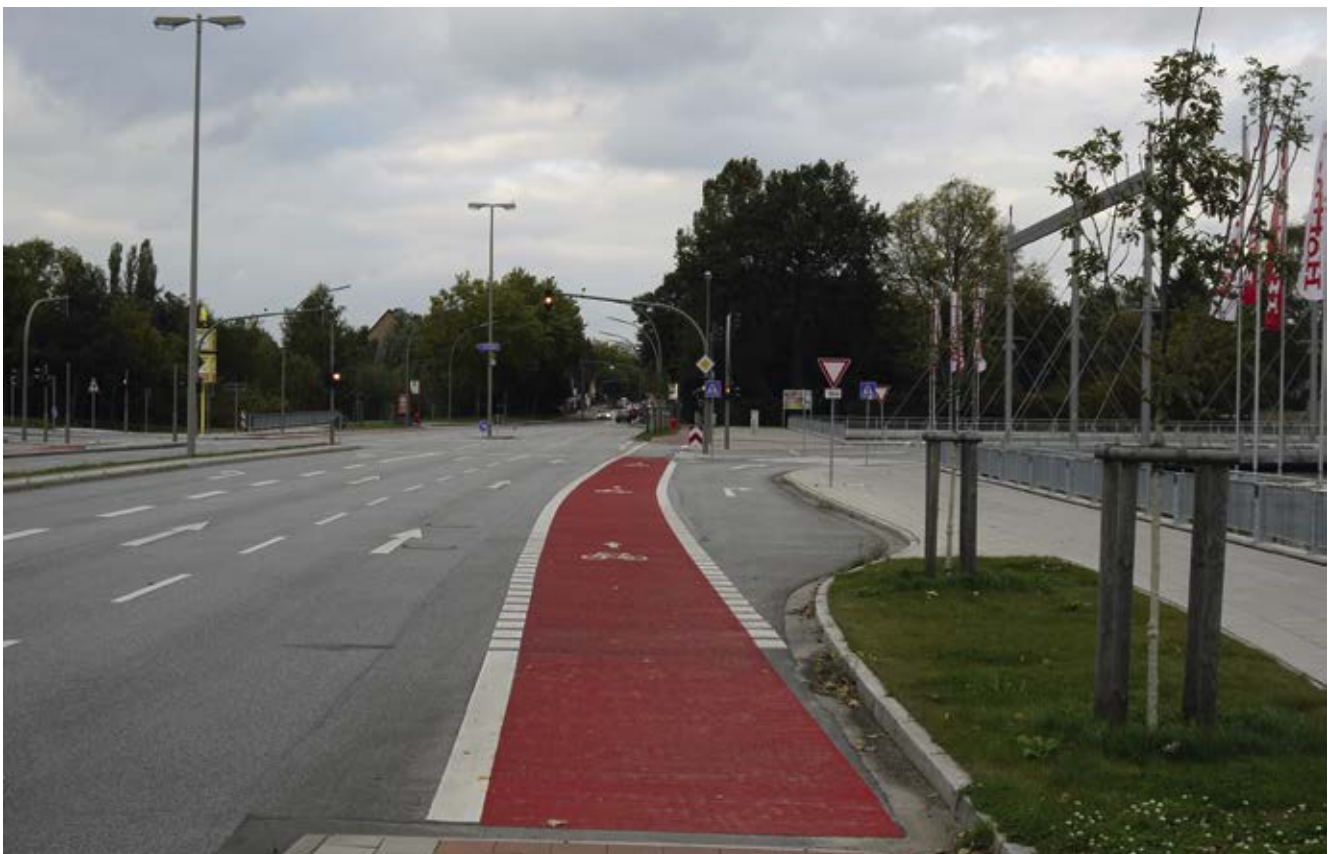
Bild 66: Holsteiner Chaussee / AS HH-Eidelstedt / Zufahrt Möbelmarkt, geradlinige Radverkehrsführung, Radfahrstreifen zwischen Geradeaus- und Rechtsabbiegefahrstreifen
