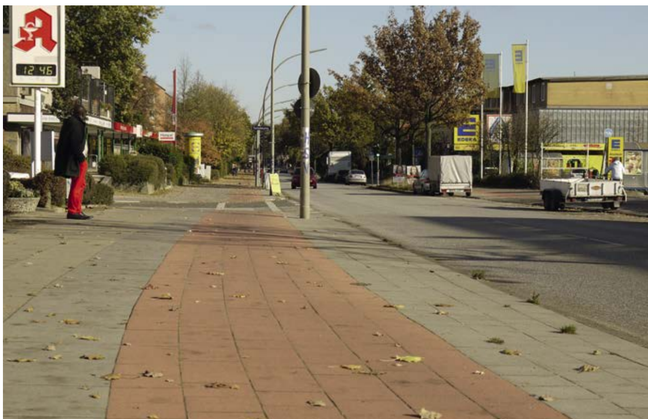
Bild 74: Pezolddamm, Ausbau und Verbreiterung der Radwege
