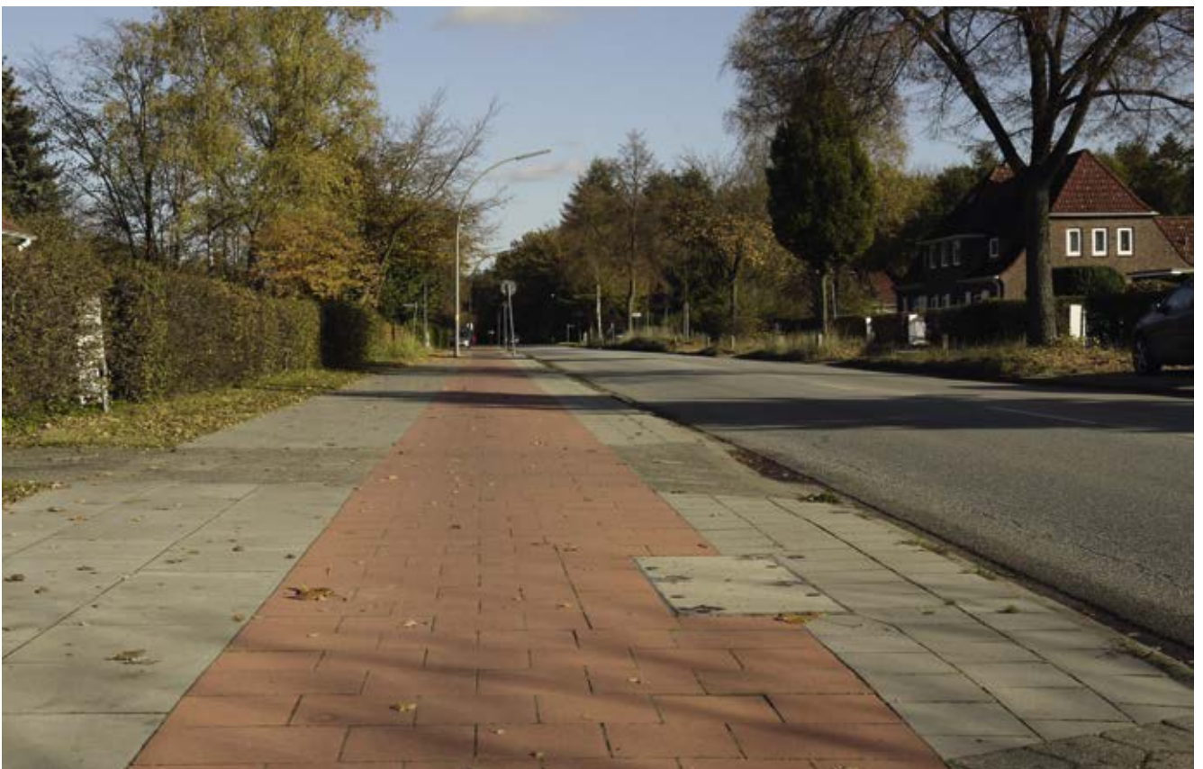
Bild 76: Berner Allee, Ausbau und Verbreiterung der Radwege
