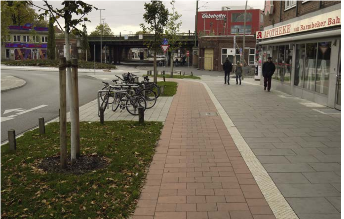
Bild 7: Fuhlsbüttler Straße (Veloroute 5), Ausbau und Verbreiterung des Radweges, Einbau taktiler Leitelemente für Blinde und Sehbehinderte
