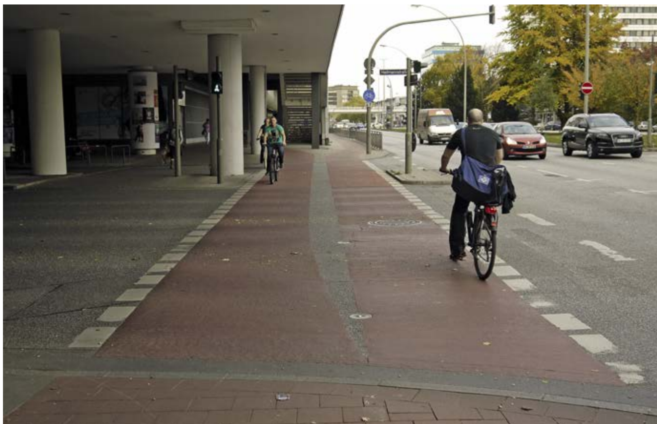
Bild 2: Hamburger Straße (Veloroute 5), Bau eines Zweirichtungsradweges vor dem Einkaufszentrum
