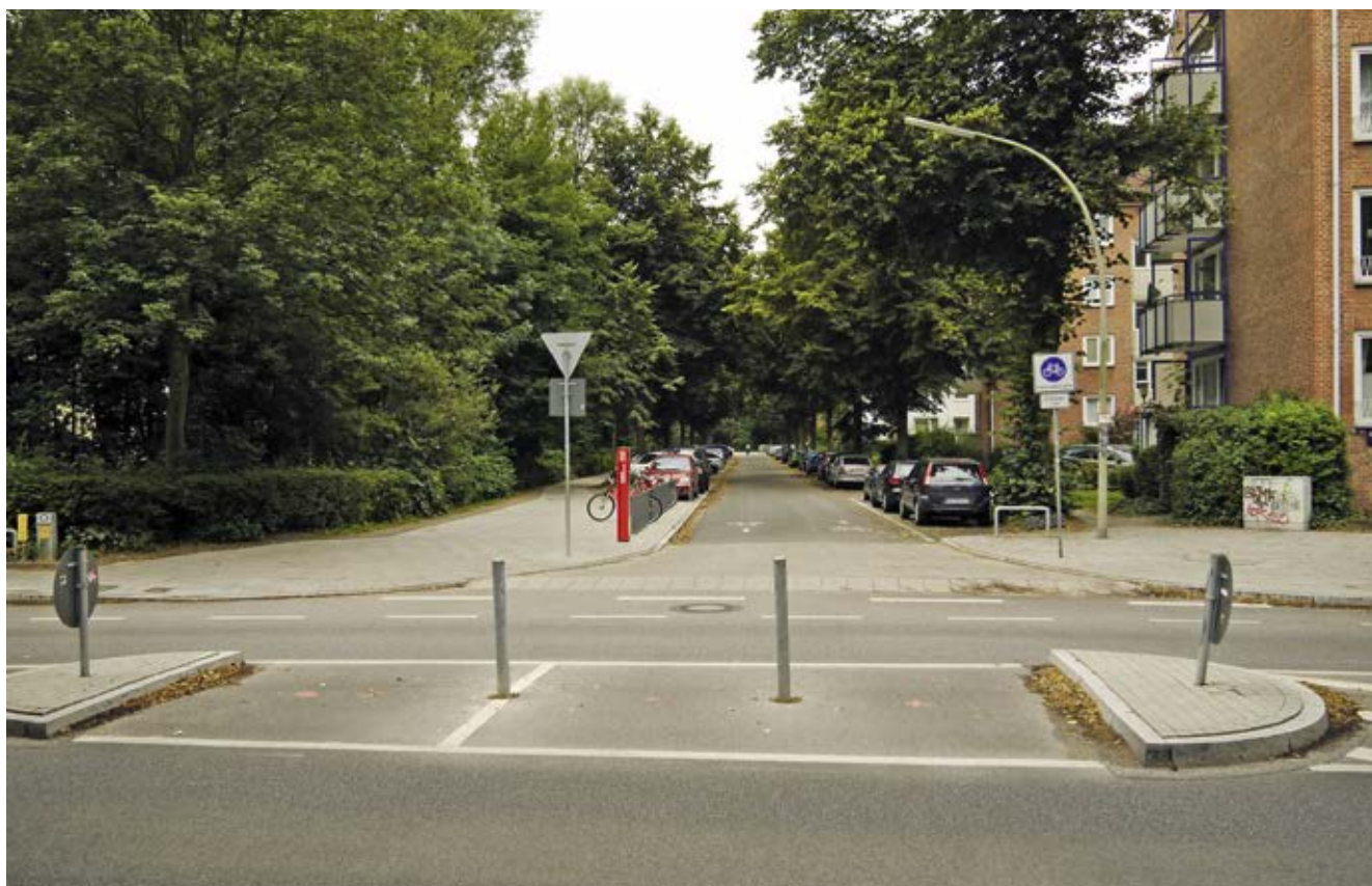
Bild 14: Lortzingstraße (Veloroute 6) / Friedrichsberger Straße, Querungshilfe
