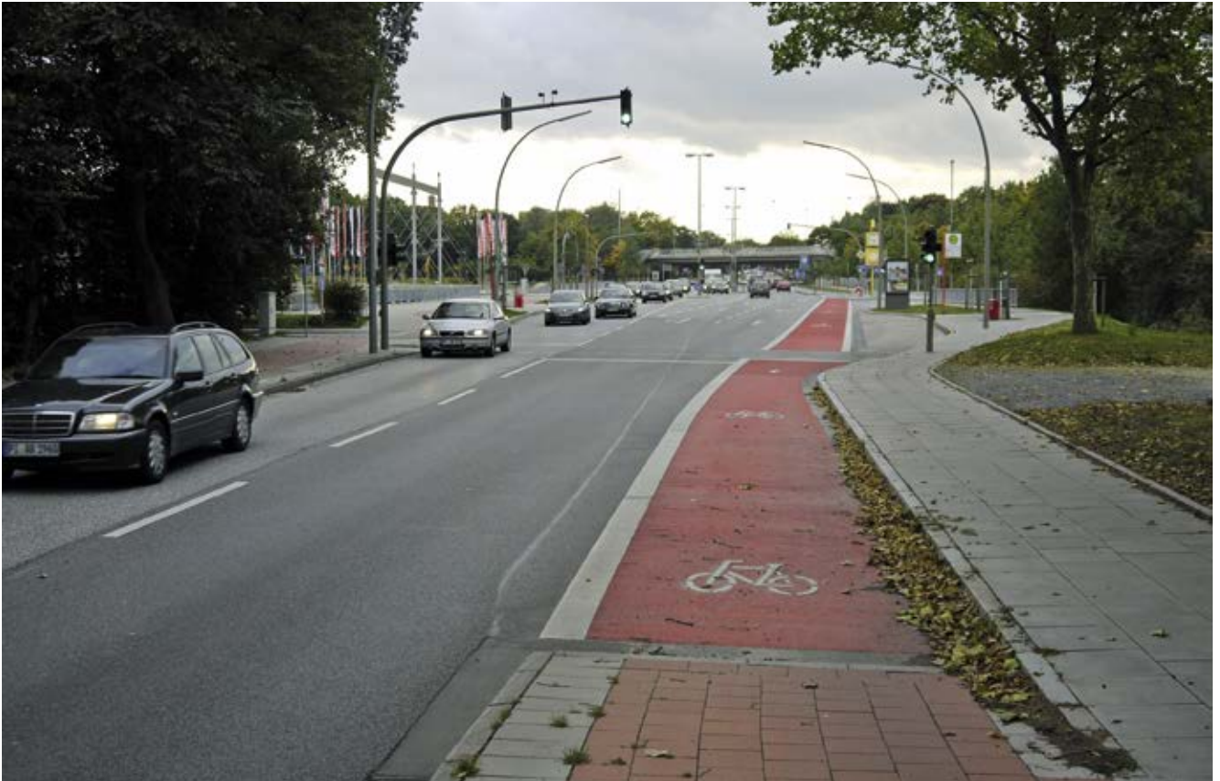
Bild 67: Holsteiner Chaussee / AS HH-Eidelstedt / Zufahrt Möbelmarkt, geradlinige Radverkehrsführung, Führung ohne Konflikte mit Busfahrgästen, Radfahrstreifen zwischen Geradeaus- und Rechtsabbiegefahrstreifen
