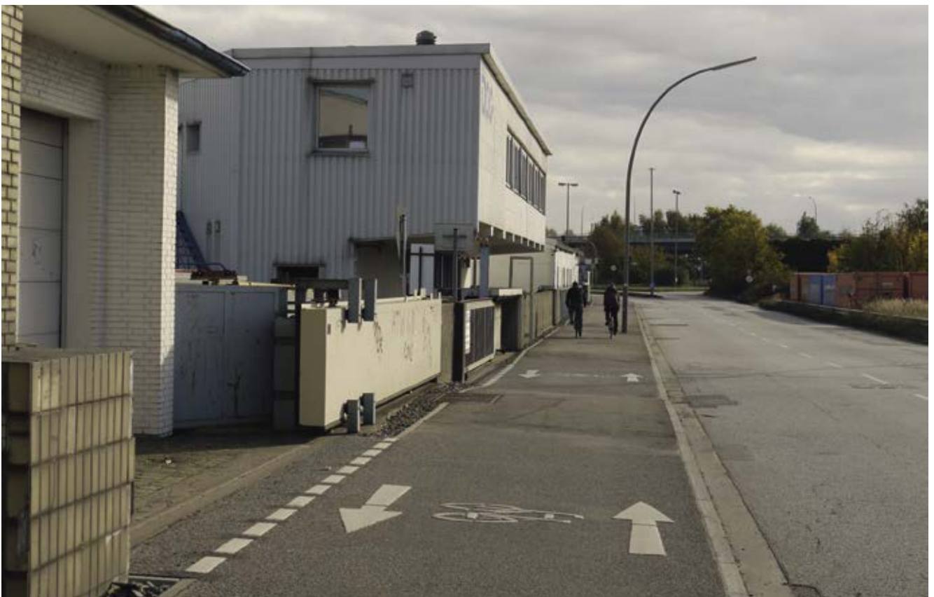
Bild 36: Reiherdamm (Veloroute 11, Freizeitroute 14, Hafenerlebnisroute), Hafengebiet, Bau eines gemeinsamen Geh- und Zweirichtungsradweges, Furtmarkierungen an Gewerbezufahrten zur Erhöhung der Aufmerksamkeit von Kfz- und Radverkehr
