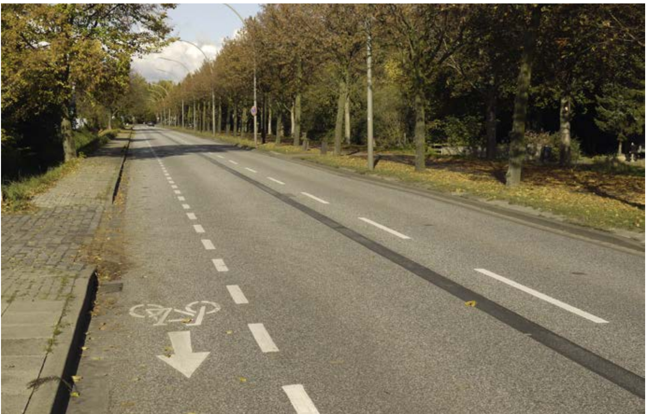
Bild 92: Georg-Wilhelm-Straße (westliche Straßenseite), Schutzstreifen
