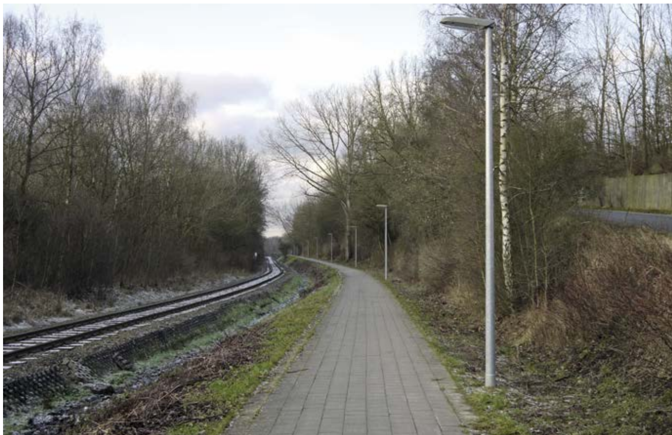
Bild 25: Weg zwischen An der Kreisbahn und Am Langberg (Veloroute 8), Ausstattung mit öffentlicher Beleuchtung
