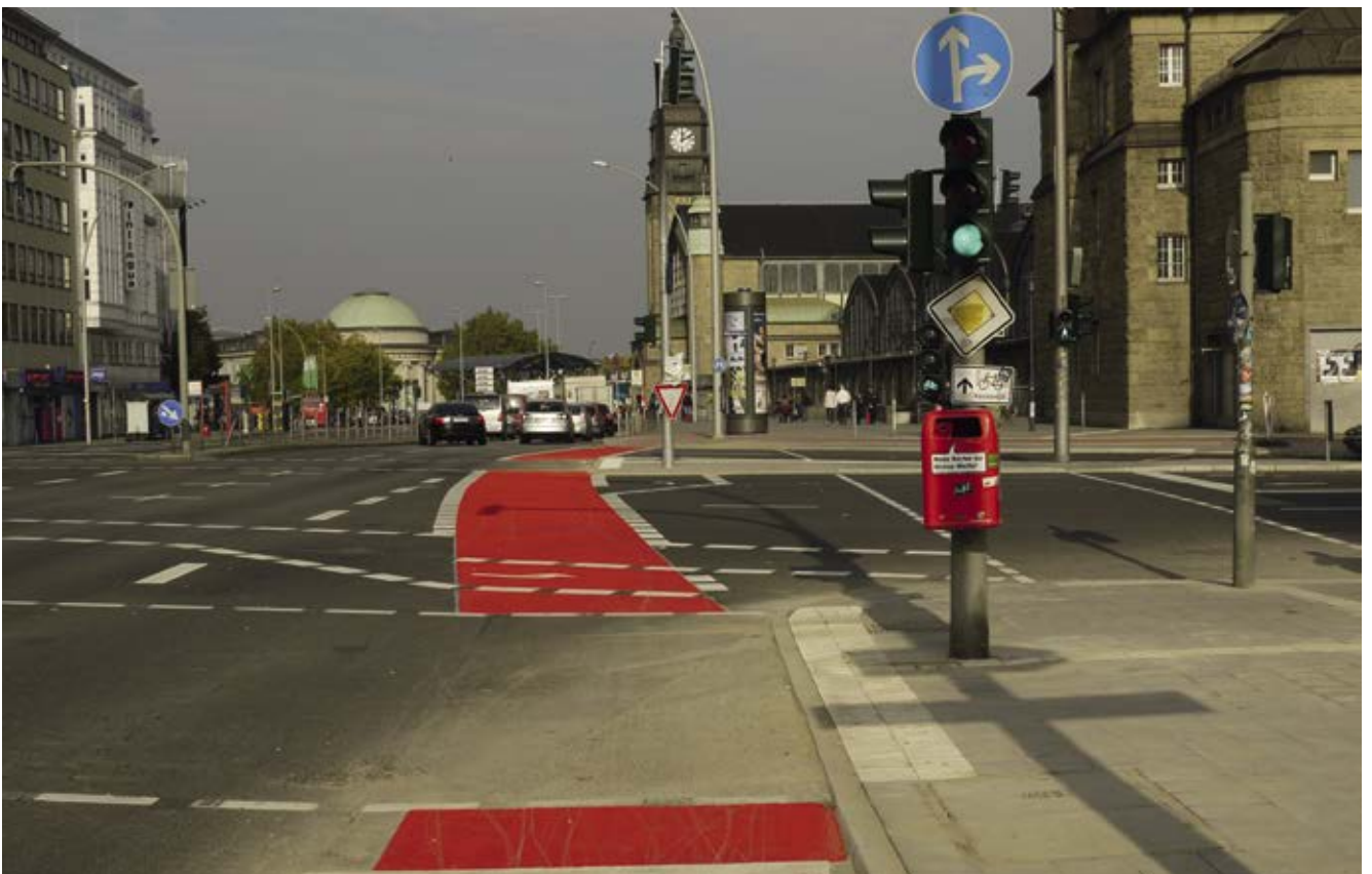
Bild 20: Steintorwall / Steintordamm (Velorouten 7, 8, 9), geradlinige Radverkehrsführung und „Berliner Lösung“ ohne Konflikte mit wartenden Fußgängern
