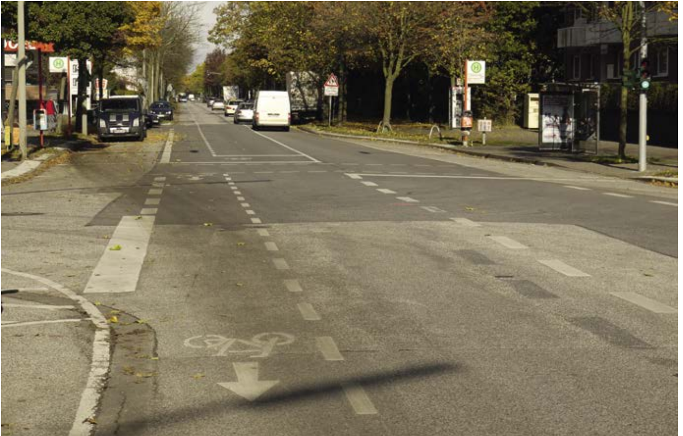
Bild 91: Georg-Wilhelm-Straße (westliche Straßenseite), Schutzstreifen
