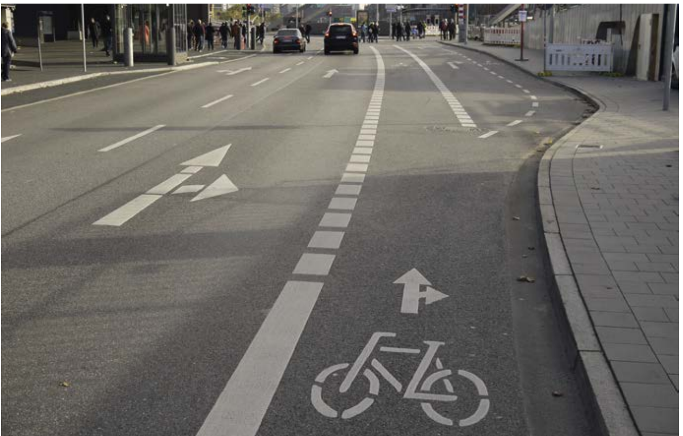
Bild 88: Baumwall (Elberadweg), Radfahrstreifen zwischen Geradeaus- und Rechtsabbiegefahrstreifen, Schutzstreifen im Rechtsabbiegefahrstreifen
