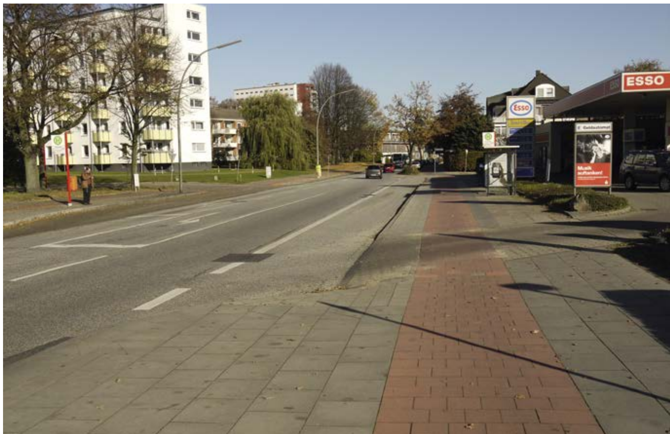
Bild 73: Pezolddamm, Ausbau und Verbreiterung der Radwege
