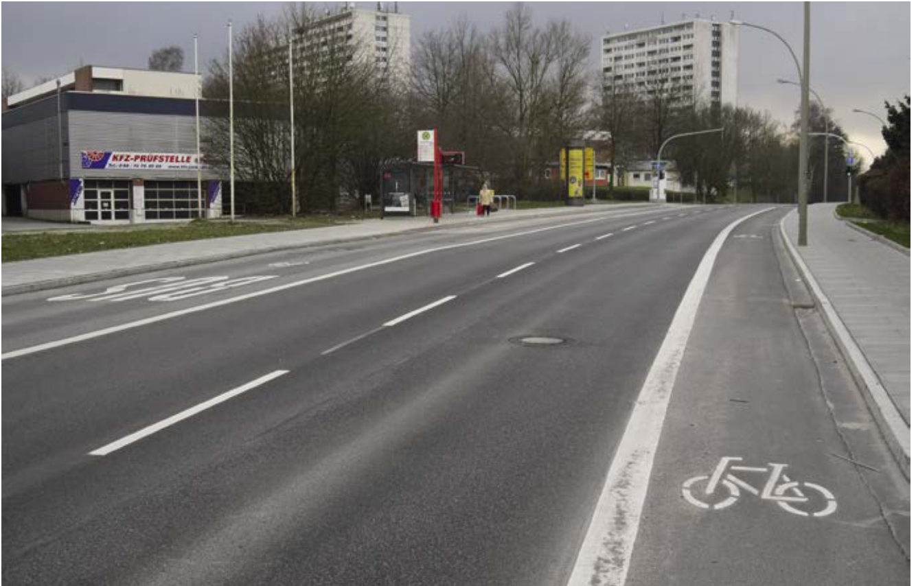
Bild 99: Winsener Straße (westliche Straßenseite), Radfahrstreifen
