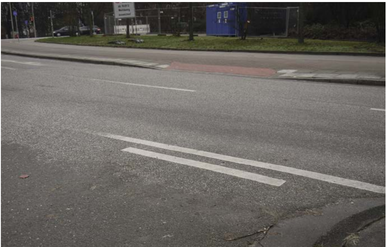
Bild 70: Eilenau / Umlandstraße, Bordkantenabsenkung / Radwegaufleitung für links einbiegenden Radverkehr, ein hilfreiches Detail
