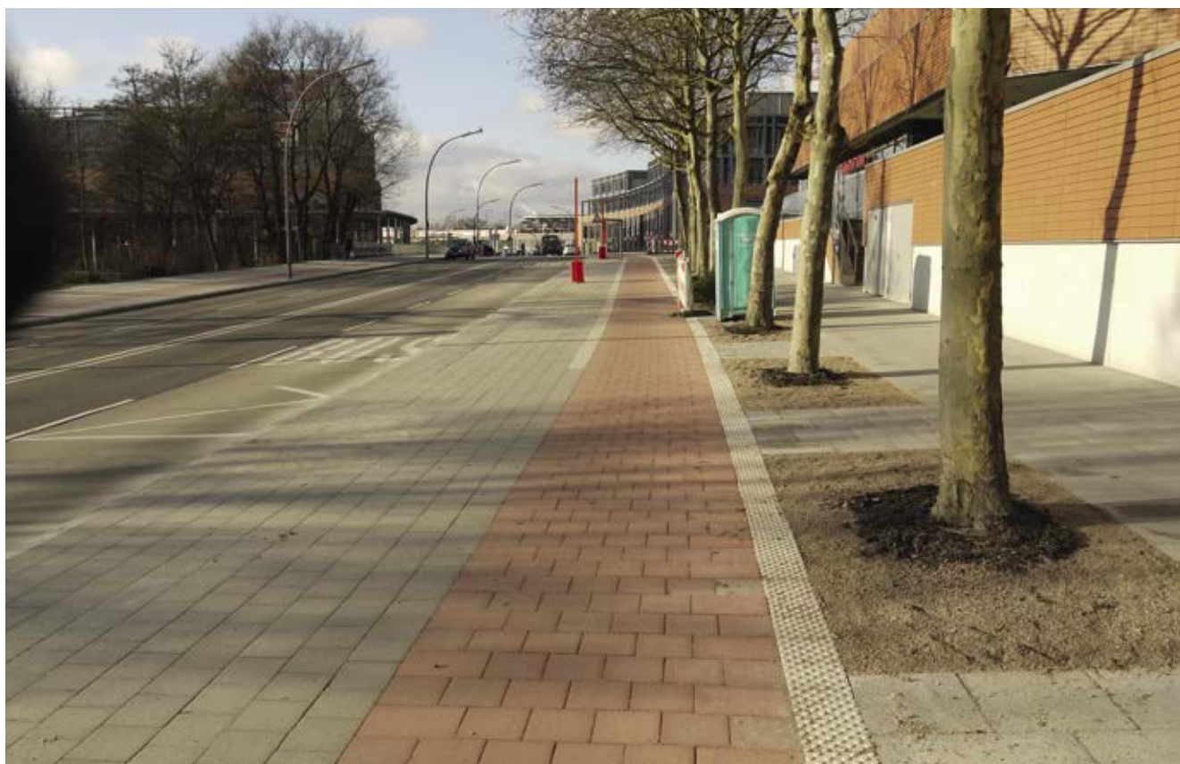
Bild 78: Bergedorfer Straße (nördliche Straßenseite), Ausbau und Verbreiterung des Radweges
