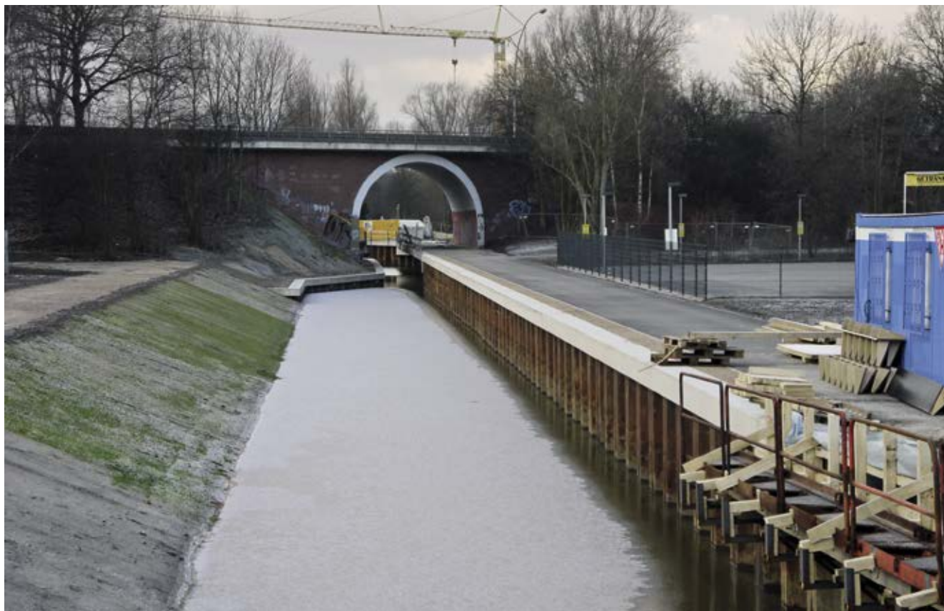
Bild 41: Gert-Schwämme-Weg (Veloroute 11, Freizeitroute 6, Radfernweg Hamburg – Bremen, Freizeitrundkurs Wilhelmsburg) und Kanuanbindung Neue Mitte Wilhelmsburg, Ausbau des gemeinsamen Geh- und Radweges (Bauzustand Januar 2013)
