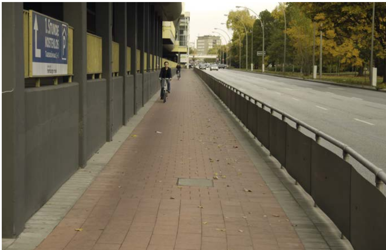
Bild 1: Hamburger Straße (Veloroute 5), Bau eines Zweirichtungsradweges vor dem Einkaufszentrum
