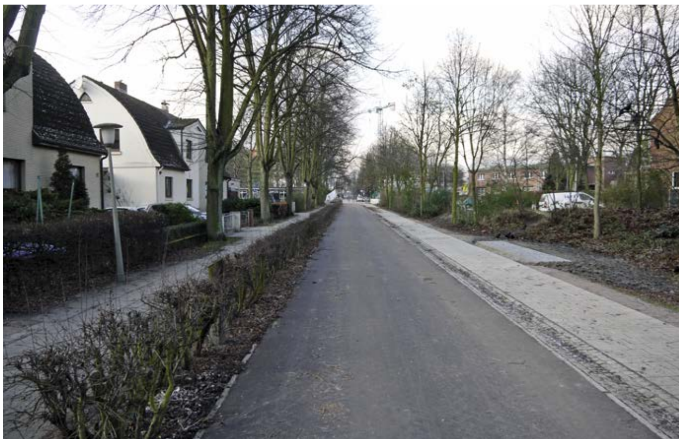
Bild 42: Gert-Schwämme-Weg (Veloroute 11, Freizeitrundkurs Wilhelmsburg), Bau eines getrennten Geh- und Radweges
