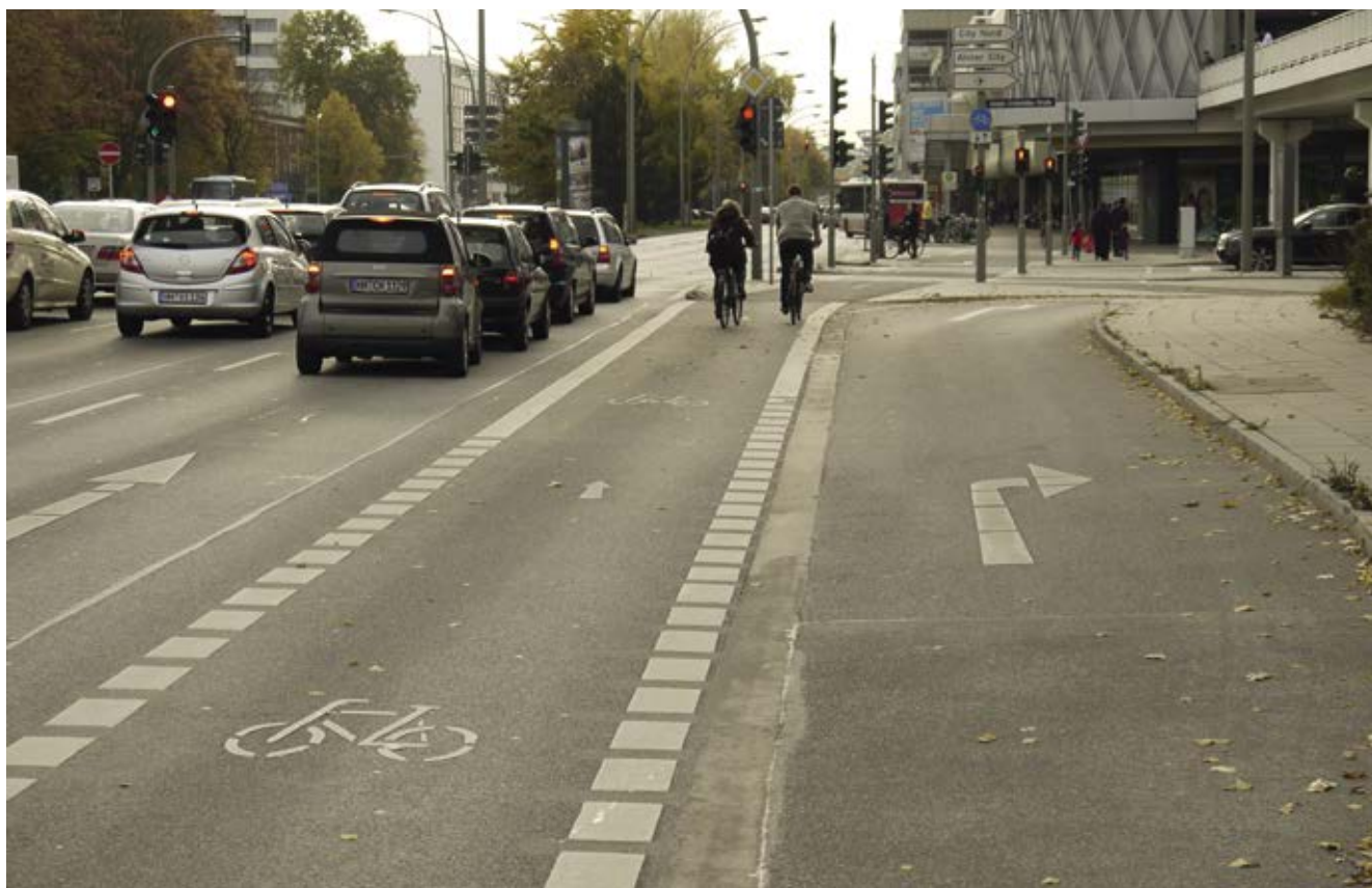
Bild 6: Hamburger Straße (Veloroute 5) / Adolph-Schönfelder-Straße (Veloroute 13), Radfahrstreifen zwischen Geradeaus- und Rechtsabbiegefahrstreifen
