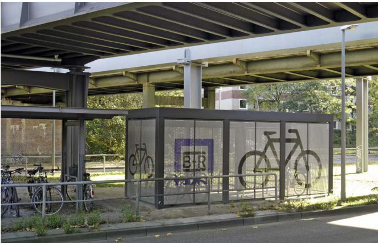
Bild 128: U-Bahnhof Alsterdorf, überdachte Bike+Ride-Anlage
