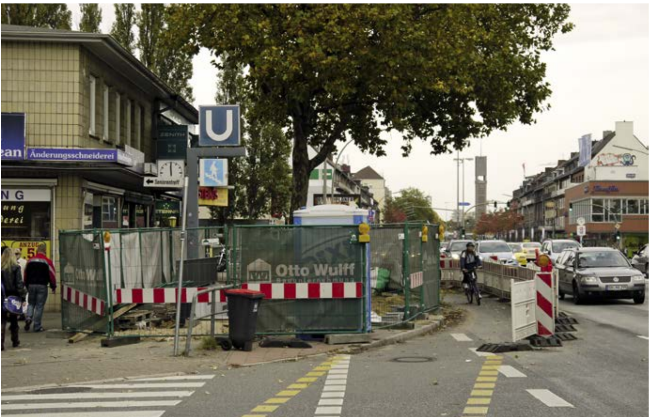
Bild 112: Wandsbeker Chaussee / Börnstraße, bessere Radverkehrsführung an Baustellen
