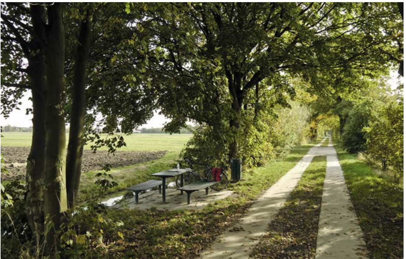
Bild 56: Marschbahndamm südöstlich Beim Avenberg (Freizeitroute 5, Elberadweg, Radfernweg Hamburg – Rügen), Grundinstandsetzung des Spurplattenweges, Ausstattung mit Bänken und Rastplätzen
