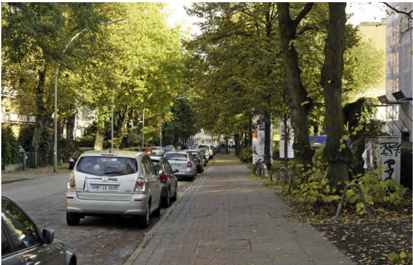
Bild 62: Friedensallee, Ausbau und Verbreiterung der Radwege
