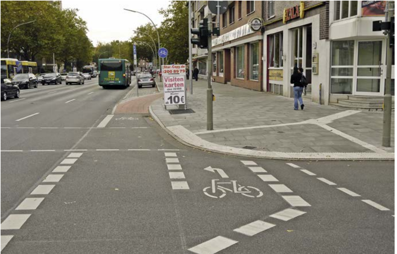
Bild 71: Wandsbeker Chaussee / Hammer Steindamm / Seumestraße, geradlinige Radverkehrsführung und „Berliner Lösung“ ohne Konflikte mit wartenden Fußgängern, Aufstellfläche für indirekt links abbiegenden Radverkehr
