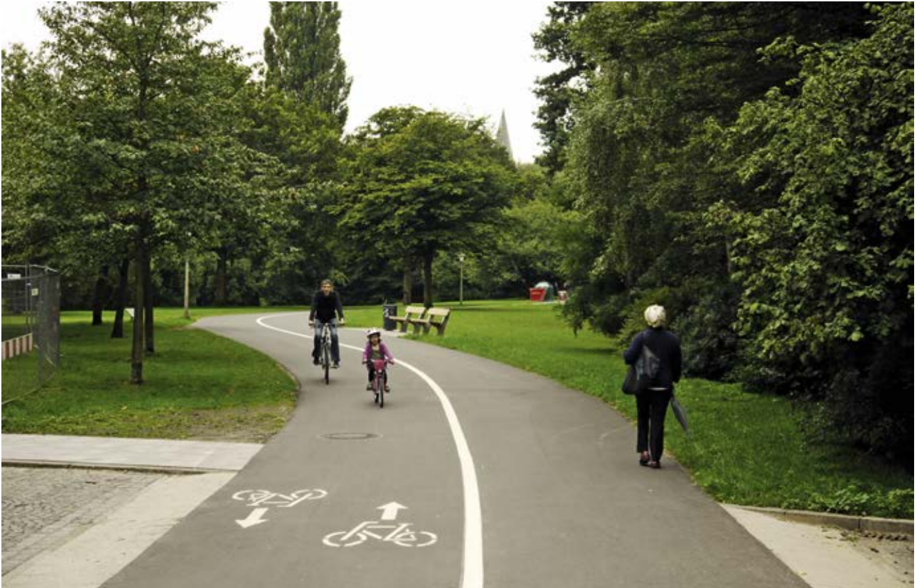
Bild 15: Weg im Eilbek-Grünzug (Veloroute 6), Ausbau und Verbreiterung des getrennten Geh- und Radweges
