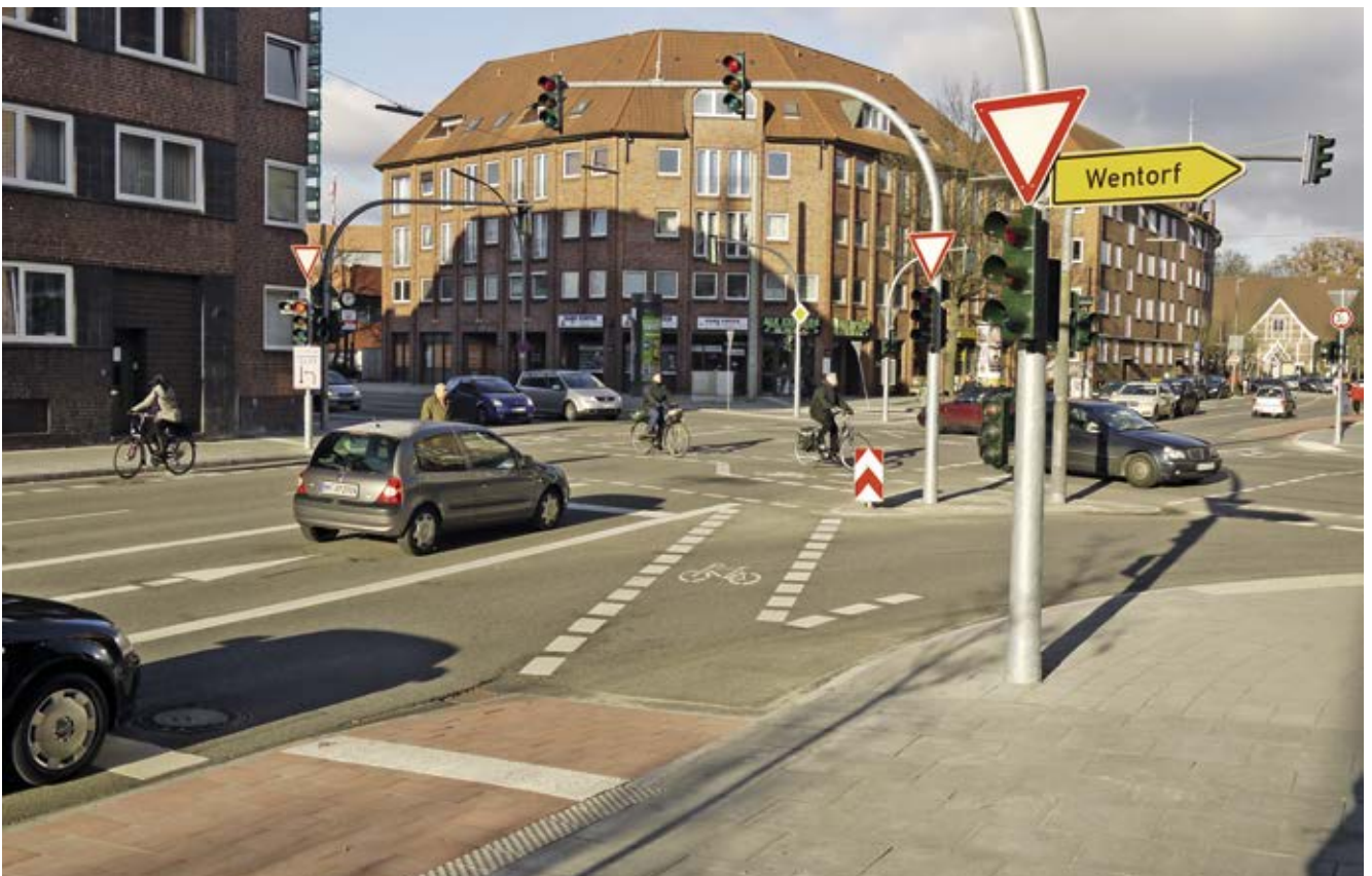
Bild 80: Bergedorfer Straße / Vierlandenstraße, „Berliner Lösung“ ohne Konflikte mit wartenden Fußgängern; Fahrradschleuse für geradeausfahrenden Radverkehr
