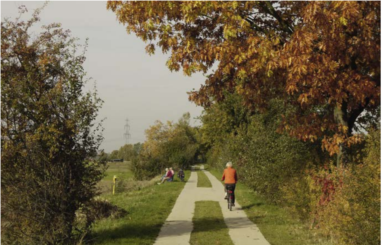
Bild 55: Marschbahndamm südöstlich Beim Avenberg (Freizeitroute 5, Elberadweg, Radfernweg Hamburg – Rügen), Grundinstandsetzung des Spurplattenweges, Ausstattung mit Bänken und Rastplätzen
