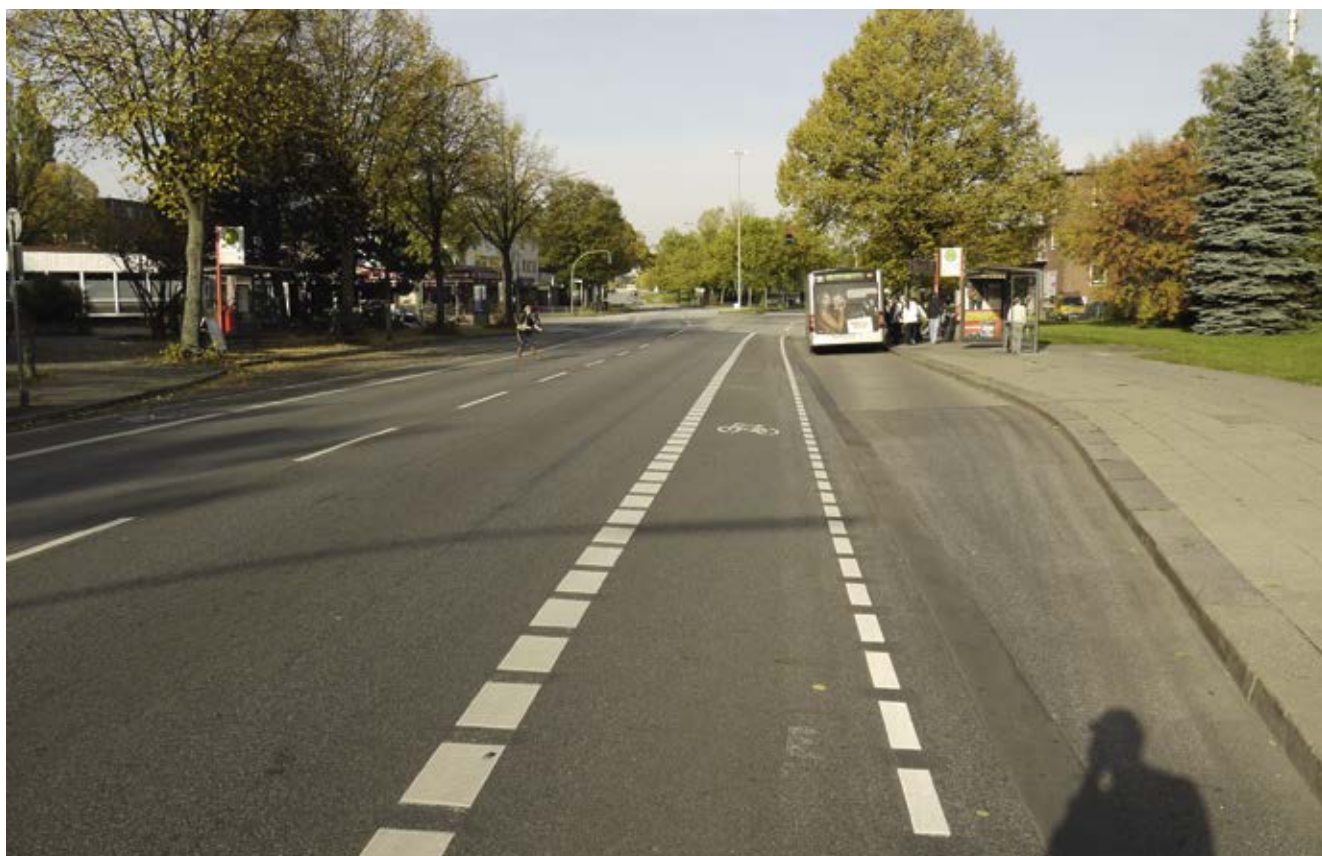
Bild 30: Billhorner Röhrendamm östlich Billhorner Mühlenweg (Veloroute 9), Radfahrstreifen, Führung ohne Konflikte mit Busfahrgästen
