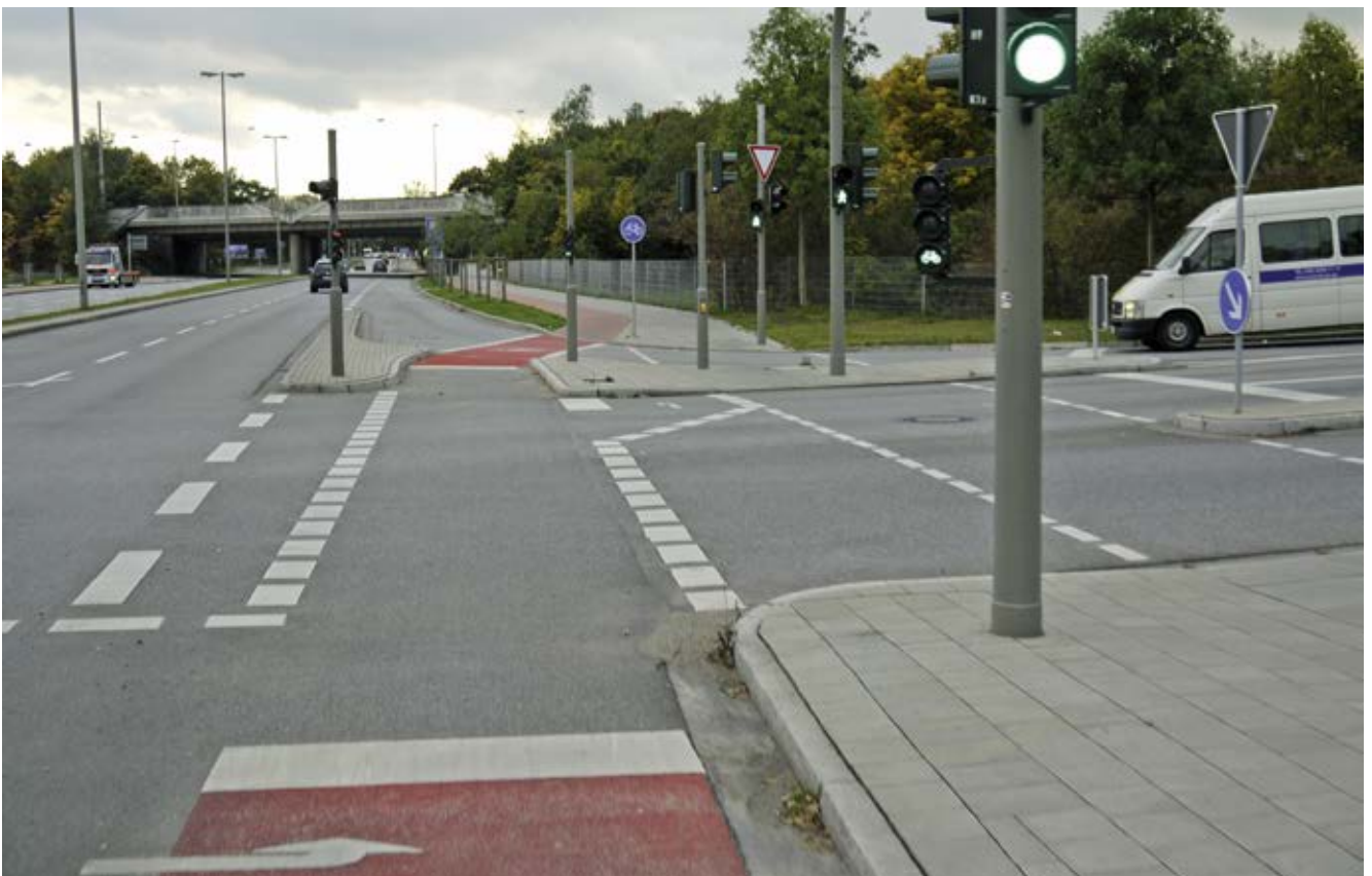
Bild 68: Holsteiner Chaussee / AS HH-Eidelstedt / Zufahrt Möbelmarkt, geradlinige Radverkehrsführung, Aufstellfläche für indirekt linksabbiegenden Radverkehr
