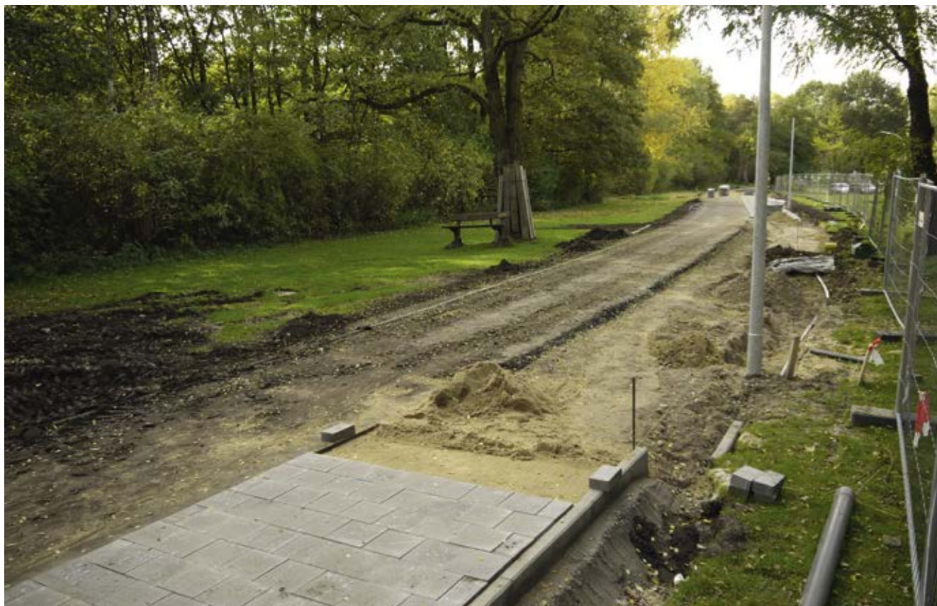
Bild 21: Thörls Park (Veloroute 8), Ausbau und Verbreiterung des getrennten Geh- und Radweges, Erneuerung der öffentlichen Beleuchtung (Bauzustand Oktober 2012)
