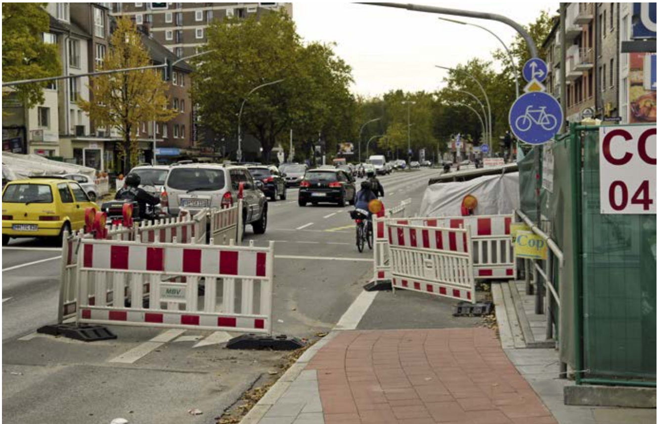
Bild 113: Wandsbeker Chaussee / Seumestraße, bessere Radverkehrsführung an Baustellen
