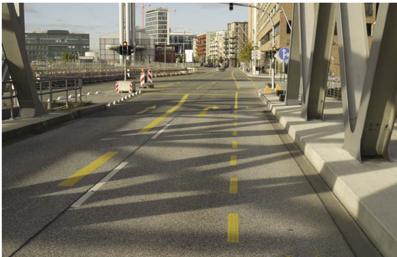
Bild 34: Überseeallee (Veloroute 10), provisorischer Schutzstreifen
