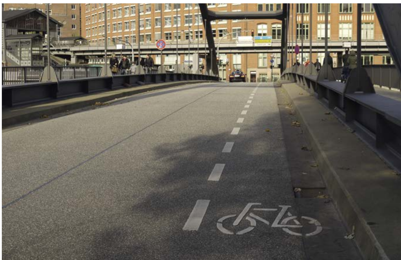
Bild 90: Östliche Niederbaumbrücke, Schutzstreifen
