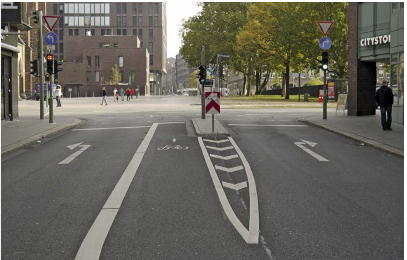
Bild 32: Rathausstraße / Speersort / Bergstraße (Veloroute 10), Radfahrstreifen zwischen Links- und Rechtsabbiegefahrstreifen
