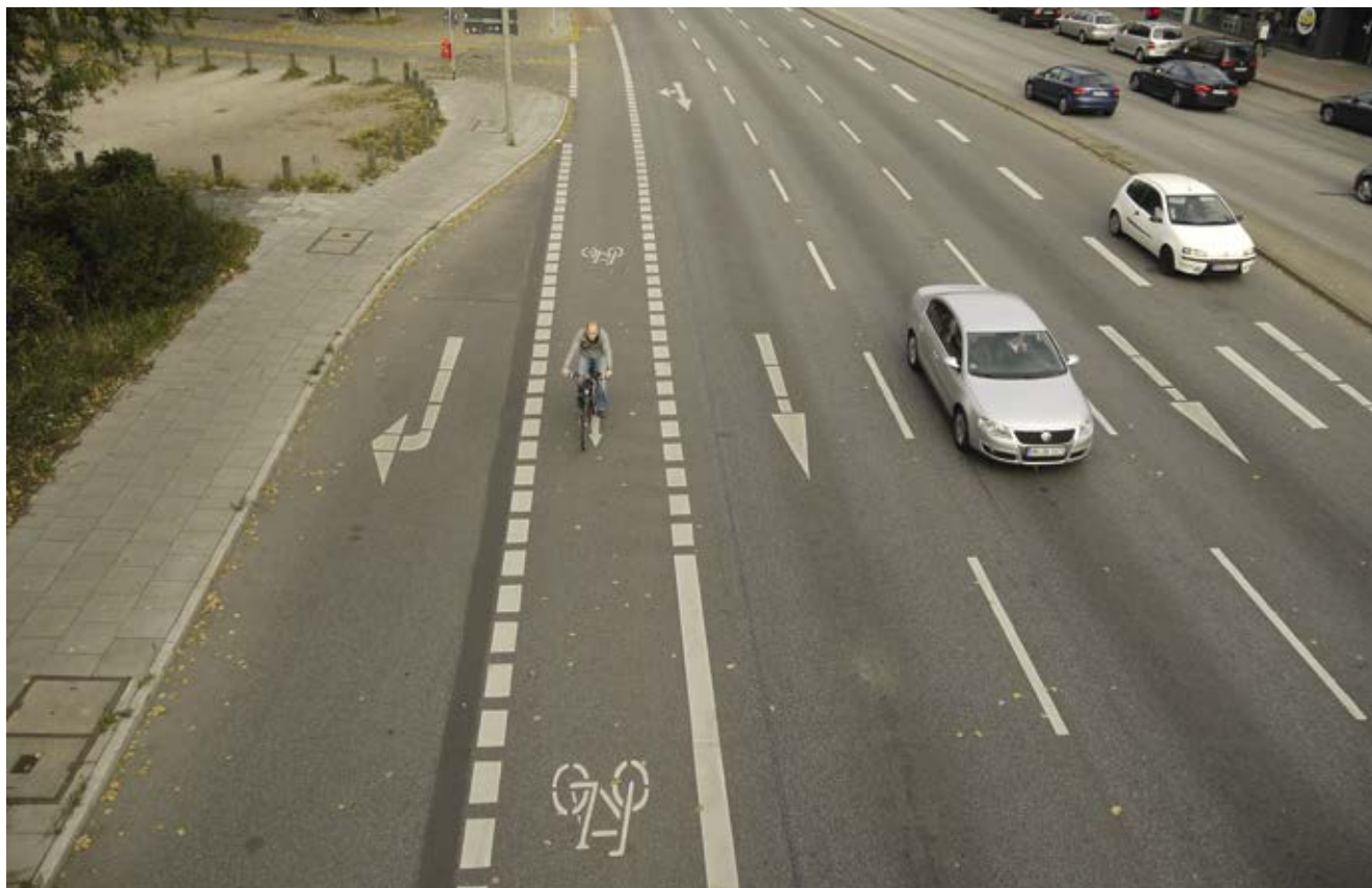
Bild 5: Hamburger Straße (Veloroute 5) / Adolph-Schönfelder-Straße (Veloroute 13), Radfahrstreifen zwischen Geradeaus- und Rechtsabbiegefahrstreifen
