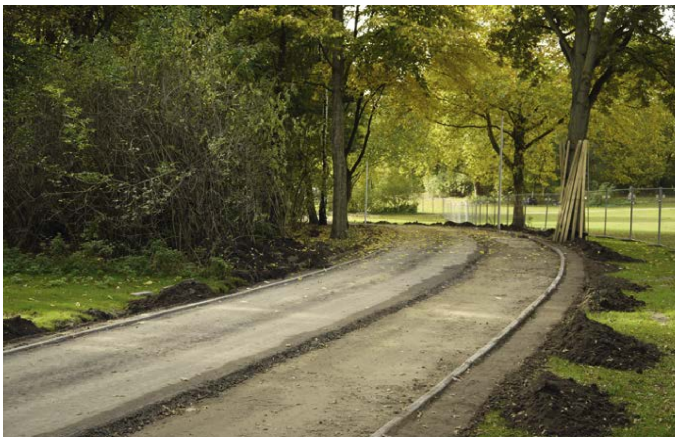
Bild 22: Thörls Park (Veloroute 8), Ausbau und Verbreiterung des getrennten Geh- und Radweges, Erneuerung der öffentlichen Beleuchtung (Bauzustand Oktober 2012)
