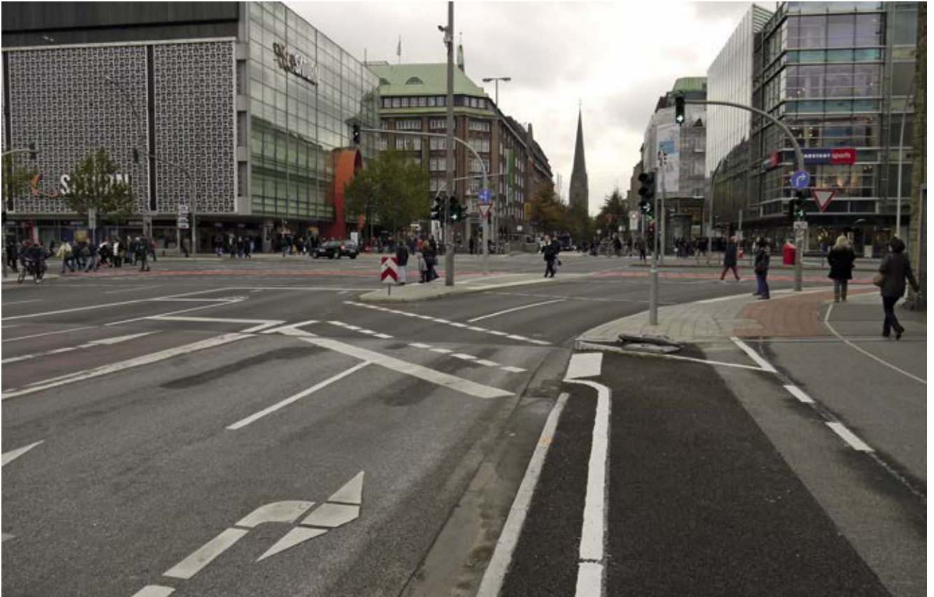
Bild 19: Steintorwall / Steintordamm (Velorouten 7, 8, 9), Fahrradschleuse für geradeausfahrenden Radverkehr nach Kopenhagener Vorbild
