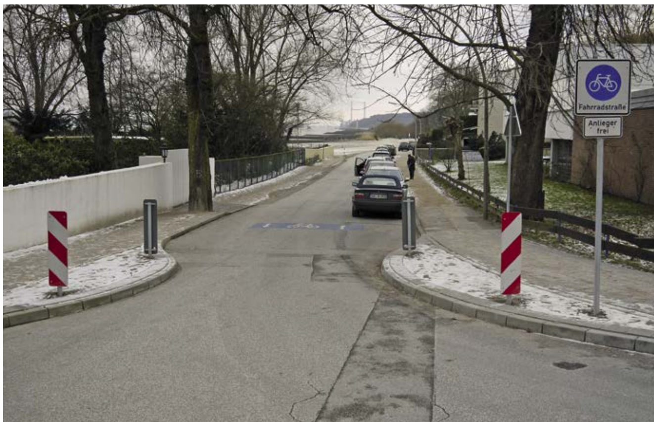
Bild 58: Falkensteiner Ufer (Freizeitroute 8, Elberadweg, Nordseeküstenradweg), Einrichtung einer Fahrradstraße
