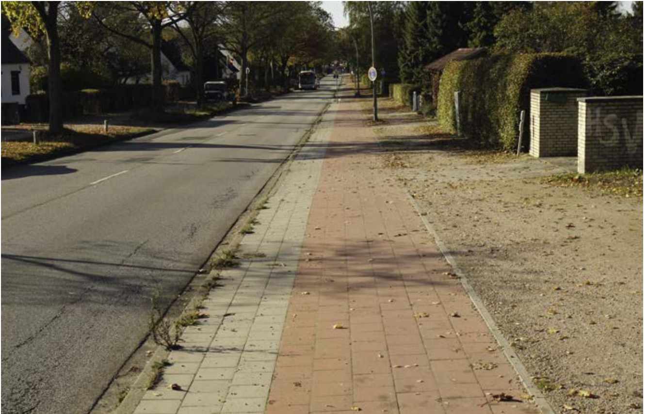
Bild 75: Berner Allee, Ausbau und Verbreiterung der Radwege
