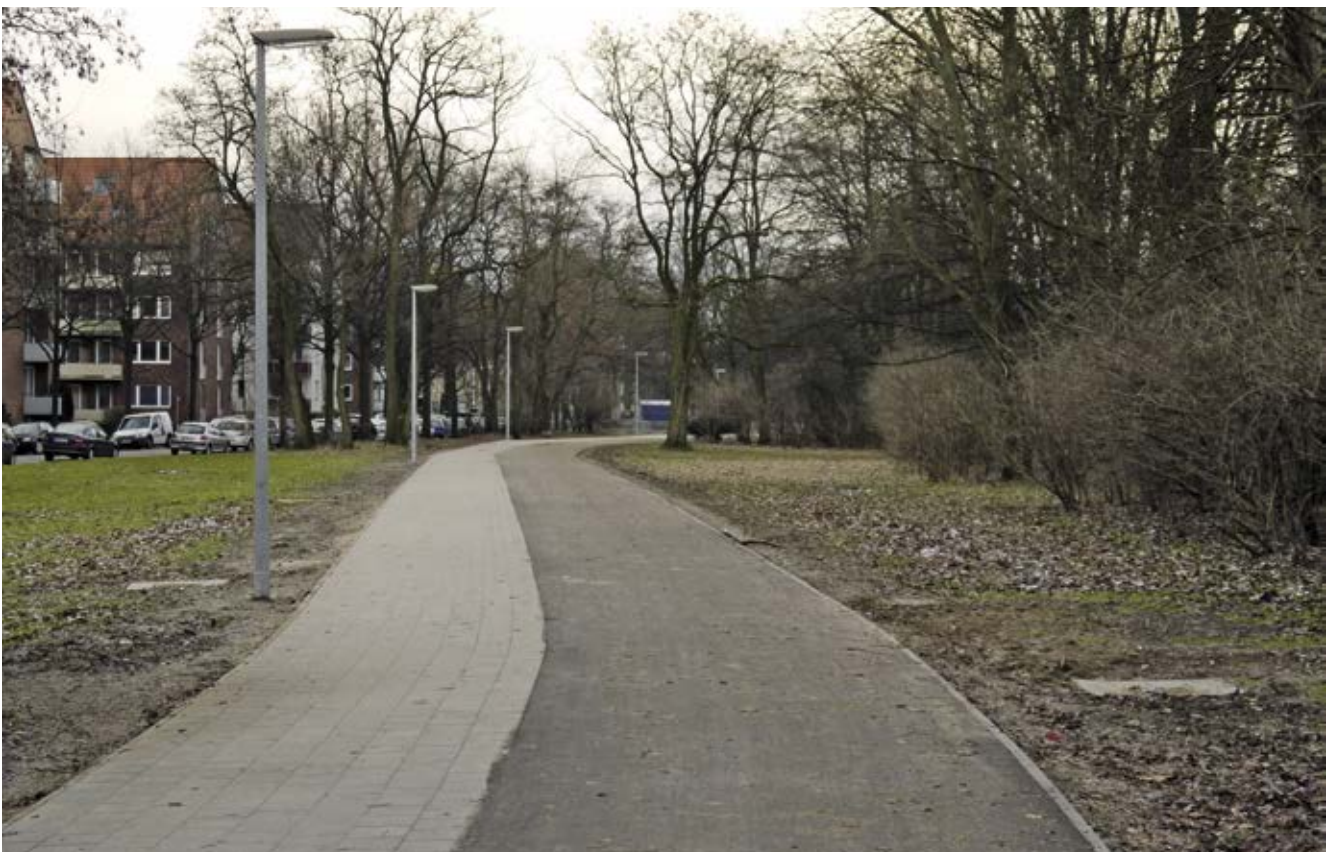
Bild 24: Thörls Park (Veloroute 8), Ausbau und Verbreiterung des getrennten Geh- und Radweges, Erneuerung der öffentlichen Beleuchtung (Zustand Januar 2013)
