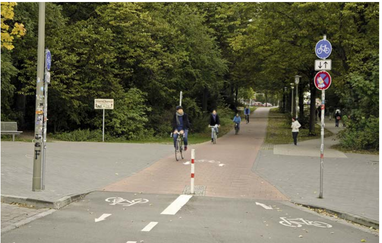
Bild 60: Sternschanze (Freizeitroute 9), Ausbau und Verbreiterung des getrennten Geh- und Radweges
