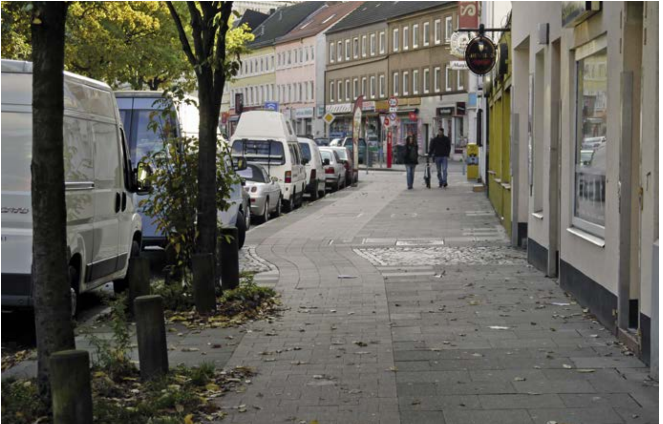
Bild 63: Bahrenfelder Straße, Ausbau und Verbreiterung der Radwege
