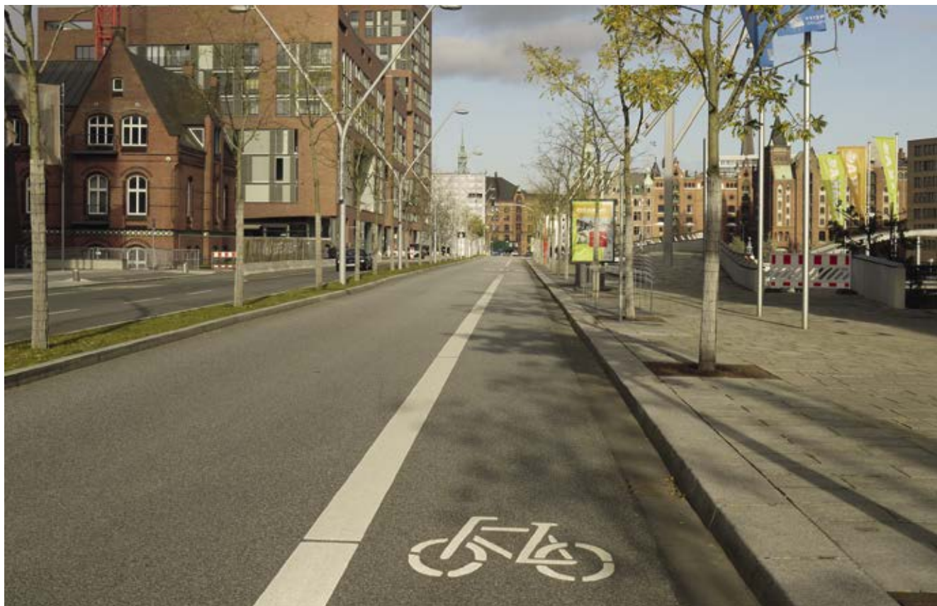
Bild 33: Osakaallee (Veloroute 10), Radfahrstreifen
