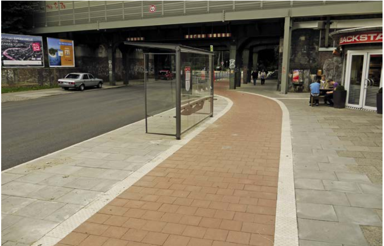
Bild 17: Eilbektal (Veloroute 6), Ausbau und Verbreiterung des Zweirichtungsrادweges am S-Bahnhof Friedrichsberg, Einbau taktiler Leitelemente für Blinde und Sehbehinderte
