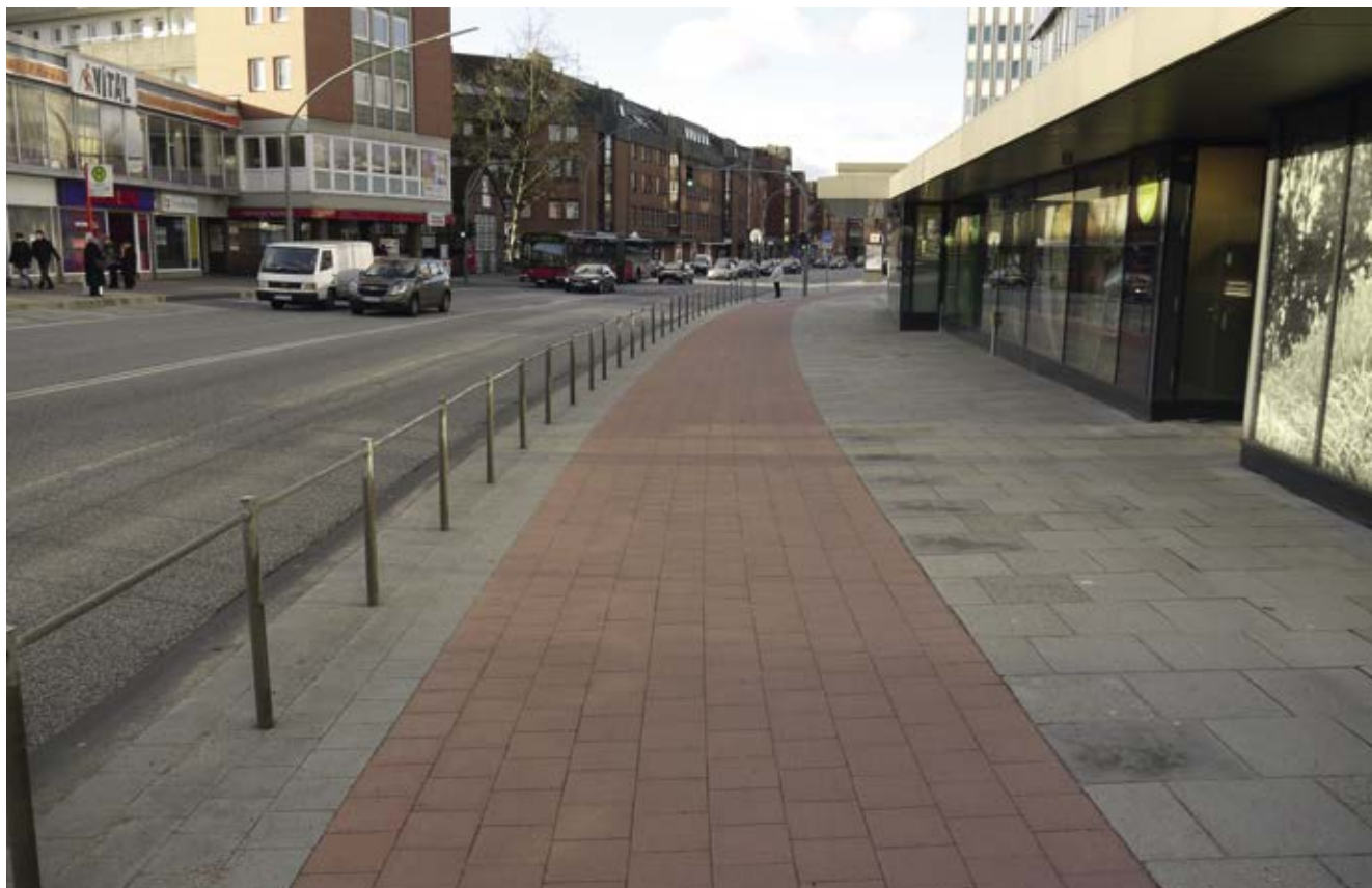
Bild 77: Bergedorfer Straße (nördliche Straßenseite), Ausbau und Verbreiterung des Radweges
