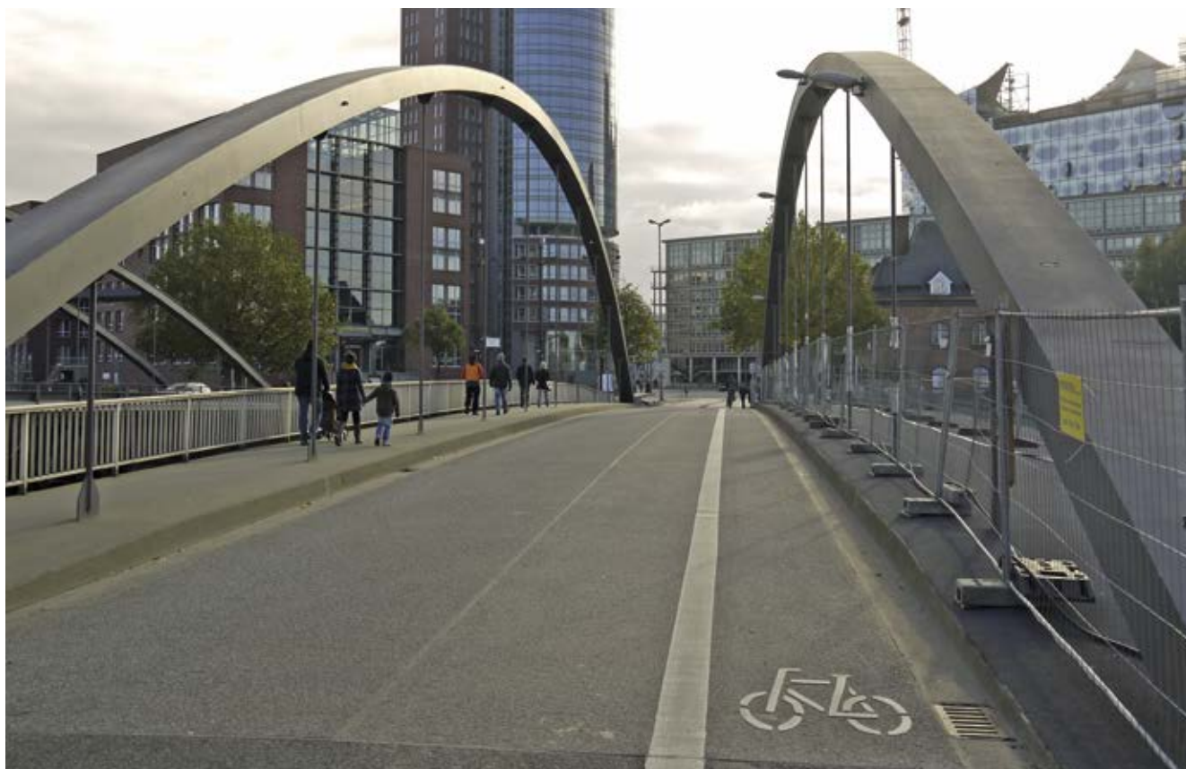
Bild 89: Westliche Niederbaumbrücke, Radfahrstreifen
