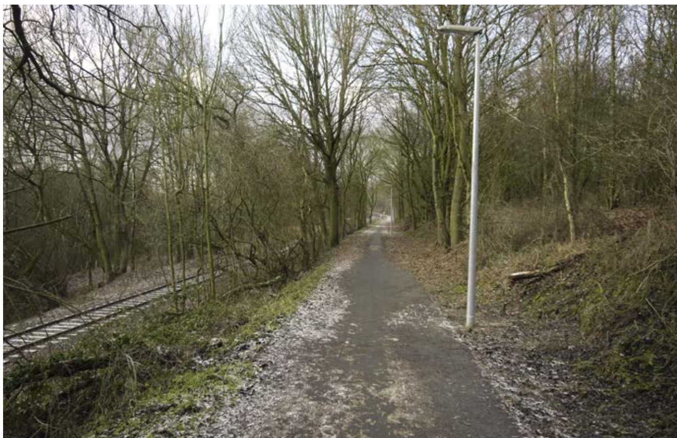
Bild 26: Weg zwischen An der Kreisbahn und Am Langberg (Veloroute 8), Ausbau des gemeinsamen Geh- und Radweges, Ausstattung mit öffentlicher Beleuchtung
