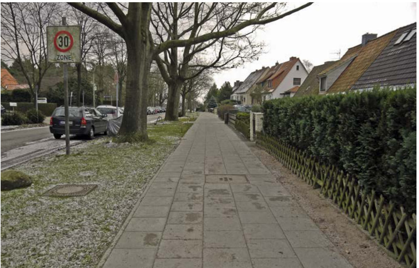
Bild 84: Hainholzweg, Rückbau der Radwege in Tempo-30-Zone, Verbreiterung der Gehwege
