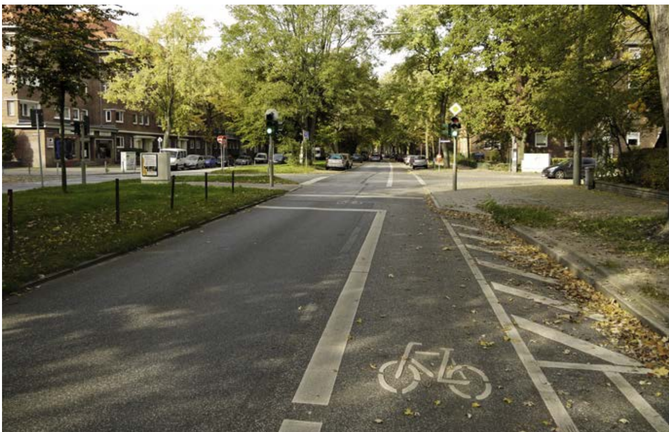
Bild 94: Washingtonallee, Radfahrstreifen, aufgeweiteter Radaufstellstreifen (ARAS) am Knoten
