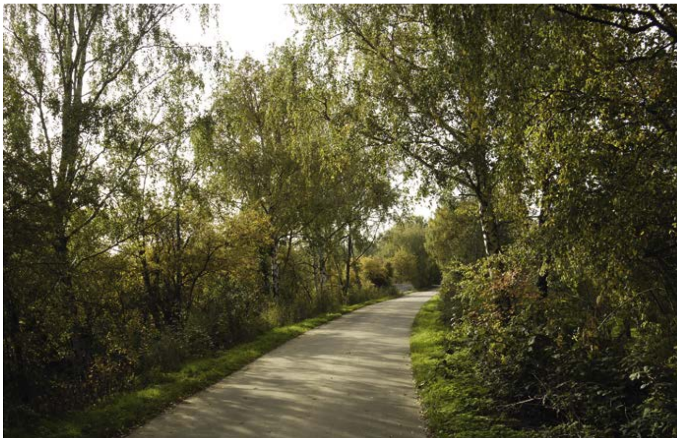
Bild 53: Marschbahndamm nordwestlich Ochsenwerder Kirchendeich (Freizeitroute 5, Elberadweg, Radfernweg Hamburg – Rügen), Ausbau, Verbreiterung und Asphaltierung des Weges, Ausstattung mit Bänken und Rastplätzen
