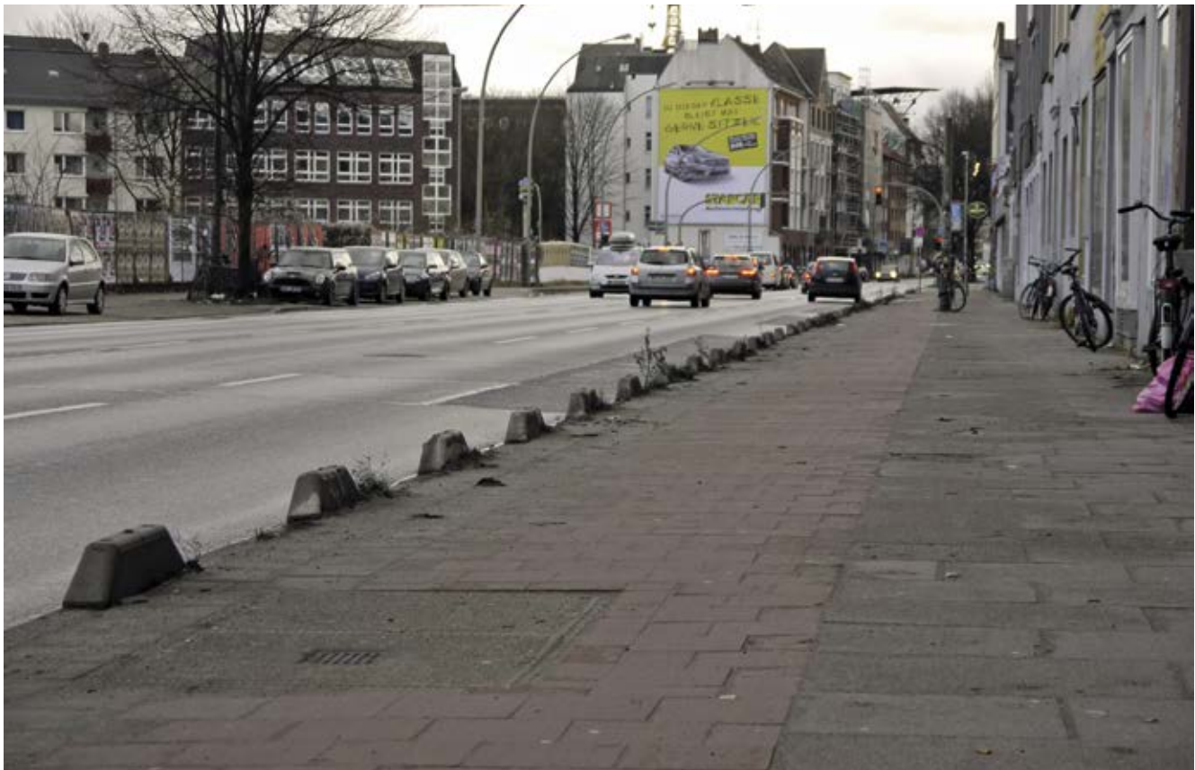
Bild 61: Stresemannstraße, Ausbau und Verbreiterung der Radwege, Einbau von „Frankfurter Hüten“ gegen widerrechtliches Parken
