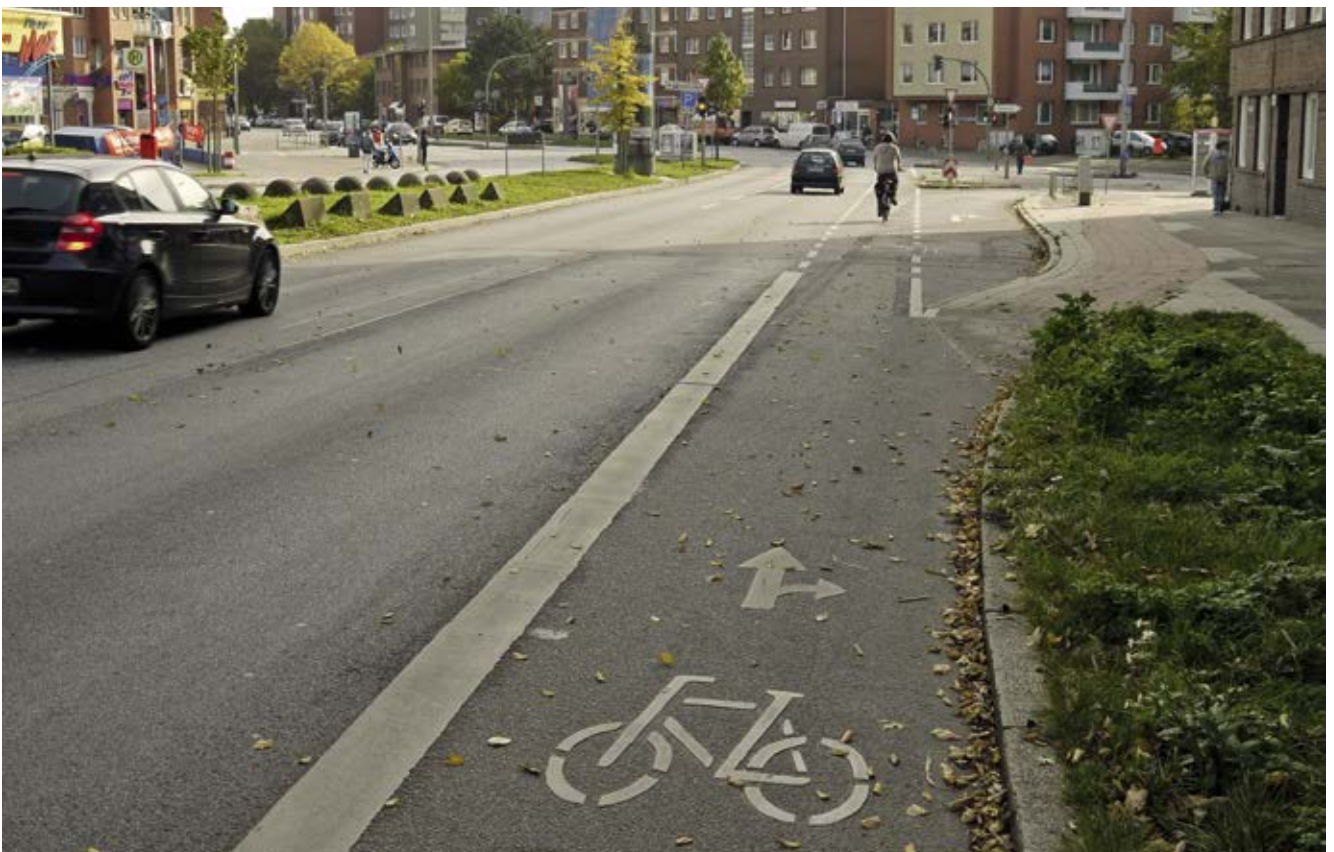
Bild 96: Washingtonallee / Billstedter Hauptstraße, geradlinige Radverkehrsführung, Radfahrstreifen zwischen Geradeaus- und Rechtsabbiegefahrstreifen
