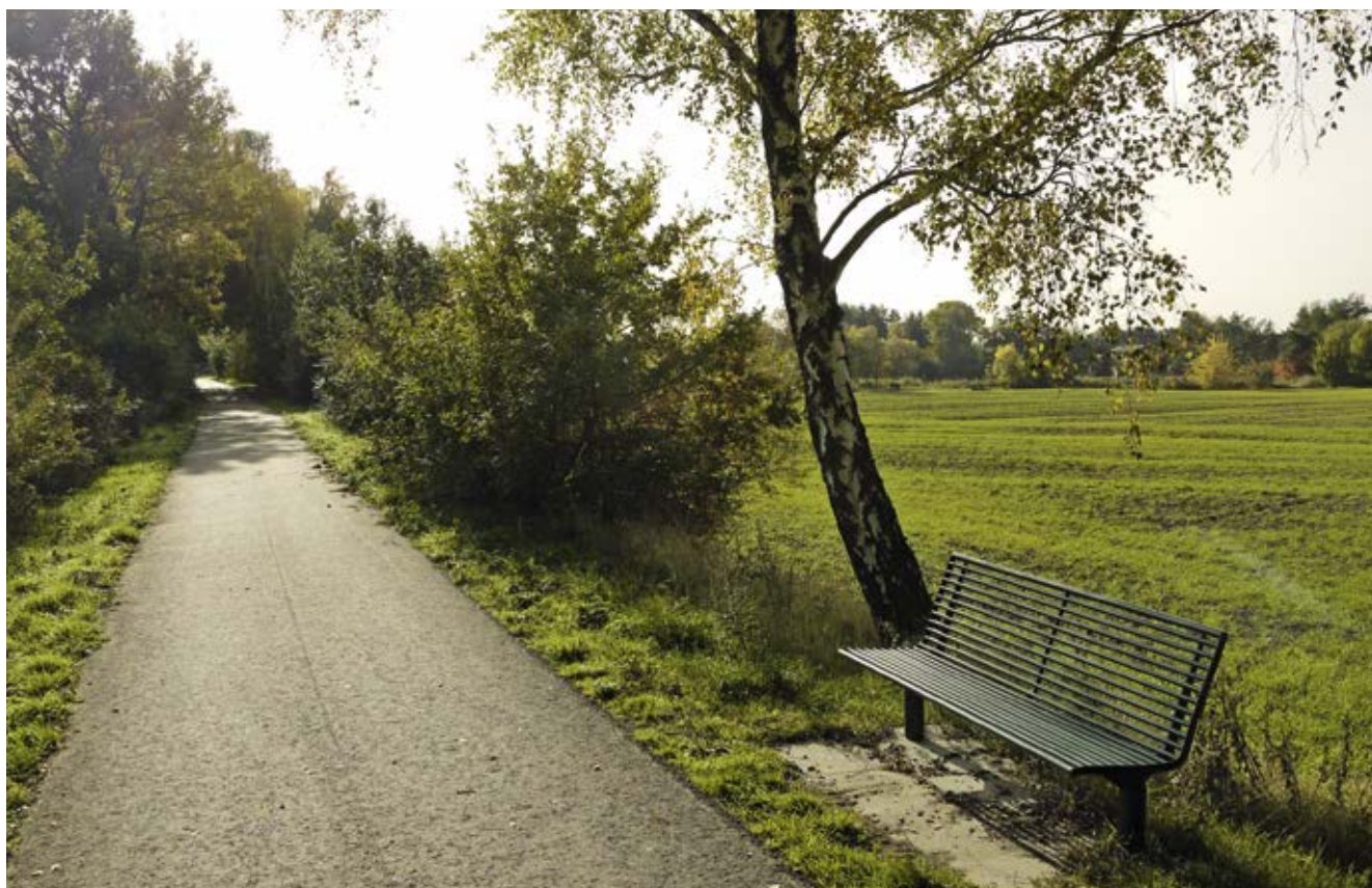
Bild 54: Marschbahndamm nordwestlich Ochsenwerder Kirchendeich (Freizeitroute 5, Elberadweg, Radfernweg Hamburg – Rügen), Ausbau, Verbreiterung und Asphaltierung des Weges, Ausstattung mit Bänken und Rastplätzen
