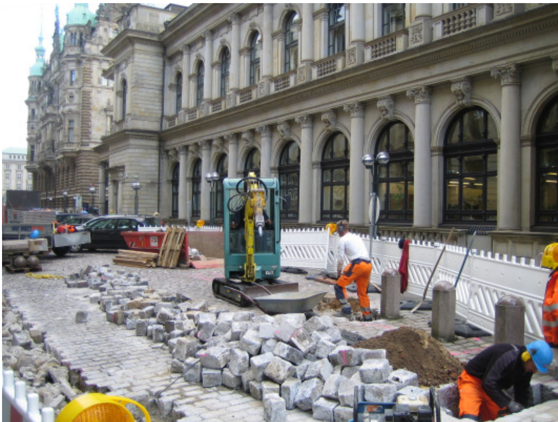
Bild 48: Alter Wall, Bau der StadtRAD-Station am Rathaus
