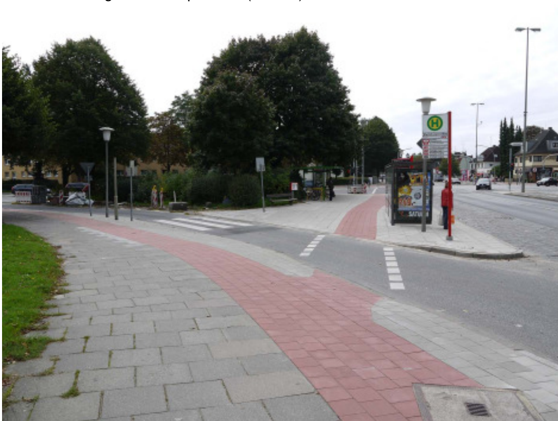
Bild 11: Bramfelder Chaussee / Steilshooper Allee, Begradigung der Radverkehrsführung an Knotenpunkten (ehemalige Radwegfurt ist am dunklen Asphalt erkennbar)
