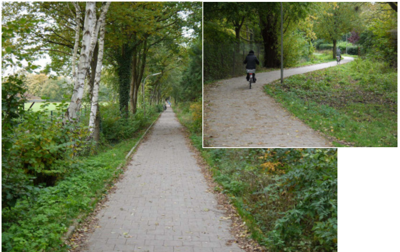
Bild 24: Neubau eines selbstständig geführten Geh- und Radweges entlang des
