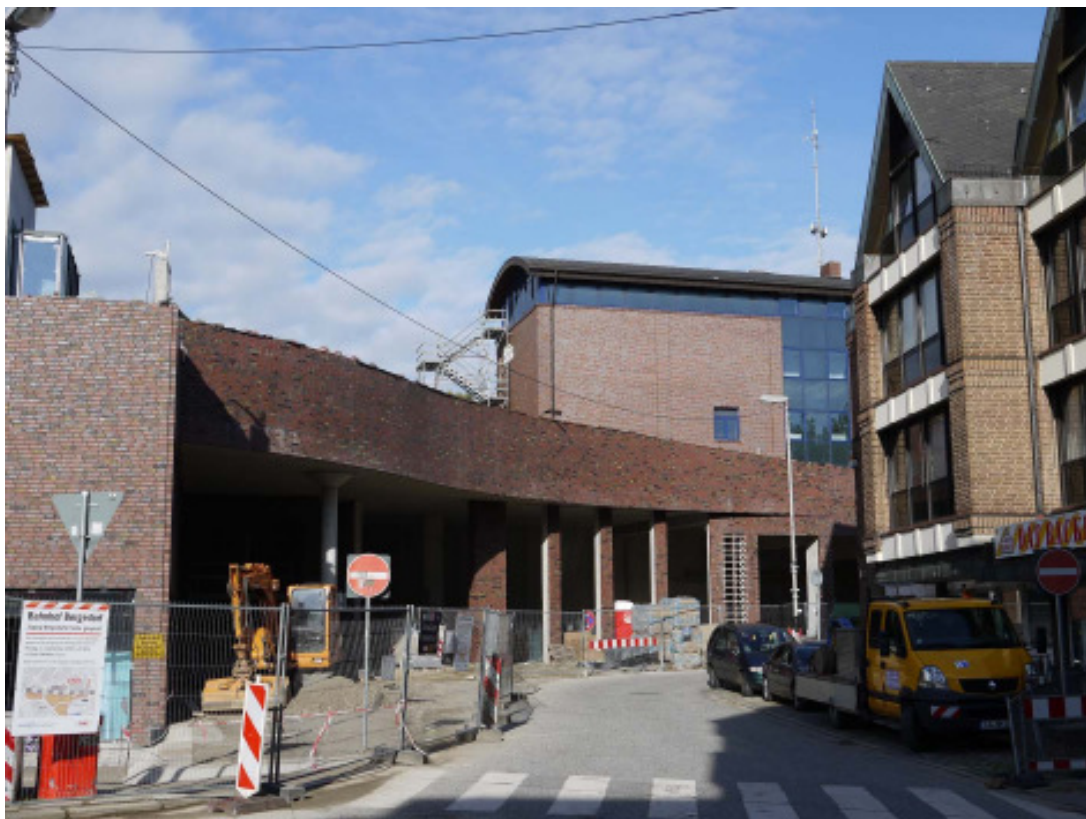
Bild 57: Fahrradstation am Bahnhof Bergedorf im Bau
