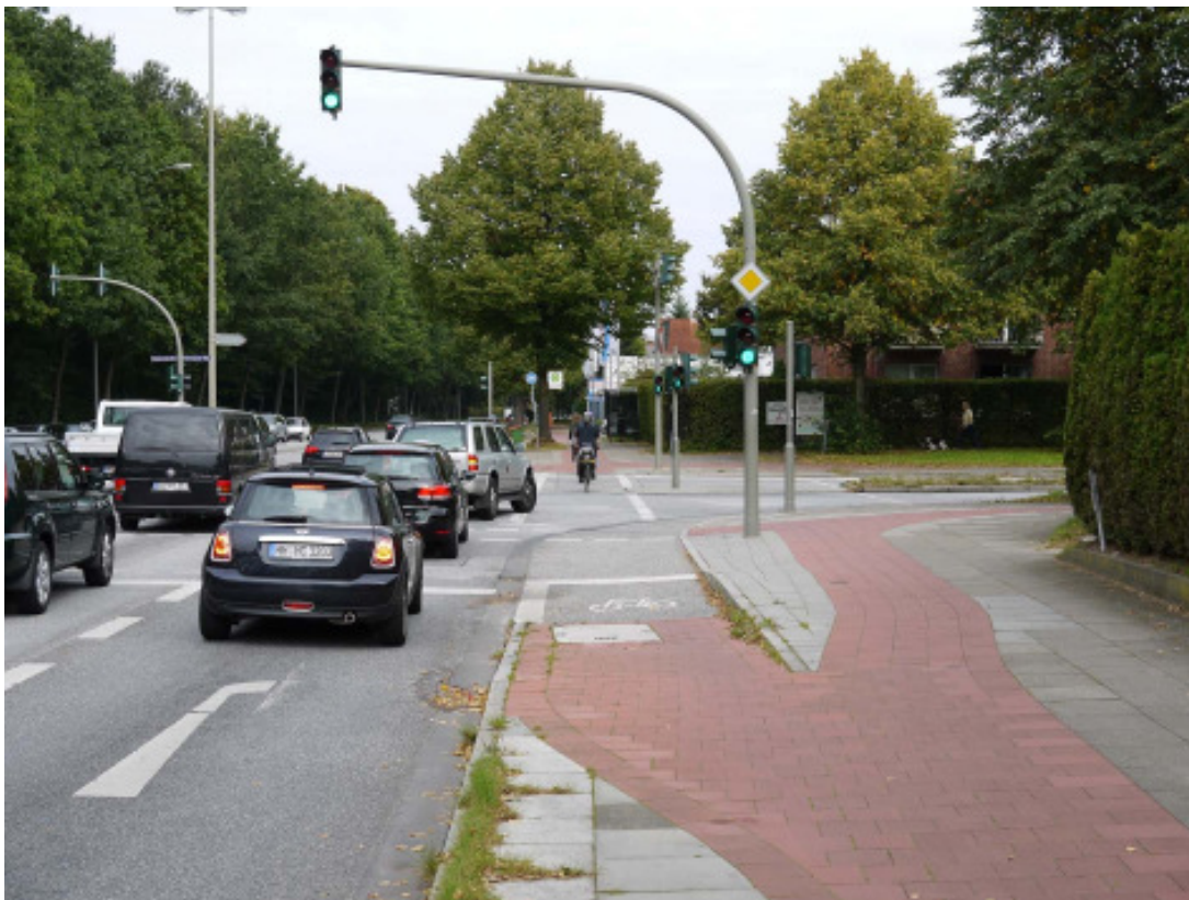
Bild 15: Saseler Chaussee / Farmsener Weg (Veloroute 5), „Berliner Lösung“ für geradeausfahrenden Radverkehr
