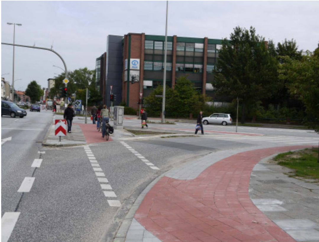
Bild 9: Bramfelder Straße / Krausestraße, Begradigung der Radverkehrsführung an Knotenpunkten (ehemalige Radwegfurt ist am dunklen Asphalt erkennbar)
