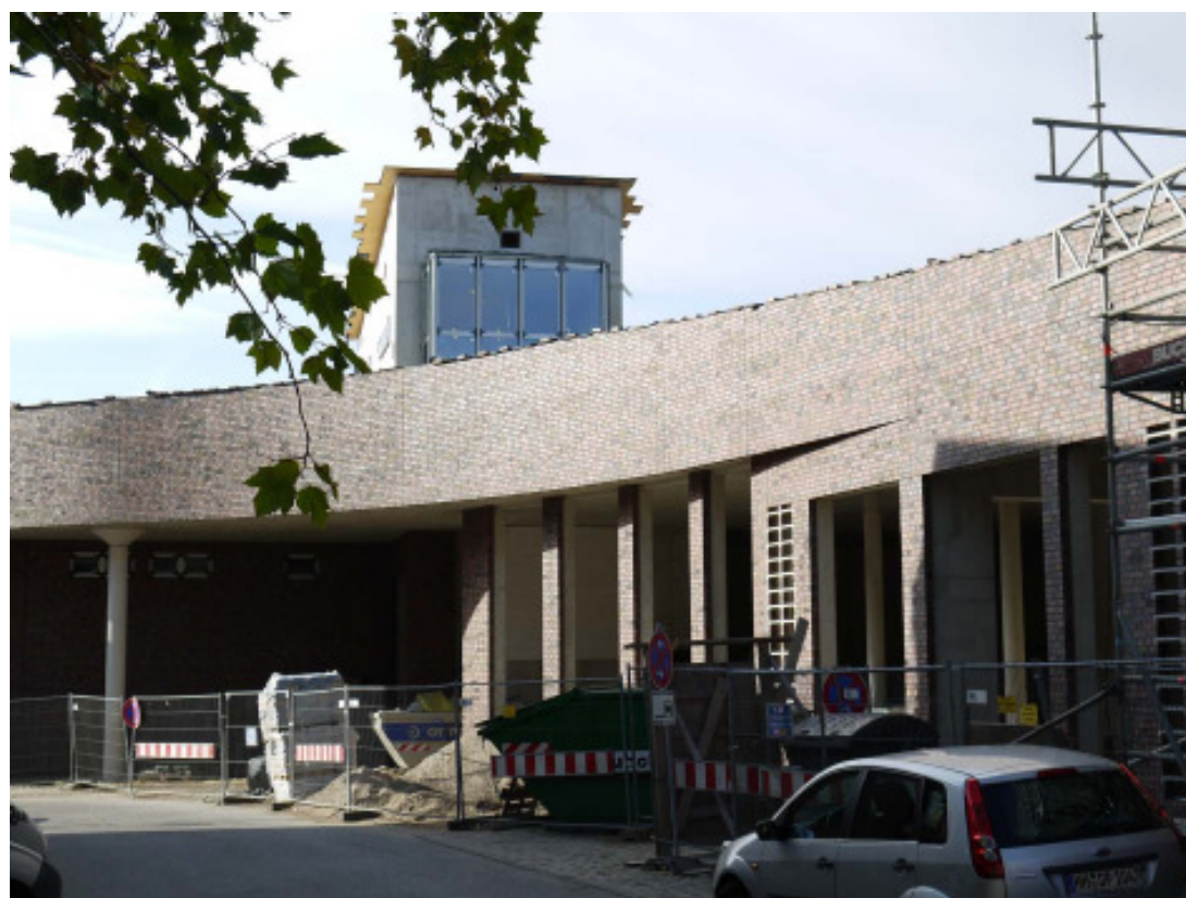
Bild 58: Fahrradstation am Bahnhof Bergedorf im Bau
