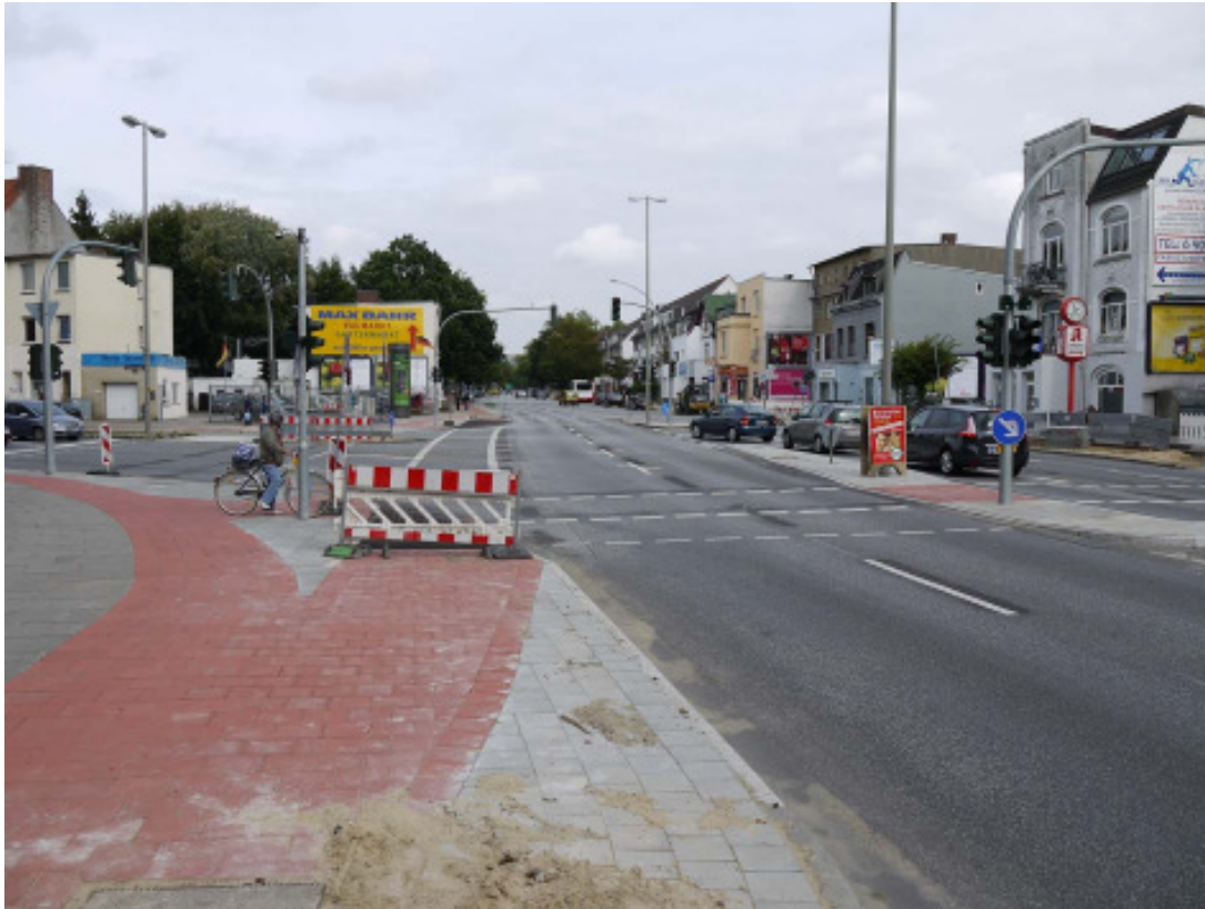
Bild 10: Bramfelder Chaussee / Fabriciusstraße, Begradigung der Radverkehrsführung an Knotenpunkten (im Bau)
