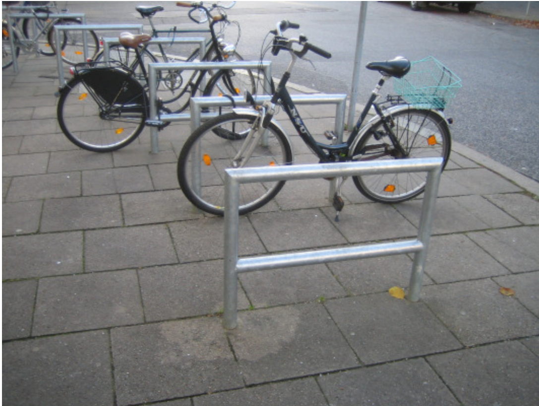
Bild 42: Neue Straße / Sand, neue Fahrradbügel im Rahmen des 1.000-Bügel-Programms (teilweise mit Querholm für Kinderräder)
