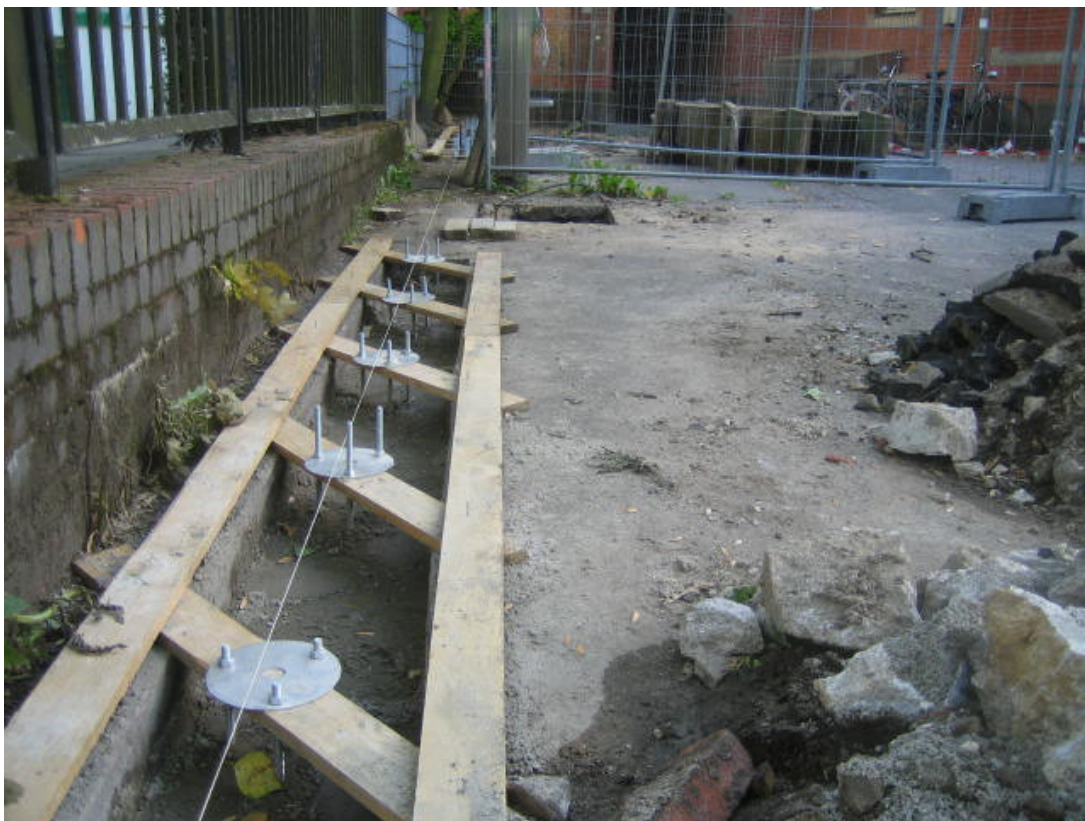
Bild 50: Uhlandstraße, Bau der StadtRAD-Station am U-Bahnhof Uhlandstraße
