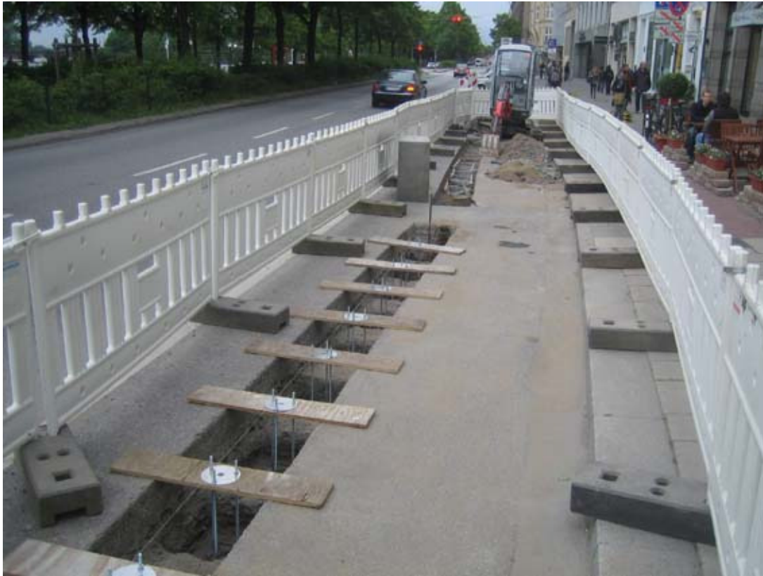
Bild 49: Ballindamm, Bau der StadtRAD-Station am S-/U-Bahnhof Jungfernstieg
