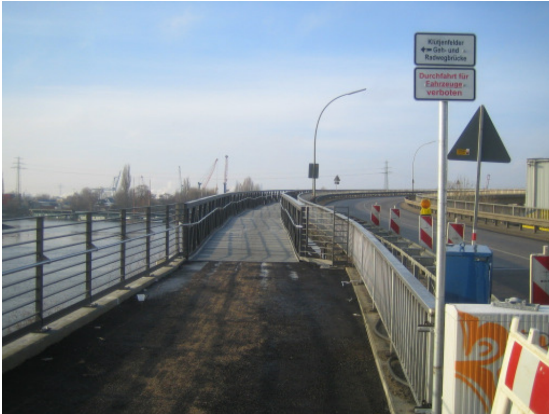
Bild 28: Klütjenfelder Geh- und Radwegbrücke (Veloroute 11)
