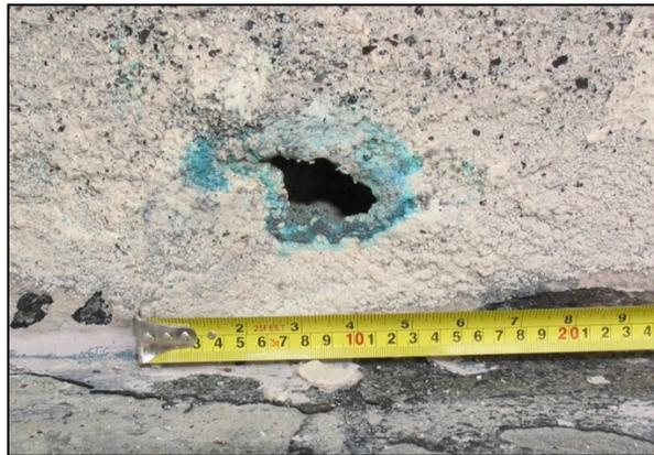
Abbildung 32: Weitere Durchrostung im unteren Bereich des Schotts
