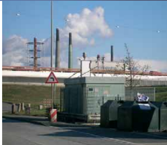
Messstation Veddel, Hintergrundmessstation mit industriellem Einfluss
