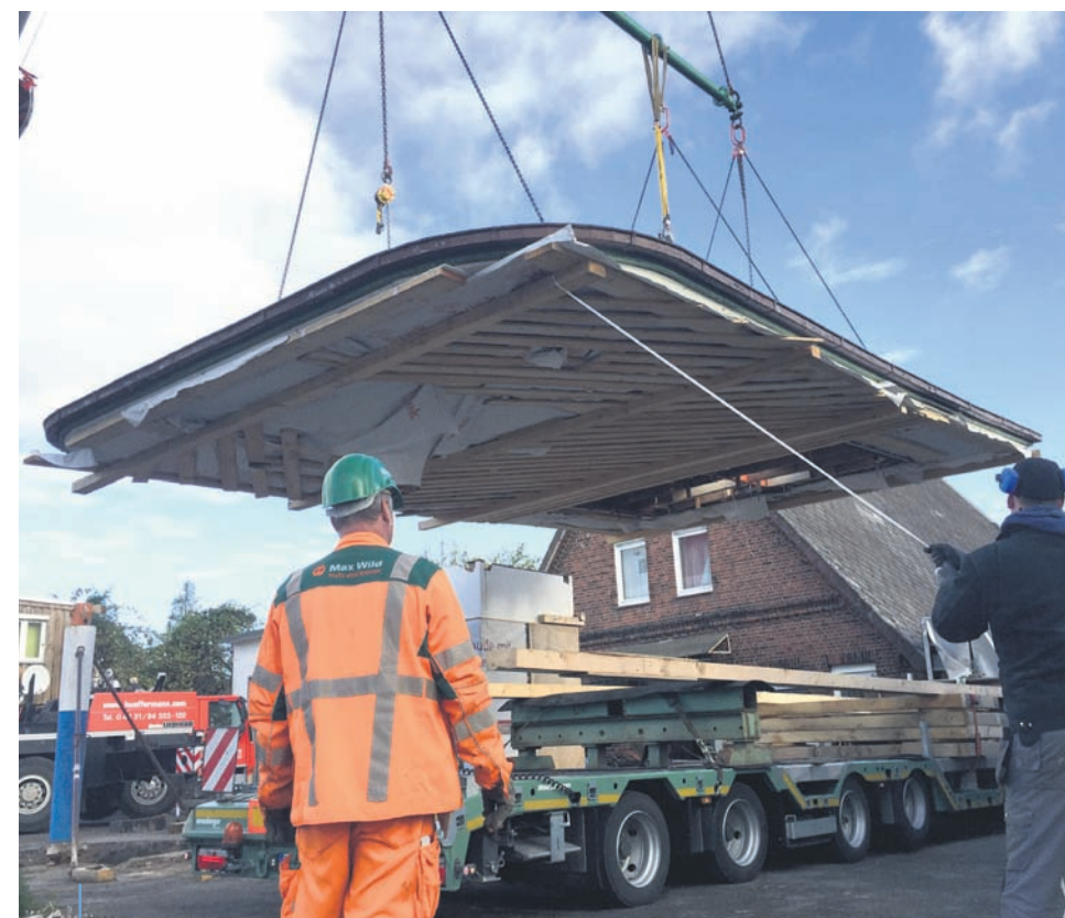
Translozierung der Tankstelle aus Stade: Das Flugdach schwebt auf den Tieflader.
