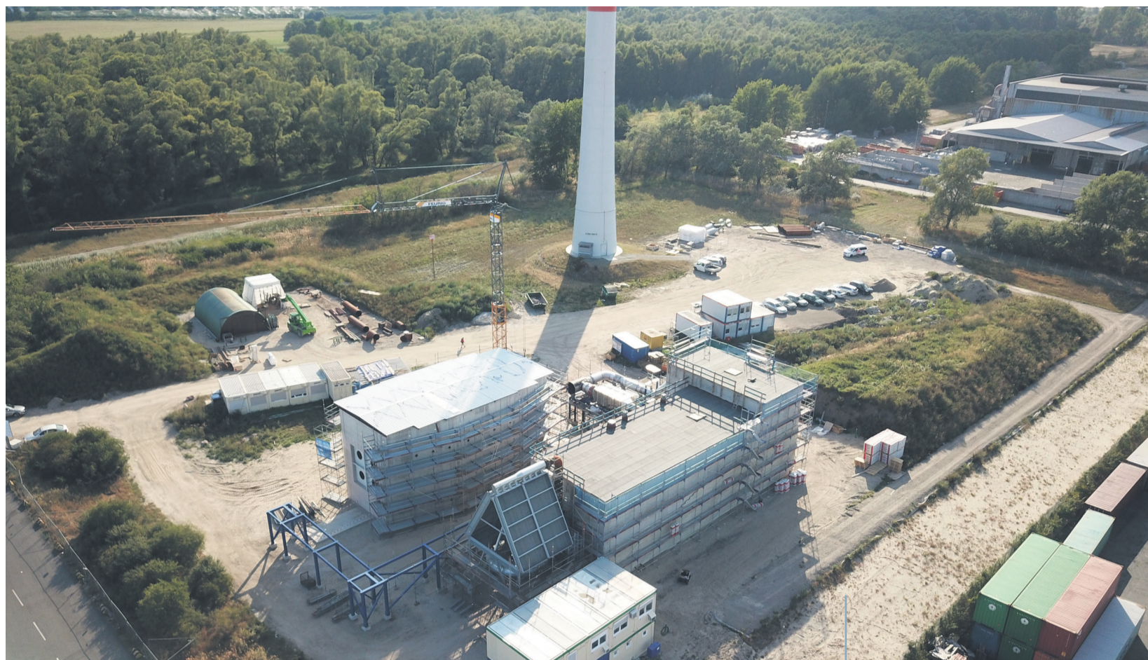
Die Baustelle auf dem Gelände der Aluminiumhütte in Altenwerder: Hier entsteht ein Steinspeicher-Prototyp mit Rückverstromung.
