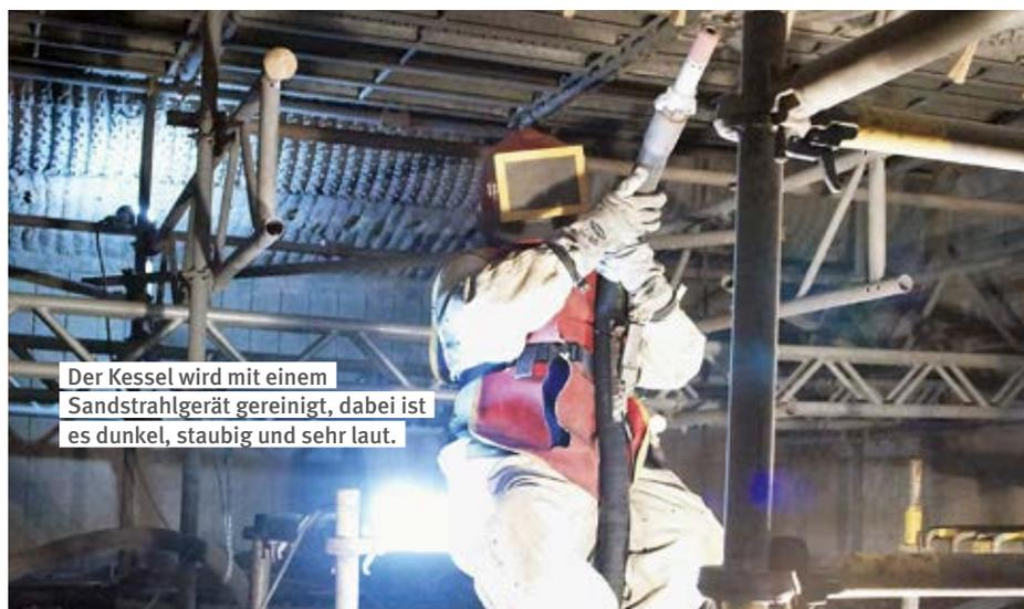
Der Kessel wird mit einem Sandstrahlgerät gereinigt, dabei ist es dunkel, staubig und sehr laut.
