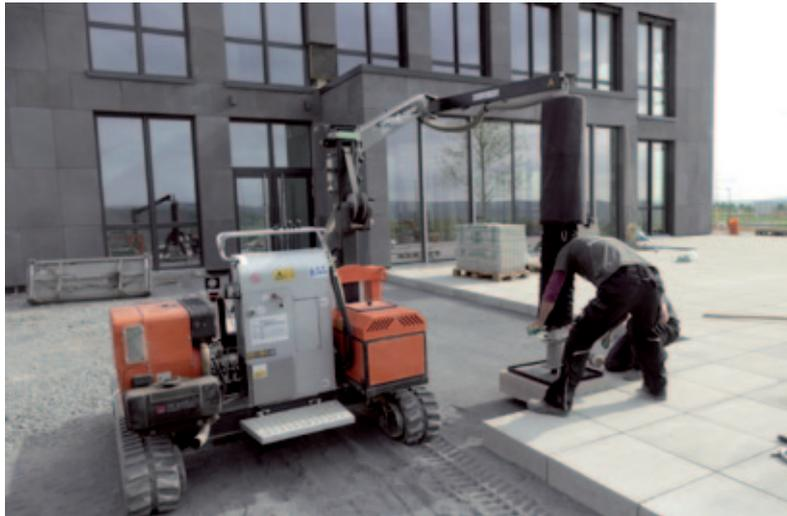
Das Optimas Vacu-Pallet-Mobil verbindet Materialtransport und leichtes Materialhandling durch die Vakuum-Schlauchbetetechnik. (Foto: Optimas GmbH)
