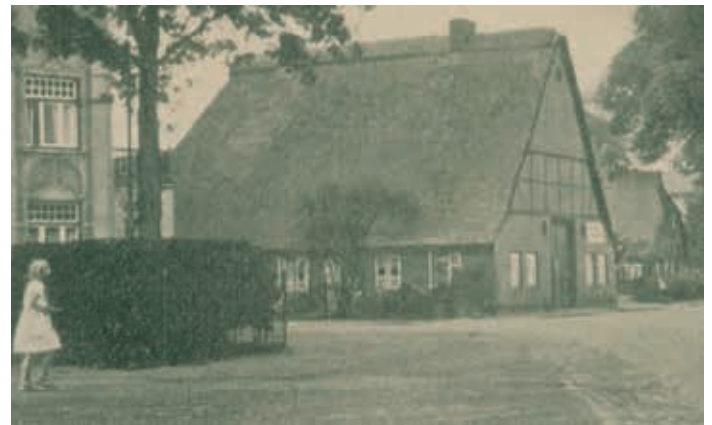
Bild 3. Des Fuhrunternehmers Jonny Langeloh umfunktionierte Scheune
