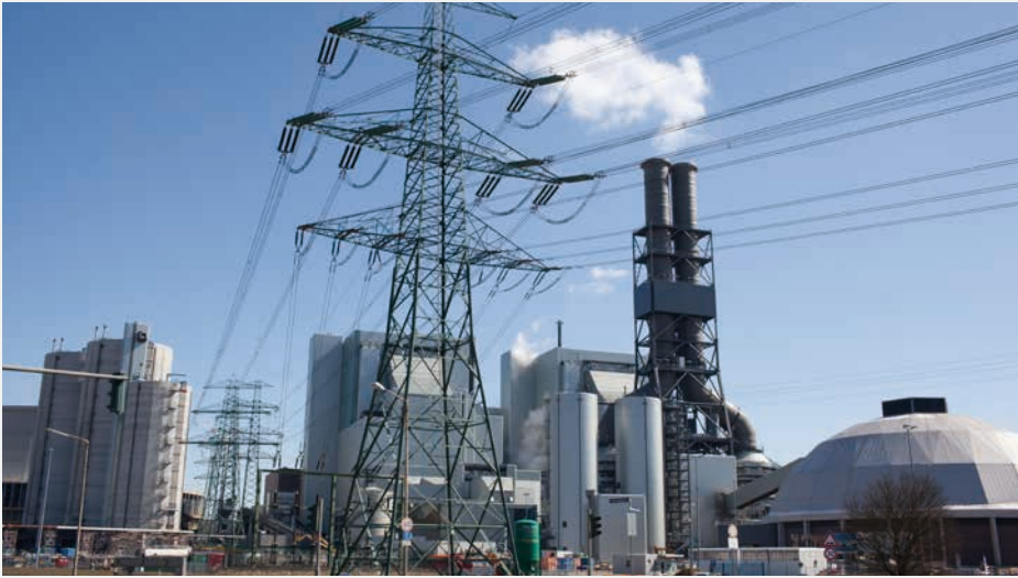
Das Kraftwerk Moorburg
