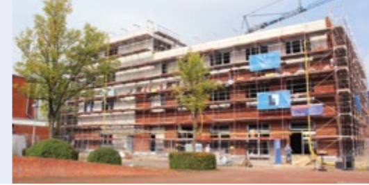
Richtfest an der Beruflichen Schule Anlagen- und Konstruktionstechnik (BS 13) auf dem „Elbinsel-Campus“
