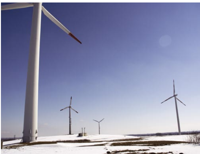
Windräder auf der Deponie in Georgswerder
