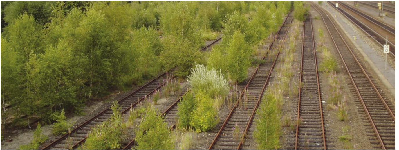
Industriebahnhof: Die Natur erobert sich Flächen zurück, die der Mensch nicht mehr nutzt
