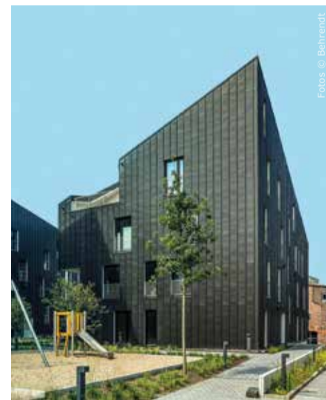
Behrendt: fertiggestellter erster Bauabschnitt
