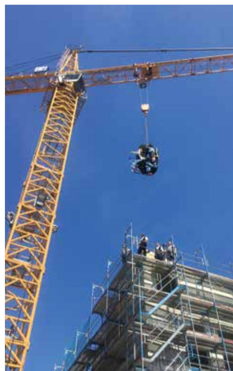
Quartier 319: die Richtkrone über dem Neubau
