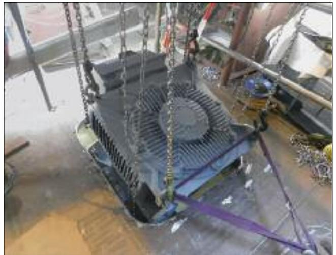
**Passgenau:** Einer von zwei 330 kW starken Elektromotoren für den Antrieb wird durch ein enges Luk gehievt
