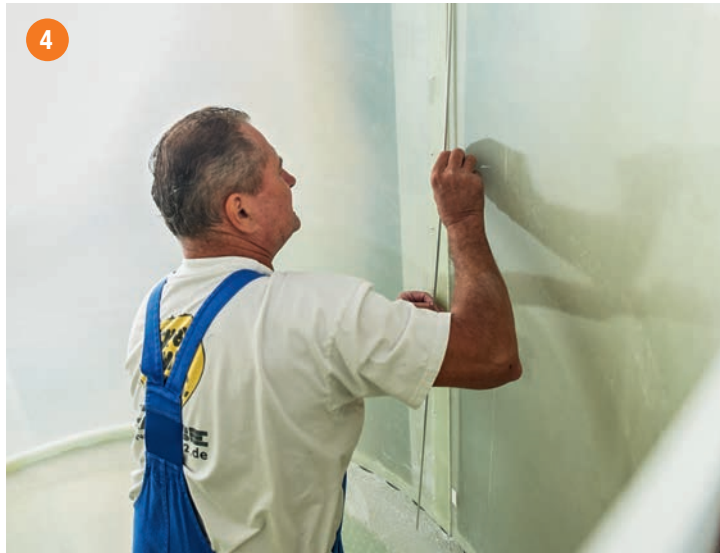
Installation der Überwachungsleitung für die Vakuum-Leckanzeige.
