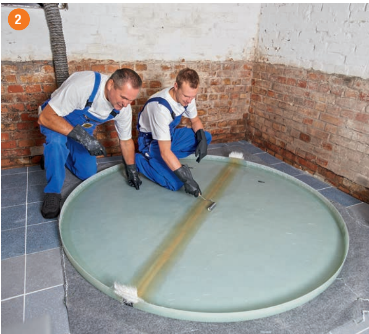
Positionieren und Zusammenfügen der äußeren Bodenplatte mittels Glasfaservlies und Polyesterharz.
