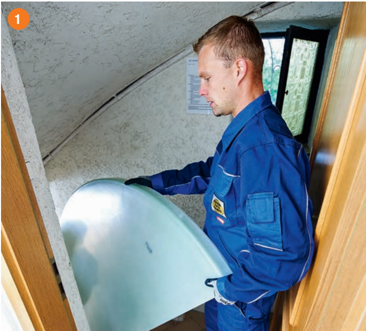
Alle Bauteile des GFK-Tanks können in der Regel problemlos zum Standort gebracht werden. Enge Zugänge und niedrige Deckenhöhe sind von daher kein Hindernis.
