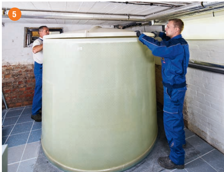
Der Behälterdeckel mit Mannloch wird platziert und anlaminiert.
