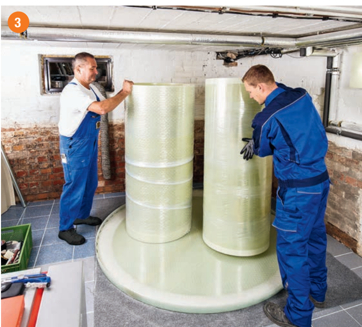
Die Innen- und die Außenwand werden dauerhaft mit den beiden Böden verbunden und bilden so gemeinsam den Kontrollraum, der bei den doppelwandigen Haase-Tanks permanent überwacht wird.
