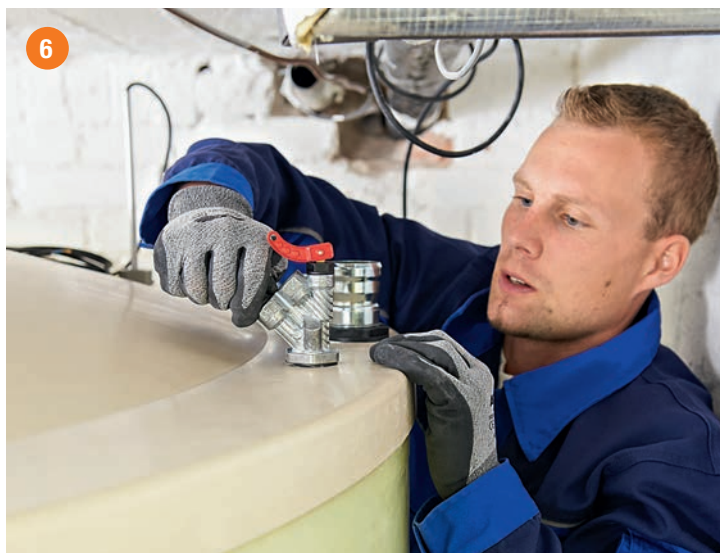
Anbringen der Anschlüsse für Füllleitung, Entlüftung und Grenzwertgeber.
