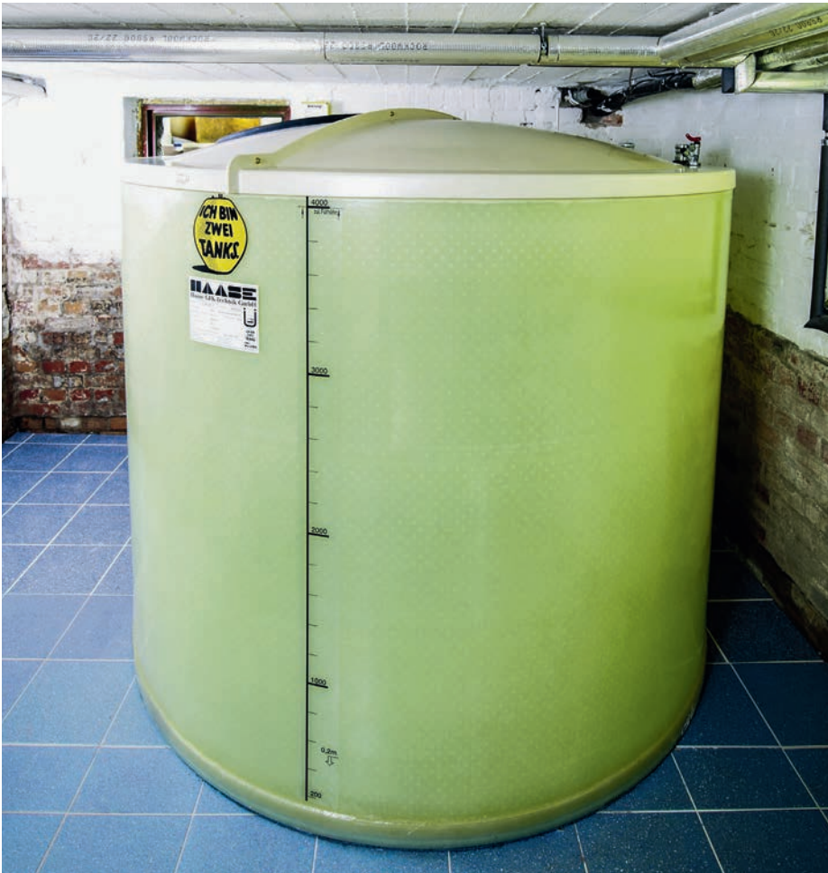
Am Standort gefertigt: neuer, doppelwandiger GFK-Tankbehälter mit 4.000 Liter Fassungsvermögen. Nach der Installation von Füll- und Entlüftungsleitung, Grenzwertgeber und Leckanzeiger ist der Tank zur Abnahme durch den Sachverständigen bereit.
