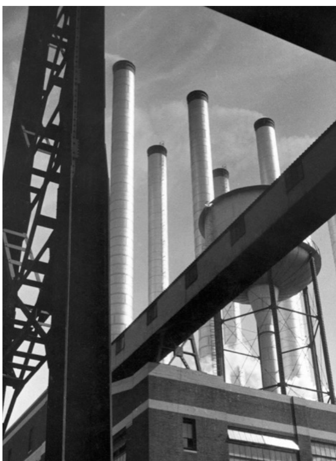
Bild 12: Kraftwerk der Ford-Fabrik Detroit 1943
