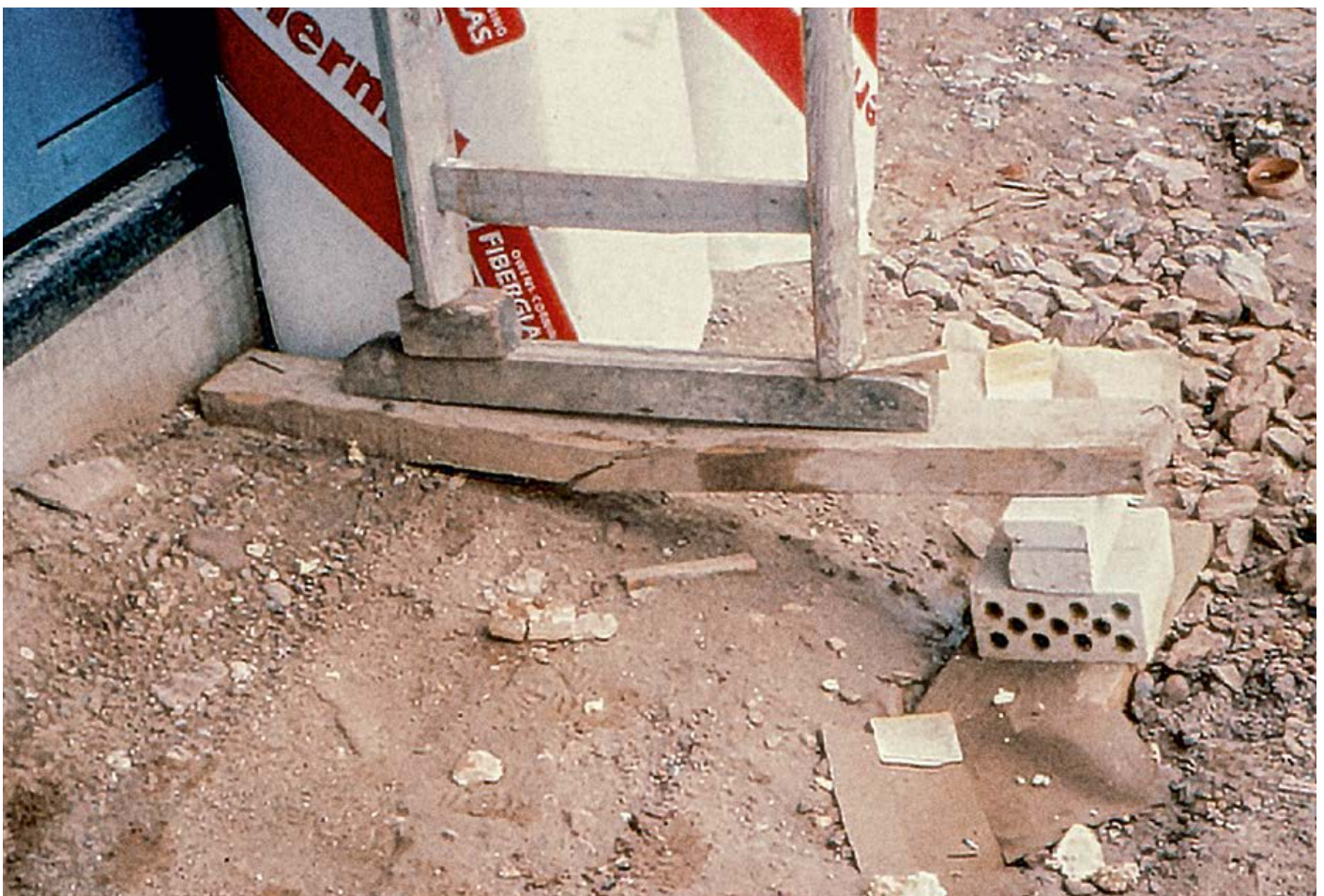
Mangelnde Standfestigkeit von Leitern und Gerüsten führt oft zu schweren Unfällen.
