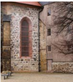
Beginn der Restaurierung des polygonalen Chors nach der Drainage zur Austrocknung des Sockelmauerwerks
