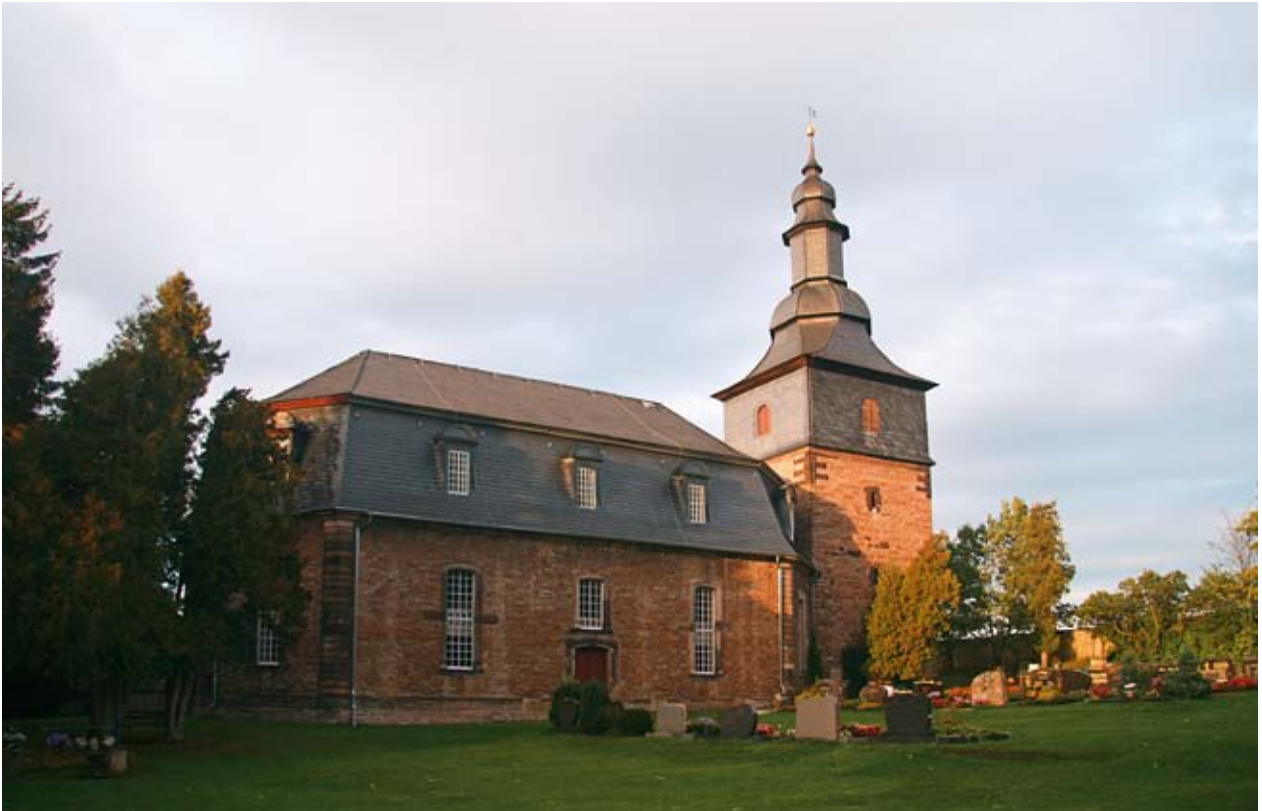
Kirche St. Petri in Erfurt-Büßleben: Blick von Süden auf die Kirche mit dem mächtigen Mansarddach und dem Turm im Osten
