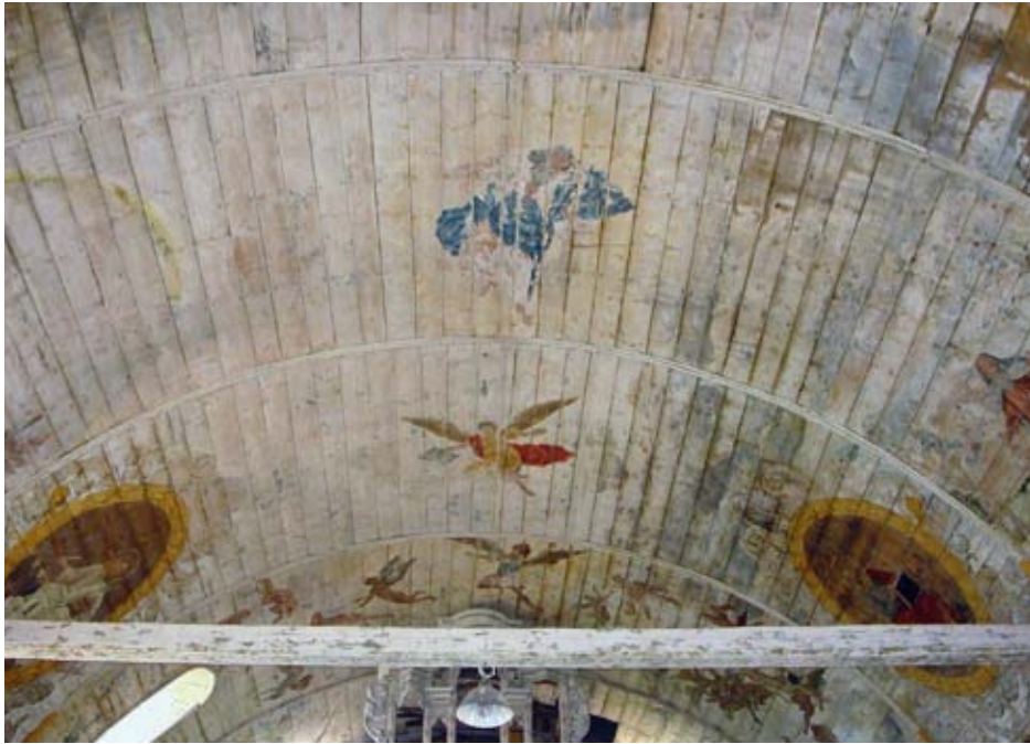
Kirche St. Nikolai in Bösenrode: Tonnengewölbe mit barocker Malerei, frühes 18. Jahrhundert
