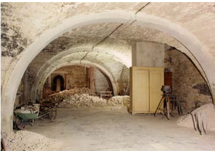
Naumburger Domschatzgewölbe vor und nach der Restaurierung 2006
