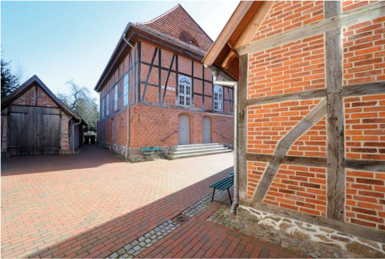
Alte Synagoge in Hagenow: Gesamtensemble mit Bethaus, Gemeindehaus und Remise für den Leichenwagen
