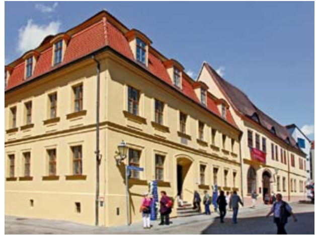
Das Händel-Haus nach Ab- schluss der Sanierungsarbeiten an Dach und Fassade 2009
