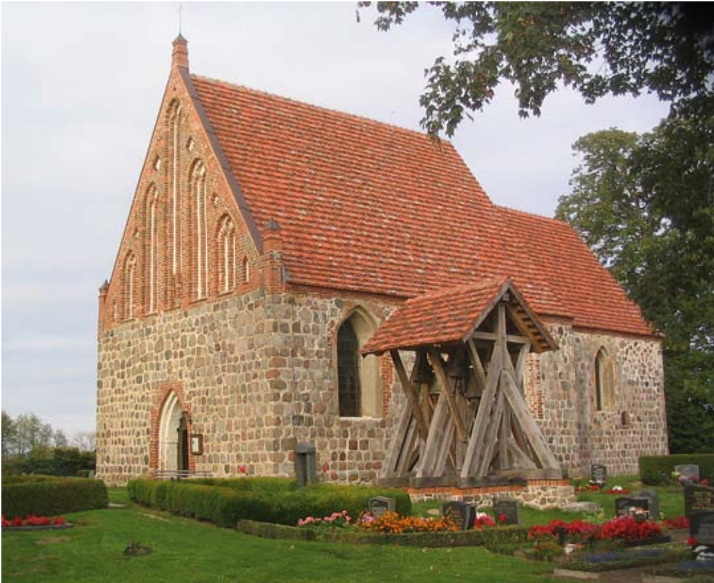
Die Feldsteinkirche St. Nikolai zu Bauer aus dem 13. Jahrhundert mit eingezogenem Chor, Backsteinblendgiebel und Kirchturm
