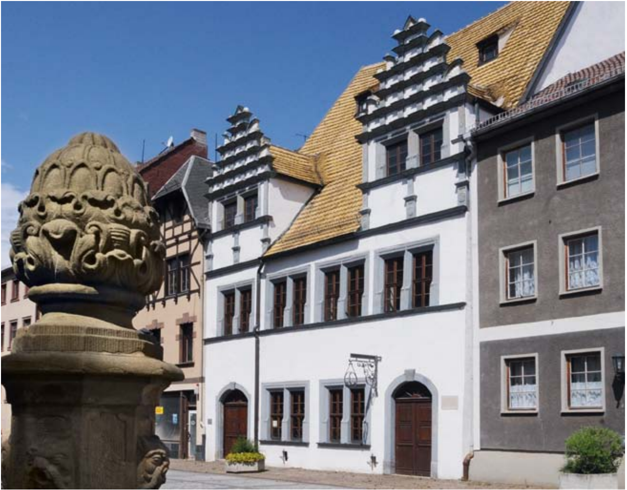
Die Fassade des Heinrich-Schütz-Hauses in der Nikolaistraße in Weißenfels
