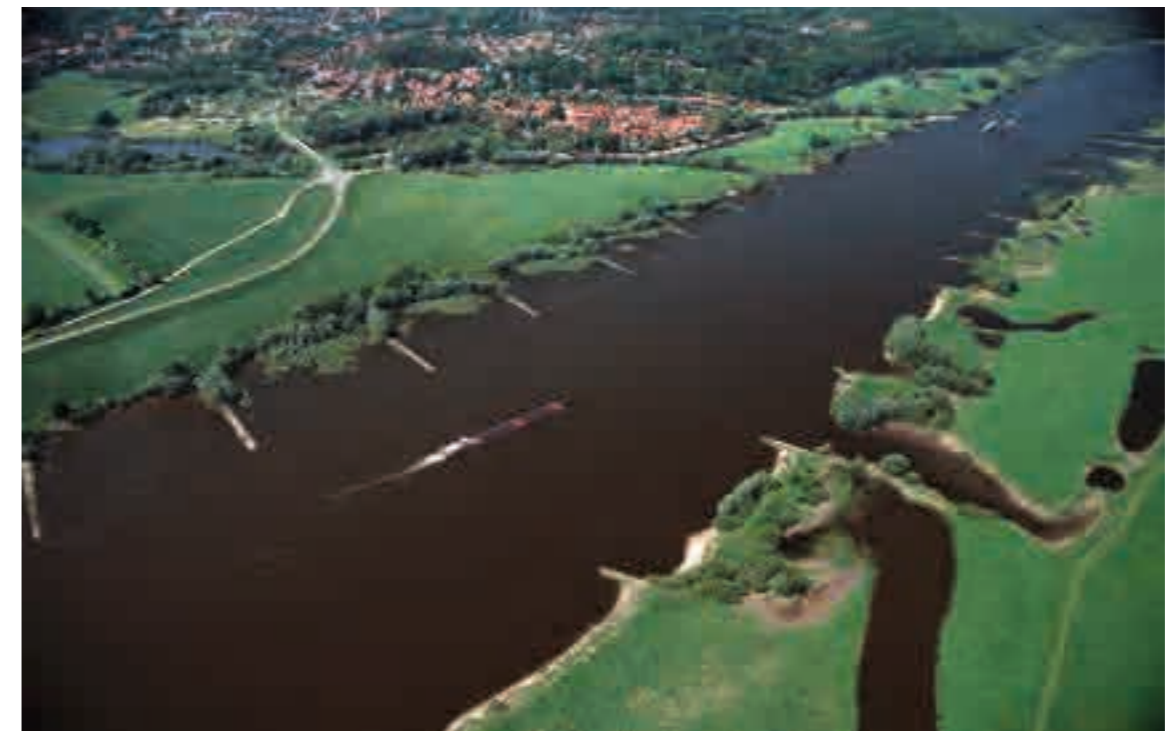
4.3 > Für die Unterhaltung und die Sicherheit der Bundeswasserstraßen wie hier der Elbe ist das Bundesministerium für Verkehr und digitale Infrastruktur zuständig. Die Deiche, die das Hinterland schützen, werden hingegen von Deichverbänden gepflegt.
