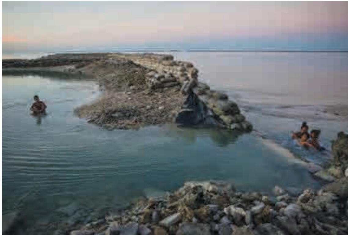
4.14 > Der Inselstaat Kiribati bemüht sich, seine flachen Atolle teils durch massive Mauern vor dem Meer zu schützen. In vielen Fällen aber zerstören Sturmfluten die Bauwerke, wie hier vor der Hauptstadt South Tarawa.
