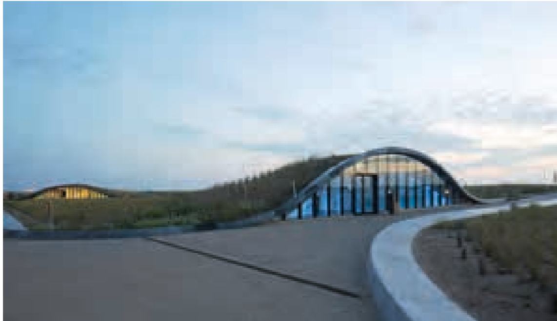
4.27 > Im niederländischen Katwijk aan Zee wurde ein Parkhaus parallel zur Uferstraße gebaut und anschließend mit Sand bedeckt, sodass eine künstliche hohe Düne entstanden ist.
