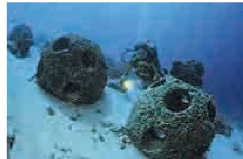
4.24 > Sogenannte Riffbälle als Wellenbrecher. Die von einer US-amerikanischen Nichtregierungsorganisation vertriebenen Kugeln werden für den Küstenschutz eingesetzt. Sie bilden zugleich wertvolle Unterwasserlebensräume.
