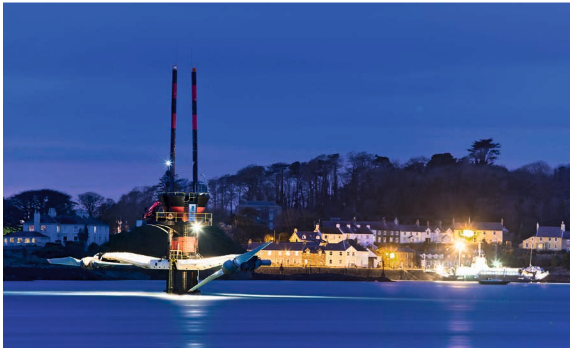
4.15 > Das Gezeitenkraftwerk SeaGen in der Meerenge von Strangford, Nordirland, hat eine Leistung von 1,2 Megawatt. Es liefert so viel Strom wie eine kleine Windenergieanlage. Dieses Gezeitenkraftwerk ist insofern ungewöhnlich, als dass es Energie mittels Rotoren gewinnt. Üblicherweise arbeiten Gezeitenkraftwerke mit Turbinen, die in einem Sperrwerk installiert sind.
