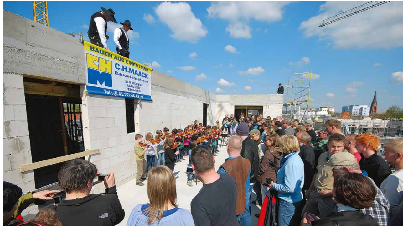
Die Baugemeinschaft StadtSchule – hier beim Richtfest – hat sich rechtlich abgesichert
