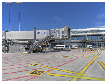
▲ Neue Markierung und sanierte Fluggastbrücke im Bauabschnitt 5 (Foto: Michael Penner)
