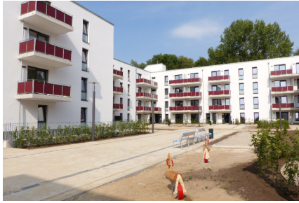
▲ Quartier Ohkamp / Flughafenstraße 64-82
