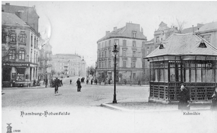
Blick in Richtung Kuhmühlenbrücke, 1916
