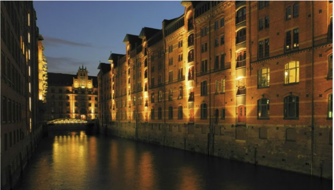
Romantisch, aber vielfach marode: Die Kaimauern der Speicherstadt. Foto: Jürgen Petersen.
